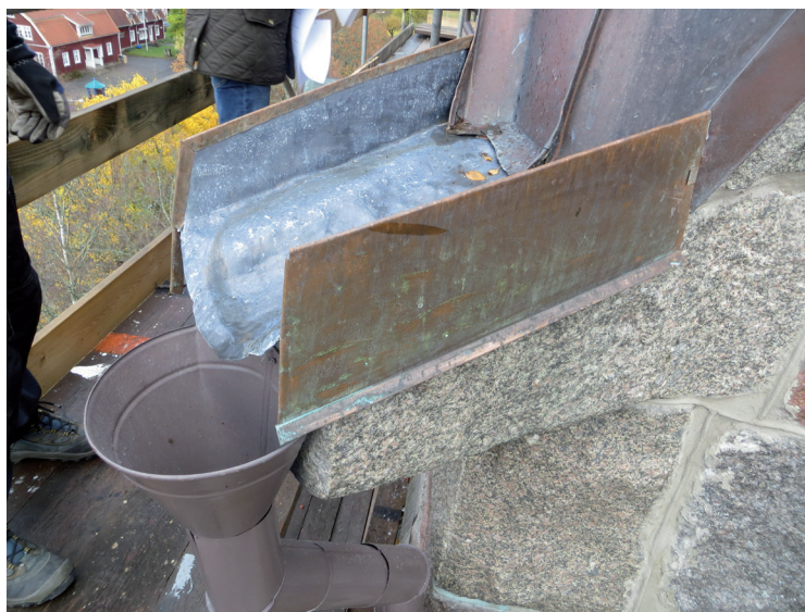
Ovan: Huvudentrén med en port som sekundärt klätts med ekpanel som fernissats. Nu gavs tillstånd till att täckmåla portarna i samma kulör som fönstren. Till höger: En av tornets utkastare som kompletterats med en djupare ränna och ett stuprör under.
