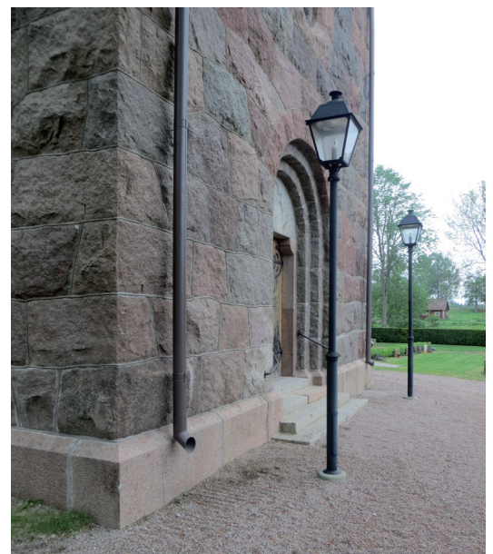
Tornets västsida vid slutbesiktningen med nytt stuprör. Porten är ännu inte ommålad med täckfärg.
