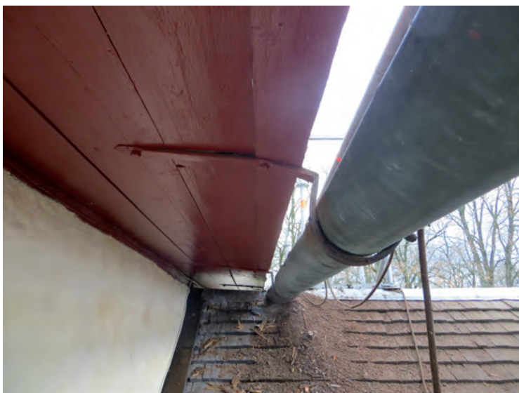
Ovan: Sedan tidigare fanns det en plåt vid övergången från sakristians tak till långhusets väggputs. Denna byttes ut i samband med arbetena. Till vänster: Takfoten med hängrännan som fick justeras för att erhålla lämpligt fall mot stuprören. Krokarna behölls men justerades.
