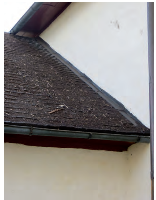
Ovan: Sedan tidigare fanns det en plåt vid övergången från sakristians tak till långhusets väggputs. Denna byttes ut i samband med arbetena. Till vänster: Takfoten med hängrännan som fick justeras för att erhålla lämpligt fall mot stuprören. Krokarna behölls men justerades.
