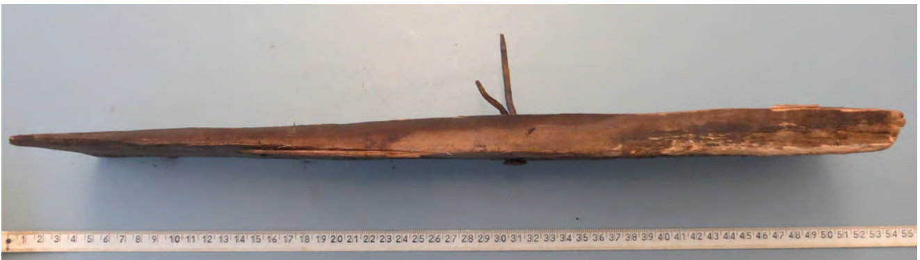
Tillvarataget spån nr 2: Sida med dubbel spikning med två smidda spikar.
