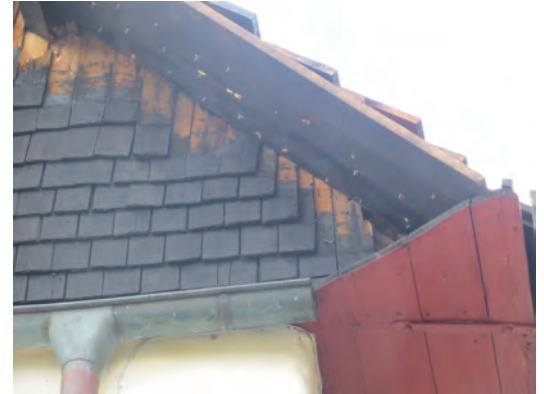
Ovan: Takytan sänktes i samband med arbetena och detta påverkade spånbeklädnaden på gavelröstena. Till vänster: Dessa lister placerades under det nedersta spånvarvet för att skapa luftning.
