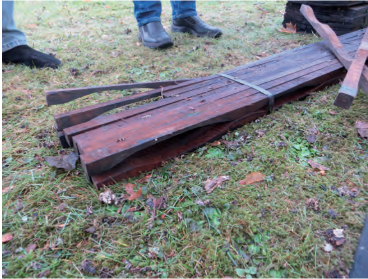
Ovan: Takytan sänktes i samband med arbetena och detta påverkade spånbeklädnaden på gavelröstena. Till vänster: Dessa lister placerades under det nedersta spånvarvet för att skapa luftning.
