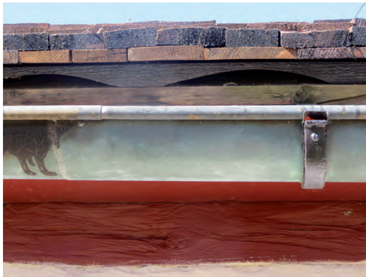
Ovan: En underslagsbräda har fått bytas ut mot en ny. Till höger: Takfoten med listen som möjliggör luftning under spånen.
