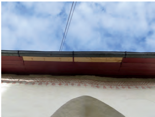
Ovan: En underslagsbräda har fått bytas ut mot en ny. Till höger: Takfoten med listen som möjliggör luftning under spånen.
