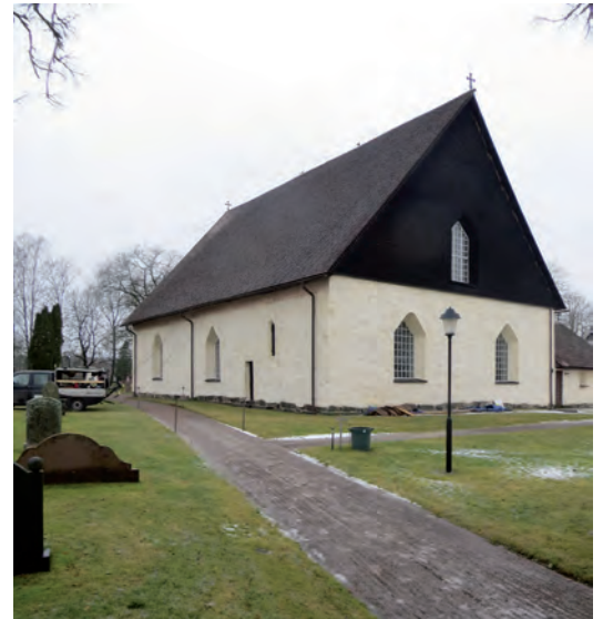
Norra Sandsjö kyrka inför arbetena. Vy från sydost.
