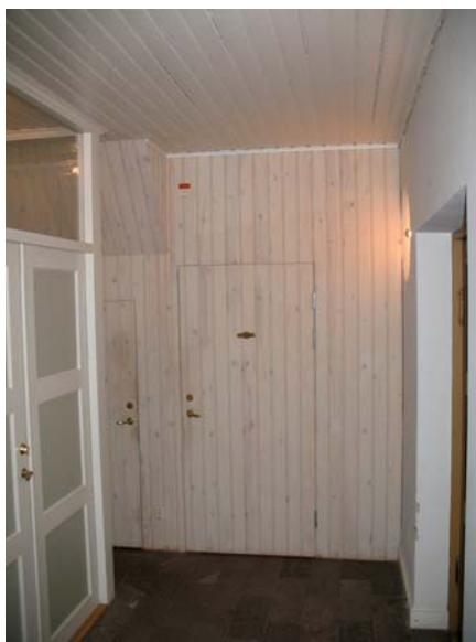
Vapenhuset med i sen tid inredda toalett- och städutrymmen.
