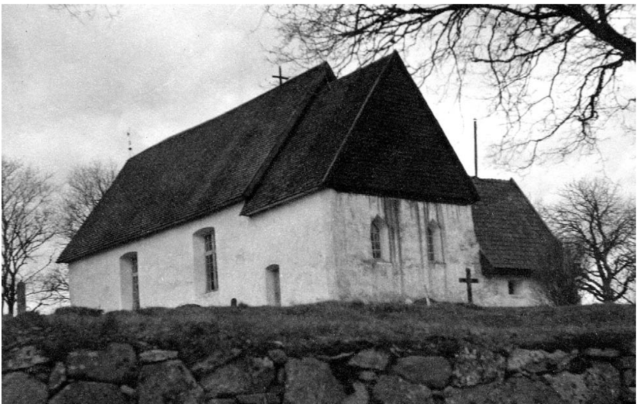
Järsnäs kyrka sedd från sydost inför ombyggnaden 1905-06. (JLM)
