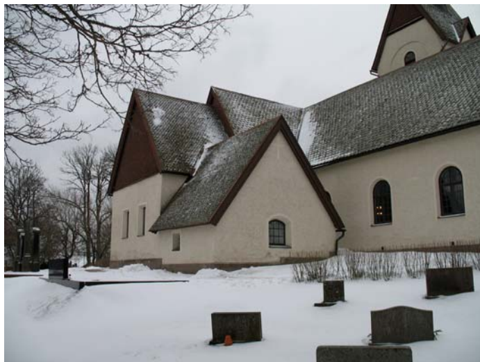
Genom att jämföra med äldre bilder ser man att fönsterform och -format ändrades vid ombyggnaden 1905-06. Gavelfönstret hitåt var tidigare runt och gavelfönsterna till vänster hade spetsig avslutning uppåt.
