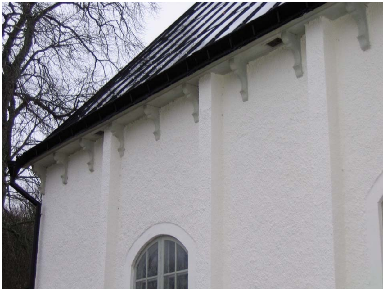
Kyrkans takfot med konsolerna från 1892 års restaurering. Bilden visar även nykyrkans vertikala följare som stabiliserar timmerstommen.
