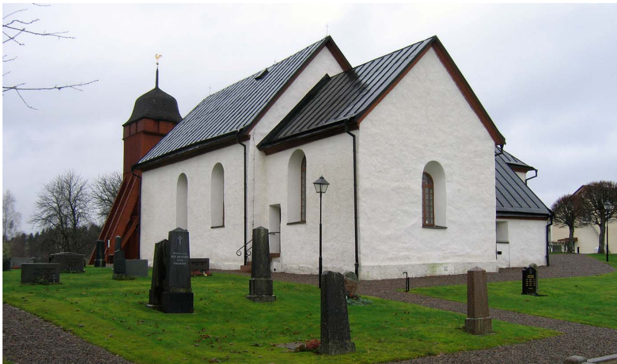
Kyrkobyggnaden sedd från sydost. Närmast syns koret med absiden som för ovanlighetens skull inte har en halvrund exteriör.
