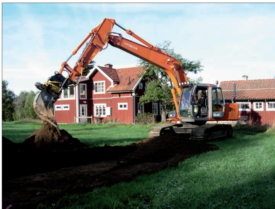
FIGUR 21. Bild från schaktningsarbetet inom norra delen av förundersökningsområdet. På bilden syns grävmaskinist David Bringevik i full färd med att ta bort matjordslagret. Foto: Håkan Hylén.
