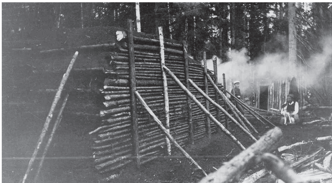
FIGUR 18. Nytänd liggmila i Bjurfors, Västmanland 1916. På bilden ses den konstruerade väggen, balkron, tydligt. Just denna liggmila stöttades upp med snedställda stöttor. Från Skogsbibliotekets bildarkiv, negativnr 13673.
