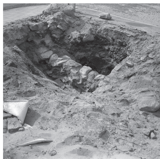
FIGUR 6. Anläggning 4 från nordost.
