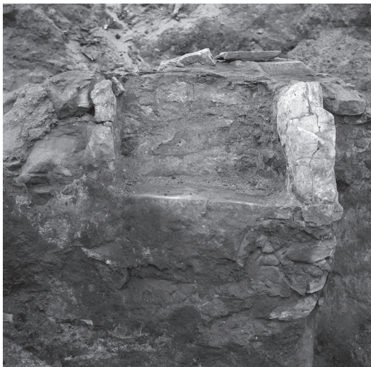
FIGUR 22. Konstruktionsdetalj i den östra muren, troligen en lyktisch. Från väster.
