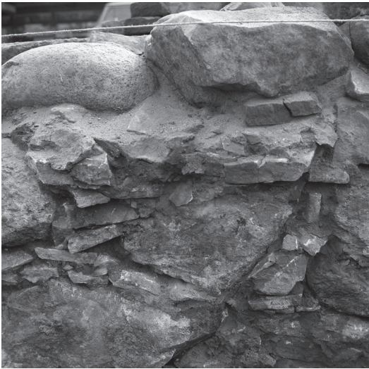
FIGUR 17. Del av anläggning 3:s södra mur. Observera de rundade syllstenarna från 1791 års byggnad. Från norr.
