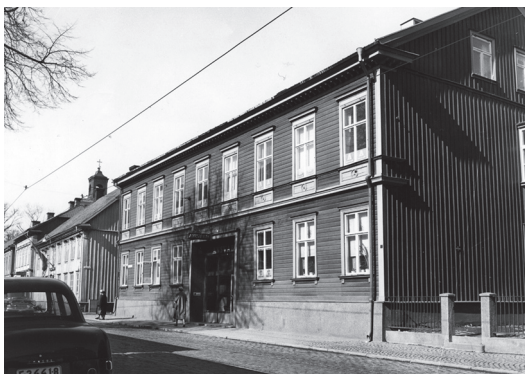
FIGUR 14. Gathuset vid Östra Storgatan 51. Byggnaden uppfördes år 1791.
