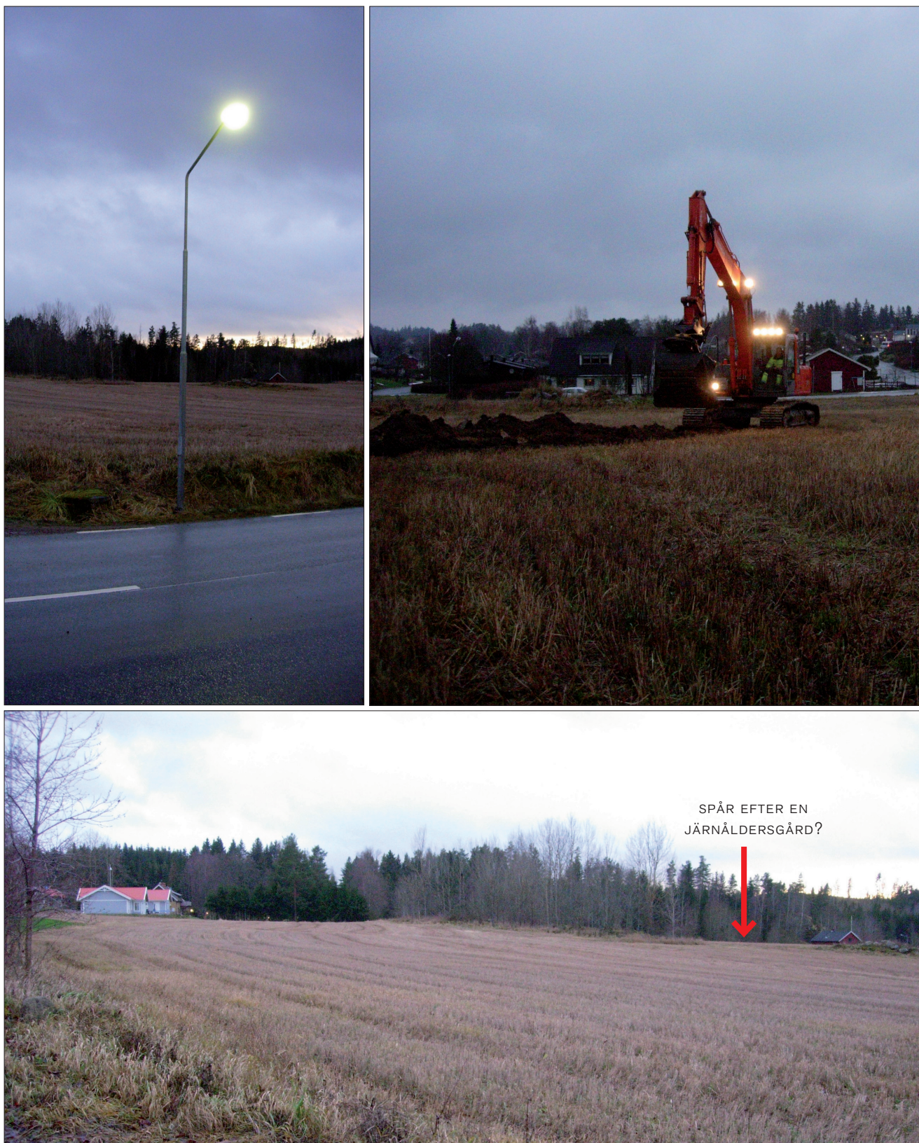
FIGUR 4-6. Bilden överst till vänster är tagen vid besiktning av området inför schaktning. Bilden intill togs i samband med schaktningsarbetet, som utfördes med hjälp av David Bringevik, Tabergs Entreprenad AB. I bakgrunden syns delar av samhället i Ölmstad. På nedersta bilden syns stora delar av utredningsområdet (fr nordöst). Avsatsen med de påträffade anläggningarna som sannolikt utgör spåren efter en järnåldersgård är markerad med en pil. Foto: Håkan Hylén, Jönköpings läns museum.
