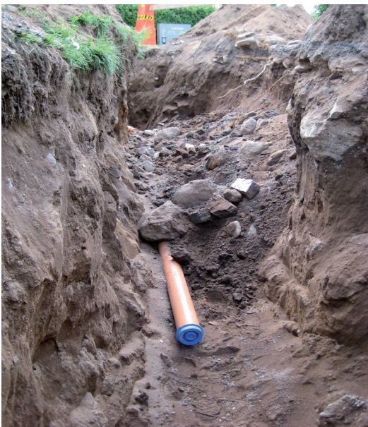
FIGUR 12. Schaktets kanter rasade vid flera tillfällen. Foto: Anna Ödeén.
