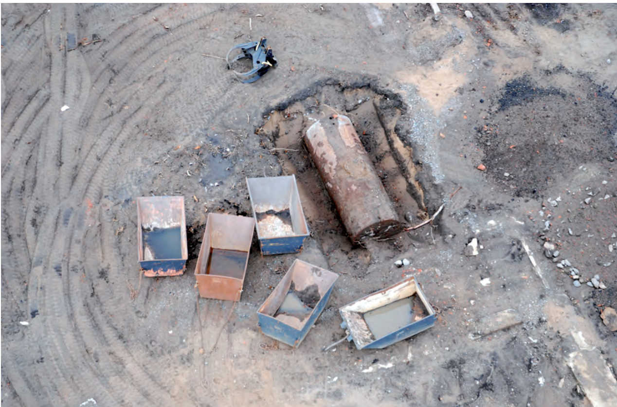
FIGUR 20. (Överst) Tätgjutet pannrum från mitten av 1900-talet. FIGUR 21. Oljetank till pannrummet.
