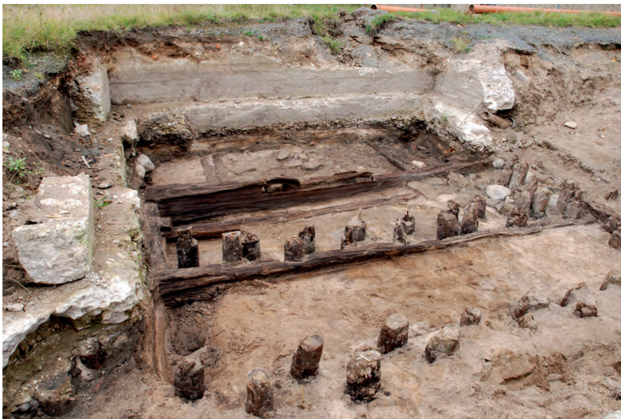
FIGUR 22. Tät pålning till 1906 års grundmurar. Pålarna perforerar 1600-talets bebyggelselämningar i tomt 208.
