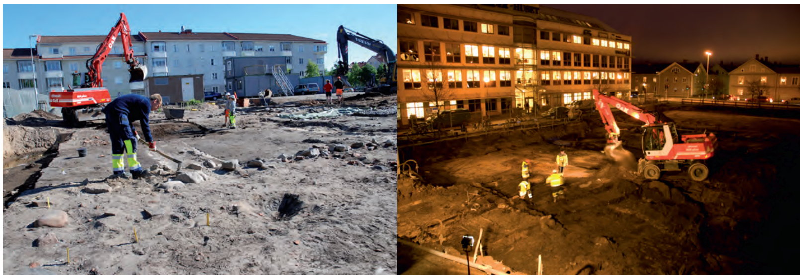
FIGUR 17. (Vänster) Maskinschaktning under gynnsamma förhållanden. (Höger) Mörkerschaktning
