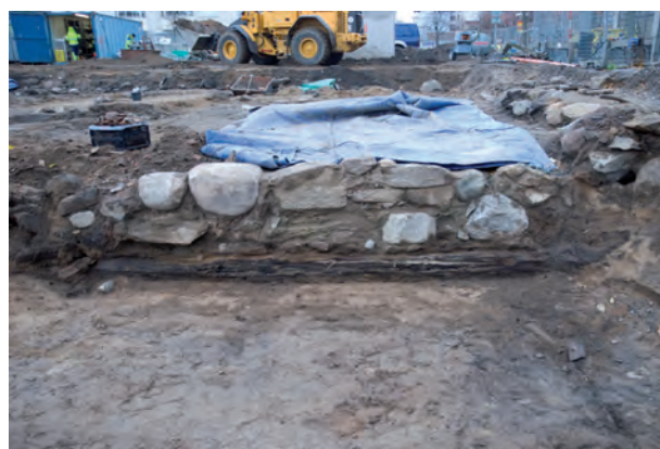
FIGUR 88. Fullstensgrund. Passande för stora, tunga byggnader.
