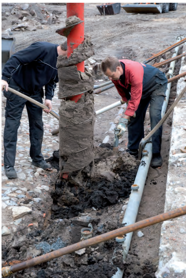
FIGUR 14. Borrning för wellpointspetsar.
