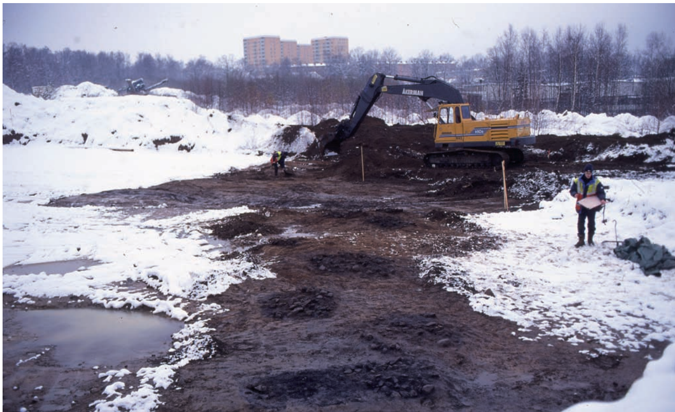
FIGUR 3. Framschaktning av anläggningarna. I förgrunden syns några av härdarna. Foto: M Nordström.
