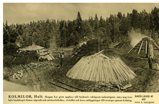
FIGUR 3. Vykort med resmilor i olika faser. Trä staplas i en kon och övertäcks med torv innan det antänds. JLM 96/1:10802.
