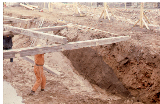
FIGUR 17. Södra kanten av yttre vallgraven från NNO. Dia nr 283.
