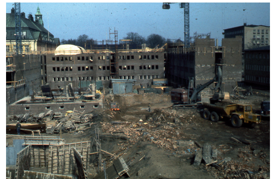
FIGUR 23. Undersökningsområdet vid fängelset 1974. I bakgrunden pågår byggandet av de statliga verksbyggnaderna (idag Skogsstyrelsen och Jordbruksverket). Dia nr 310.
