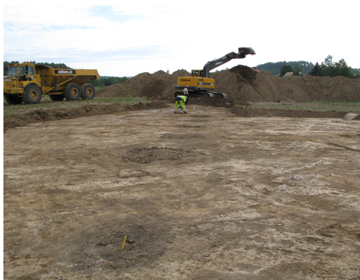
FIGUR 2. Vid schaktningen framträdde en 64 meter lång rad med hårdgropar. Foto: Jenny Ameziane.
