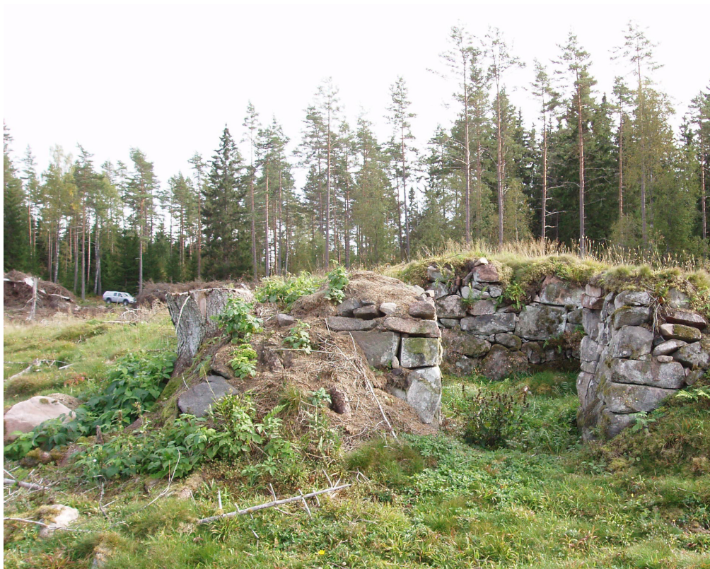
FIGUR 19. Kallmurad källargrund vid torpet Skogen. Foto: Ådel V. Franzén.
