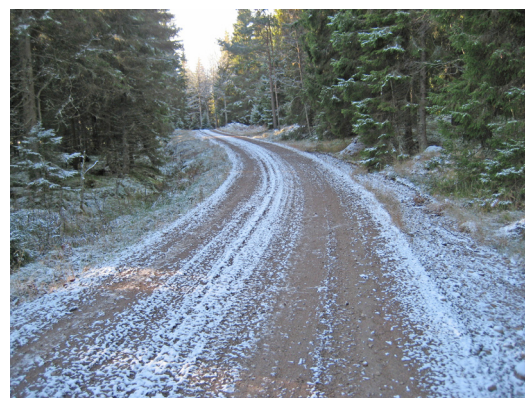
FIGUR 18. Under de senaste årtiondena har flera vägar i området breddats och grusats för att möjliggöra framkomlighet för skogsbrukets maskiner. Denna väg var markerad som stig på den ekonomiska kartan från 1950-talet, men är i dag en väl fungerande körväg. Foto: Ådel V. Franzén.
