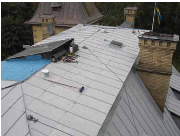
Säteritaketets övre fall som haft en sentida bandplåtstäckning täcktes om med en skivtäckning. Denna dubbelfalsade med hänsyn till takets flacka lutning.
