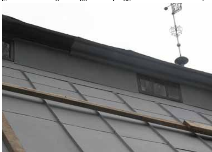
Säteritakets lanterninvägg täcktes om med en slättäckning. Här har plåten grundats med rostskyddsprimer.
