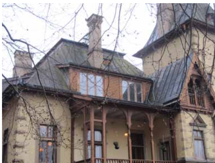
Plåttaket var inte omlagt sedan villans tillkommst 1896. Här de norra taken att jämföra med vidstående bild från 1905.
