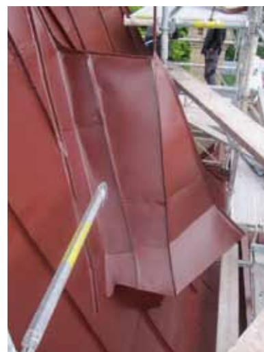
Takkuporna på det nordöstra torntaket med sin säregna form. Här kopierades plättäckningen.
