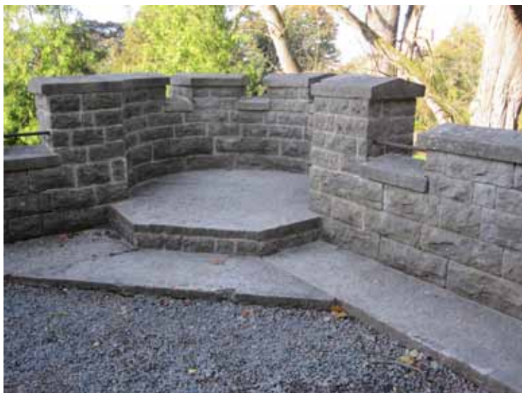
Terrassmurens hörntournell med uppriktat stengolv på ny bottenplatta och omfogat murverk.
