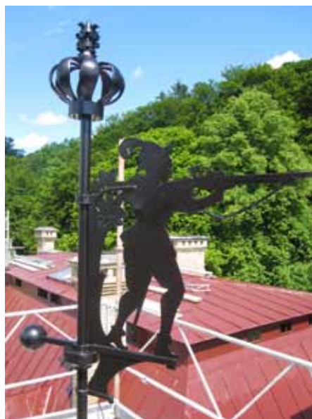
Vindflöjeln på sydvästra tornet togs ned för skrapning och ommålning på verkstad. Vindflöjlarna återställdes nu i sin ursprungliga svarta oljefärg.
