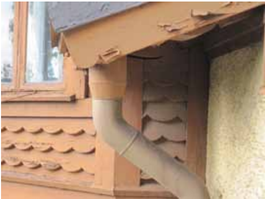
Takavvattning med vattkupa försänkt i själva takspårget.
