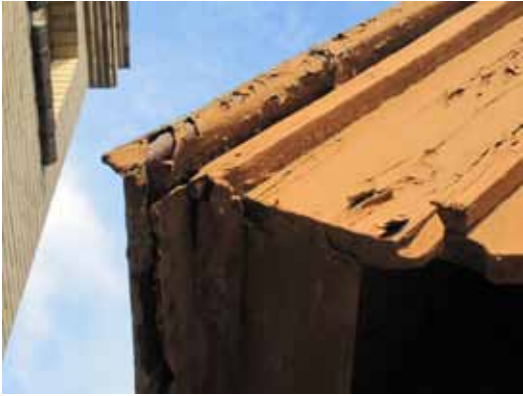
Detalj av plåtavslutningar vid gavlar och takfot på takkuporna. Vid gavlar är plåtens sammanfalsad med ett skruv och fotbleck fäst med fästbleck. Därefter är hela kanten uppknäck. I takfoten är plåtkanten helt oknäck, vilket är typiskt för äldre plåttäckningar.
