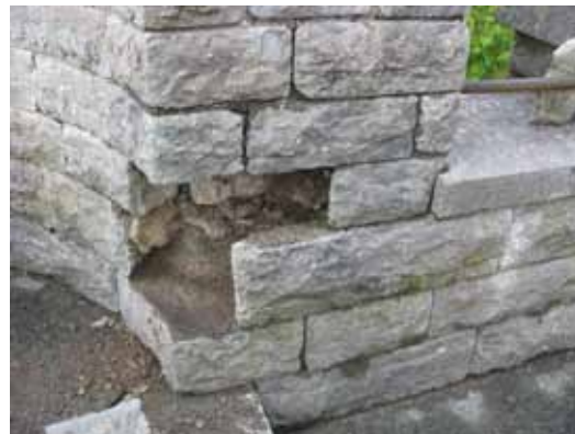
Bitar av tourellens murverk togs ned och murades om.
