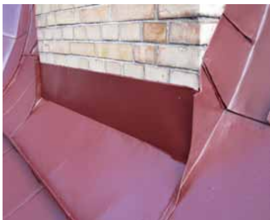
Detalj av anslutning mot skorsten. Plåten som tidigare endast var omvikt fästes nu med skruv i stället för spik för att inte riskera att drivas ut.
