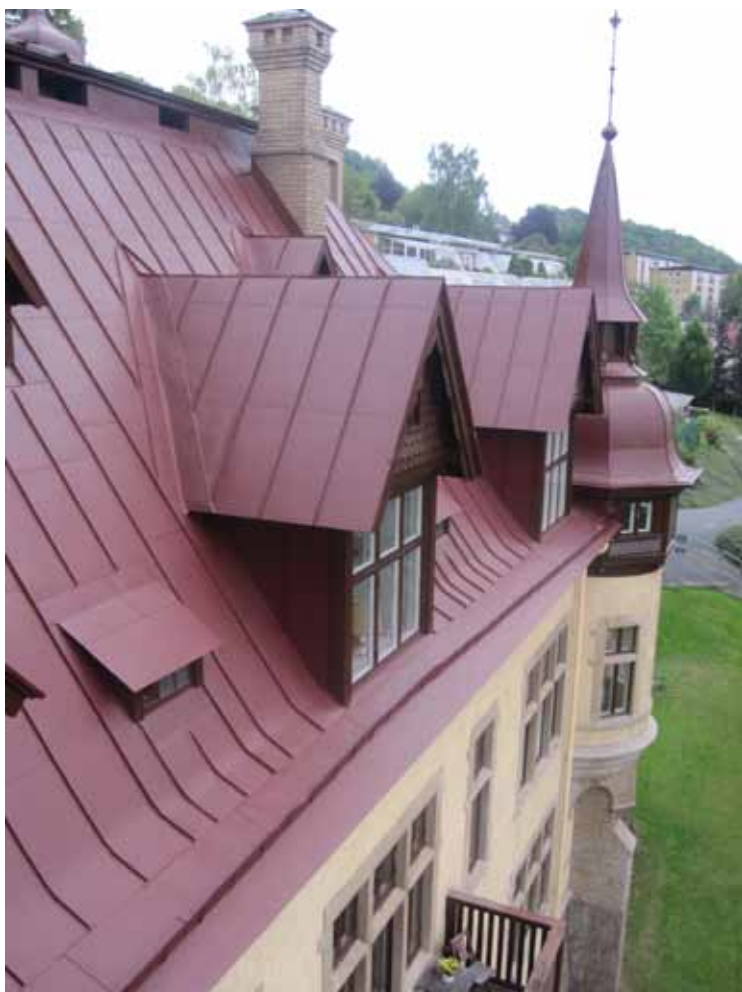
Västra takfallet vid slutbesiktningen 28 augusti 2012. Takkuporna täcktes här konsekvent med ståndfalsad täckning.
