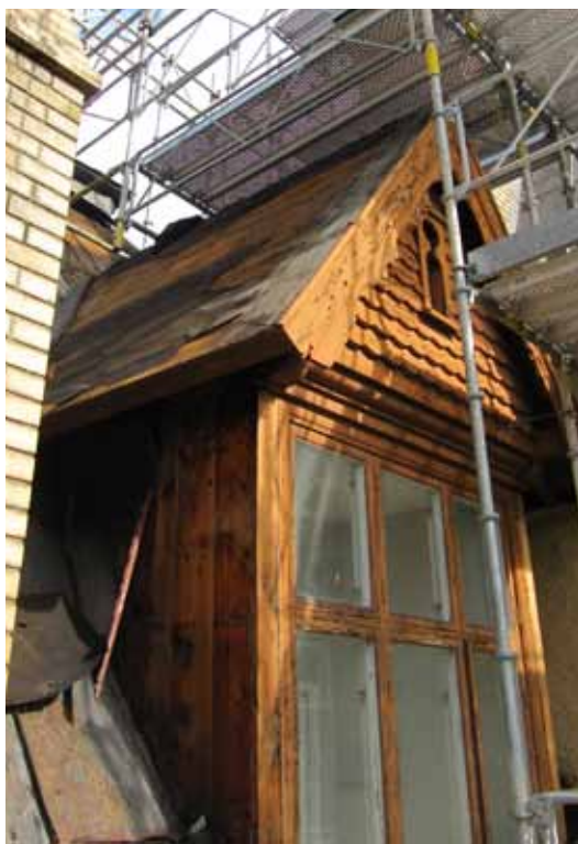
På takbotten av hyvlad spåntad furupanel ligger förhydringspapp i horisontella våder.
