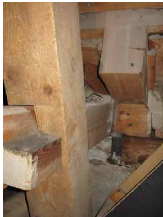
Taktassarna var separata ifrån själva takstolen och kunde härmed bytas relativt enkelt. De var försänkta och spikade i remstycket.
