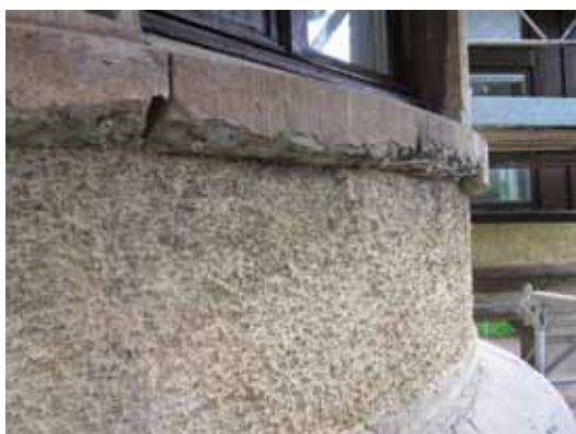
Pågående stenlagningar i den sydvästra hörntournellens fasad.
