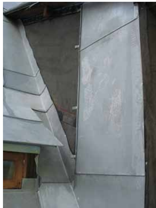
Sammanfalsad plåtvåd infäst med raka fästbleck av plåt.
