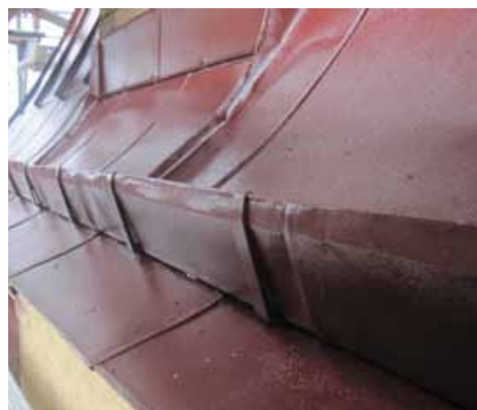
Takfotrännan på det nordvästra torntaket utfördes identisk med den äldre, med 60:cm breda plåtar och 12 cm hög ränna.
