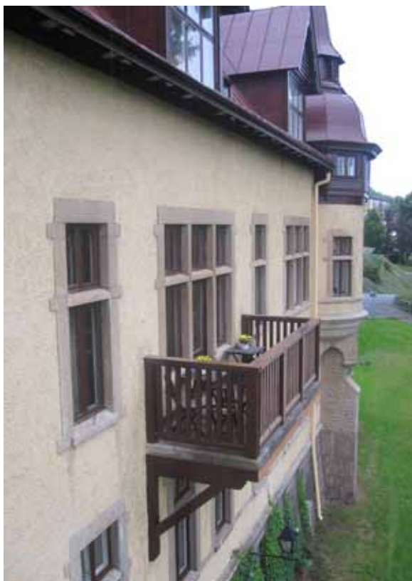
Västra fasaden med nymålade fönster och rengjorda stenomfattningar.
