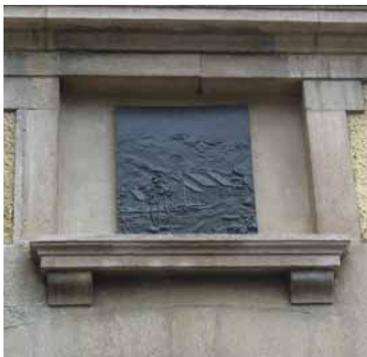
Gjutjärnsreliefen över huvudentrén rengjordes från rost och målades med svart linoljefärg.
