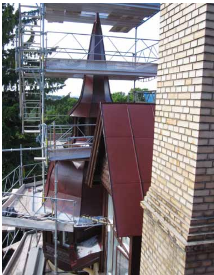
Sydvästra torntaket efter omläggning.
