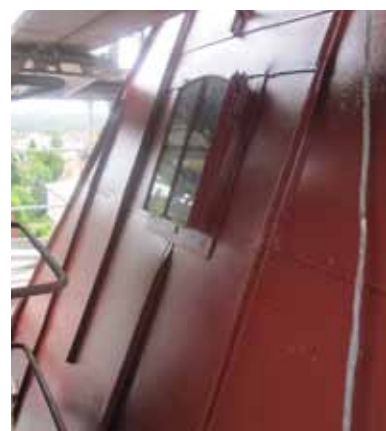
Takfönster i gjutjärn efter renovering.
