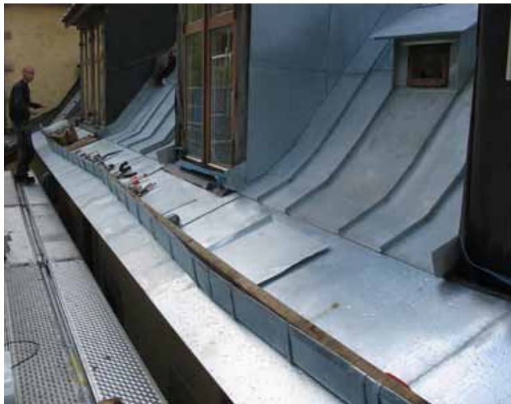
Takavvattningen med vattkuper vilka var integrerade/försänkta i själva takfotsrännan bibehölls. Den nya plåten försänktes i befintliga vattkuper. Lösningen förutsätter dock en regelbunden rensning av takfotrännorna.
