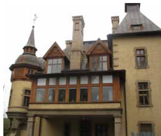
Södra fasaden före plåttakets omläggning.
