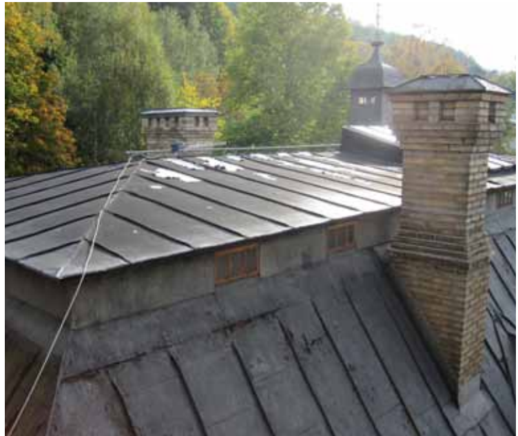
Säteritakens över takfall hade täckts om i senare tid med fabrikslackerad skruvbandplåt.
