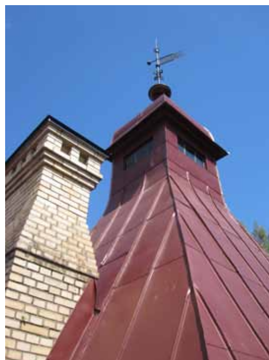
Sydvästra tornet efter omläggning av plåten. Vindflöjeln gavs en ny infästning i sitt ursprungliga läge.
