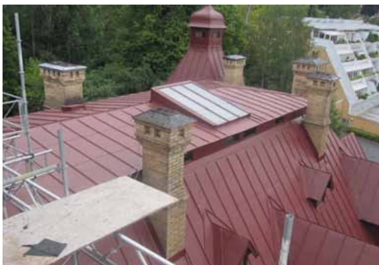
Säteritaket täcktes om med en skivtäckning. Trapphusets ljusbrunn försågs med nya trådglas. Nya lister i järn fick fräsas fram till ramverket som håller glaset.
