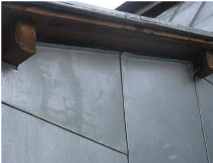
Sammanfalsad plåtvåd infäst med raka fästbleck av plåt.
