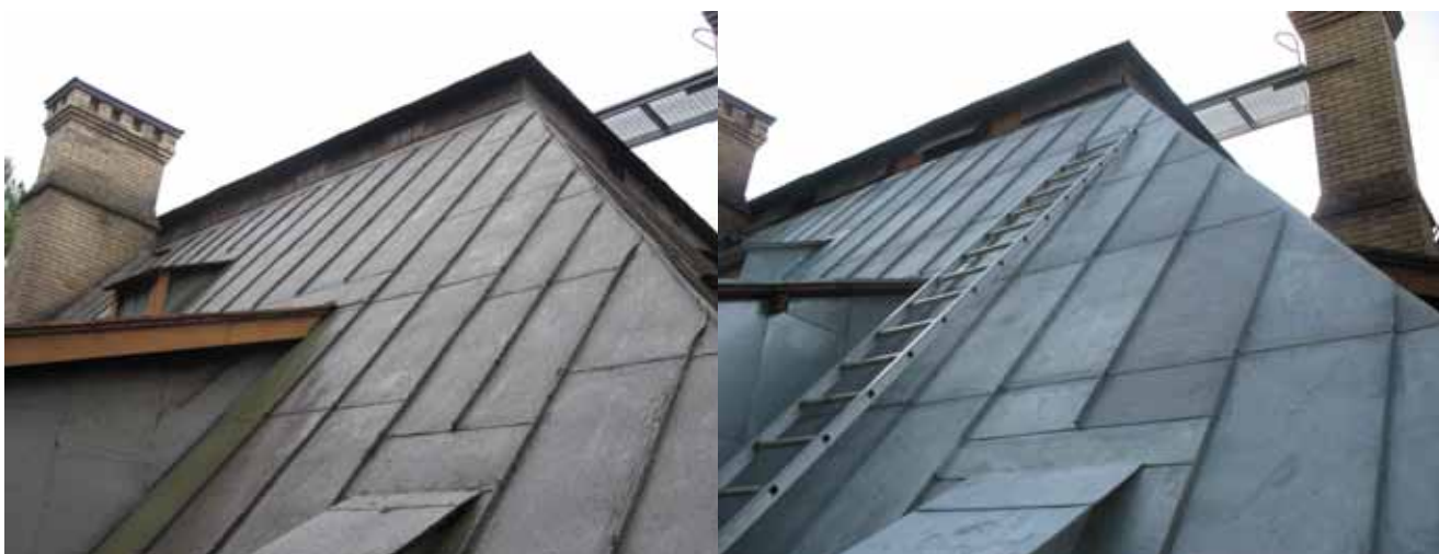
Plåttaket erhöll ett något mer homogent utseende efter omläggningen med i stort sett parallella hakfalsar. En annan detalj som avviker från ursprungligt utförande var kullslagningen av ståndfalsarna intill hörnnocken. På originaltaket hade detta skett åt höger motnocken.
