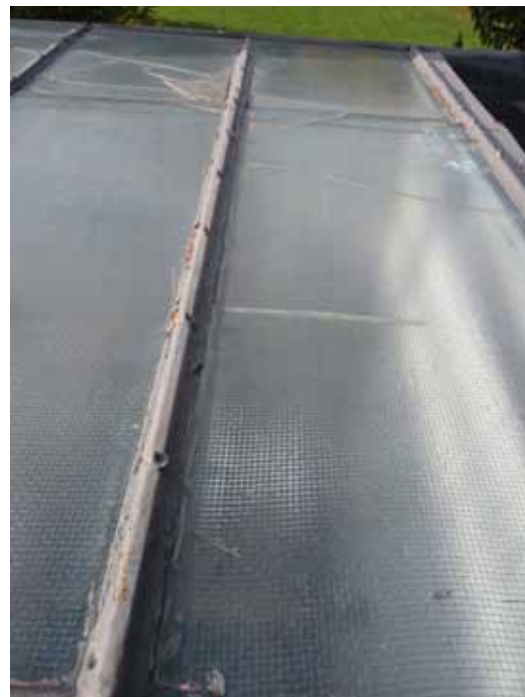
Skenorna som bär ljusbrunnens övre skyddsfönster fick ersättas med nytillverkade.
