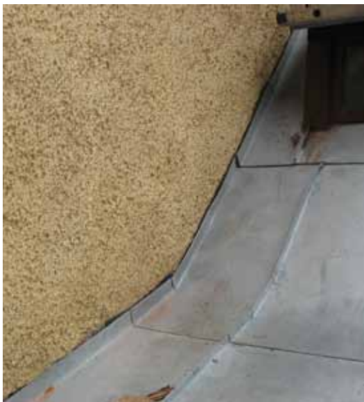
Anslutningen mot tornens putsade fasader utfördes likadana som tidigare men fästes in med skruv istället för spik. Här har putsen som ska råda över plåtkanten ännu inte återställts.
