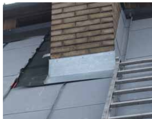
Anslutningarna till skorstenarna gjordes något högre än tidigare.
