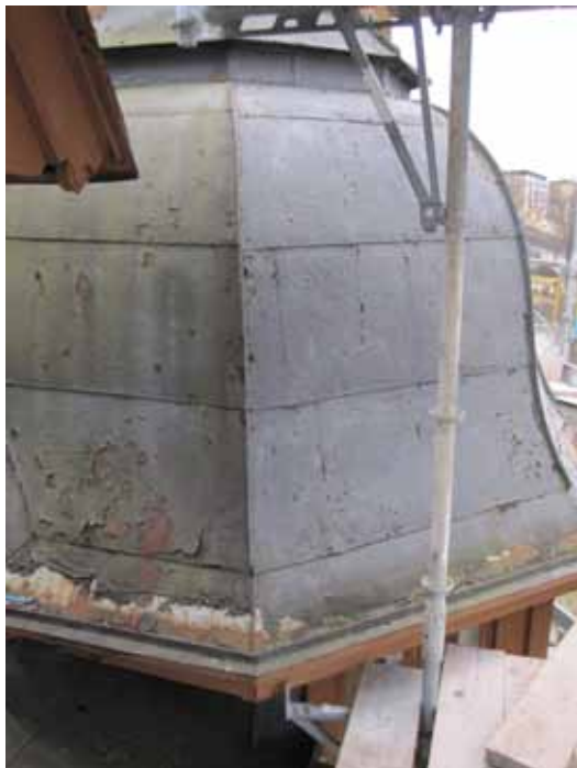
Svartplåt sammanfalsad av mindre plåtformat hade använts vid täckningen av den sydvästra tornhuven.
