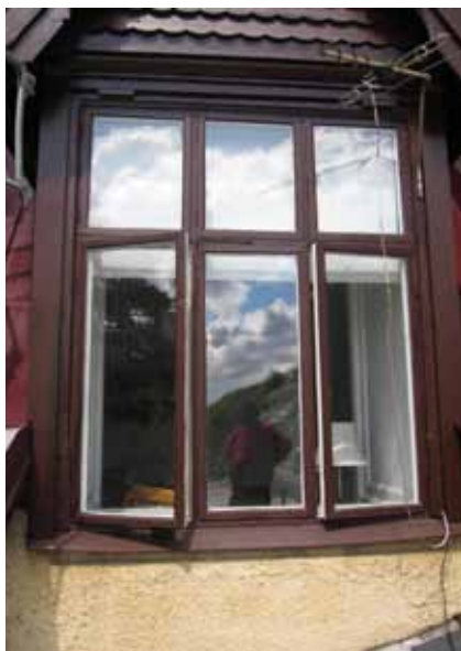
Fasadens fönster och snickeridetaler målades om i en mörkare rödbrun kulör som de ursprungligen haft.
