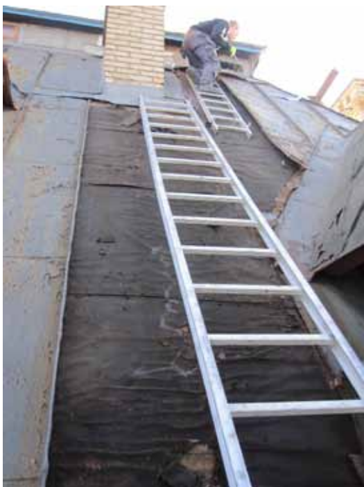
Plåttaket åt väster under rivning.
