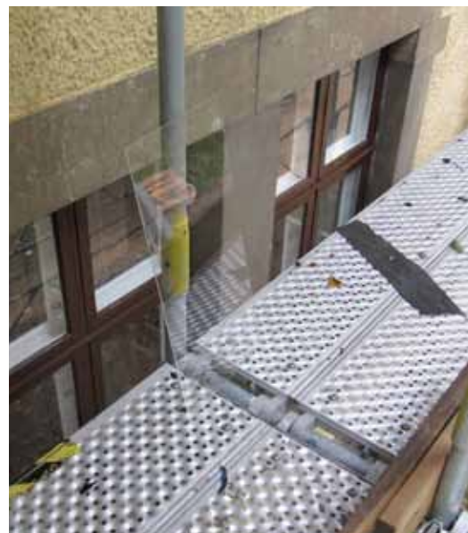
Som ersättningsglas till trasiga fönsterrutor användes ett nytillverkat munblåst glas, utan blåsor och missfärgningar.
