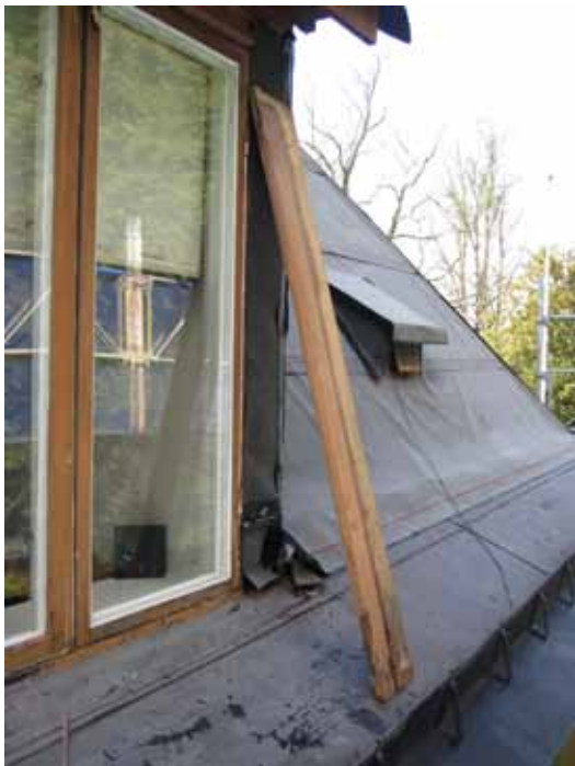
Under plåten lades åter en takpapp som även hade till syfte att skydda mot läckage under själva takarbetna. Takkuporna hörnfoder fick tillfälligt tas ned.
