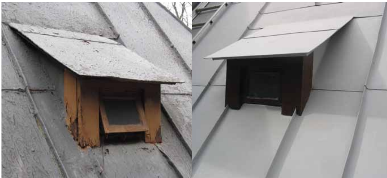
Takkupornas hörnfoder låg i många fall dikt an mot takplåten och de här kullslagna ståndfalsarna. För att minska fuktpåverkan på ändträet skars istället ståndfalsen in i fordet. I vissa lägen där taket har en flackare lutning kapades fodren även av ca 10 mm i den nedre kanten.
