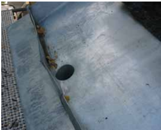
Takavvattningen med vattkuper vilka var integrerade/försänkta i själva takfotsrännan bibehölls. Den nya plåten försänktes i befintliga vattkuper. Lösningen förutsätter dock en regelbunden rensning av takfotrännorna.
