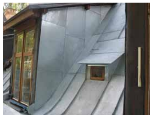
Sentida ilagningar i nedre delen av takkuporna sidoväggar togs bort.
