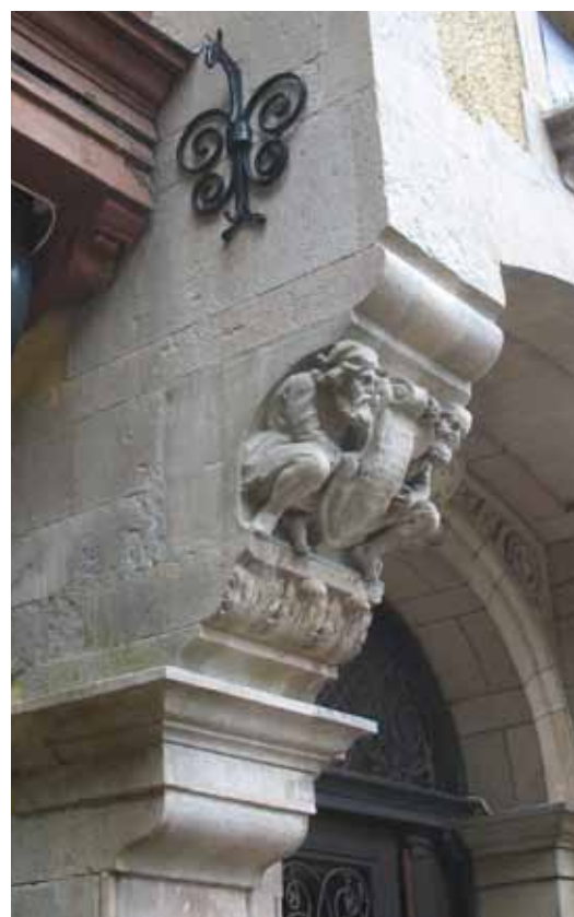
Huvudentrén stenportal efter konservering och rengöring. Sandstensskulpturen konsoliderades med kiselsyraester.
