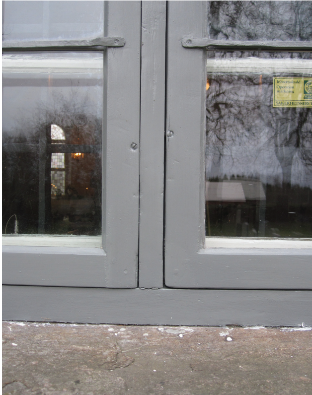
Fönsterbågarna återmonterades med spårskruv dock utan förutvarande bricka. Stormstagen fästes in med ny smidd spik i bågarna.
