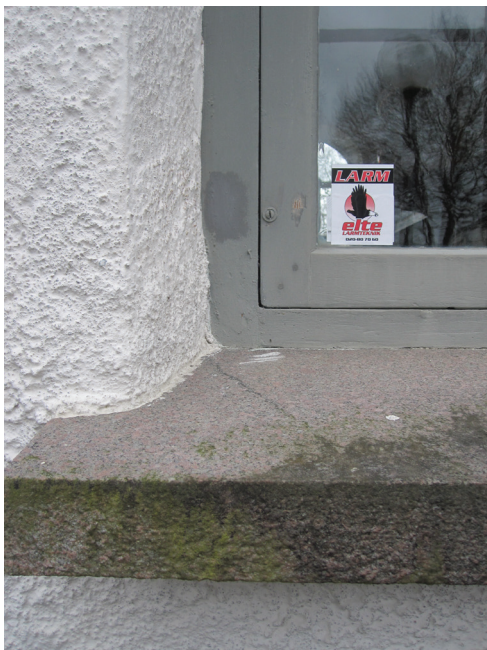
Nedan: Fönstrets anslutning mot solbänk och puts.
