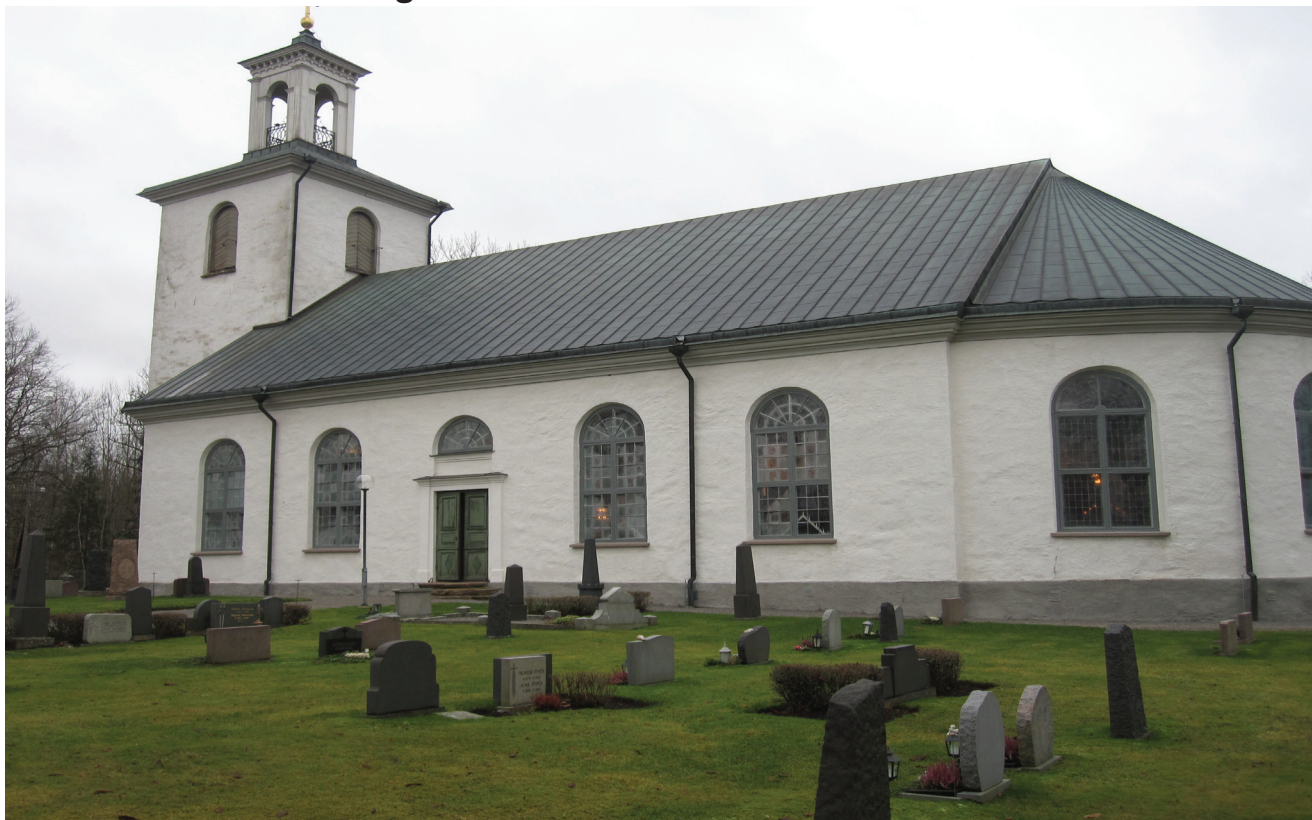
Kyrkan med de nyrestaurerade fönstren.
