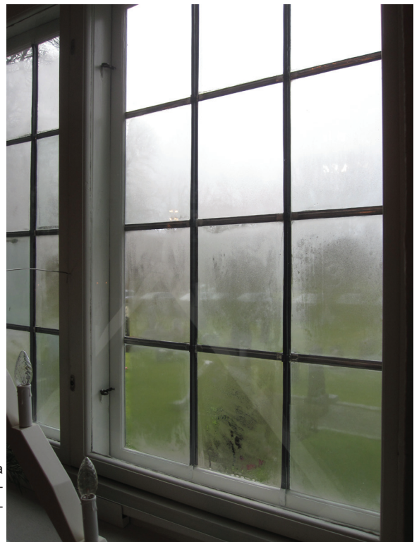
De invända vertikala stormstagen var målade svarta för att ansluta till blyspröjsen.
