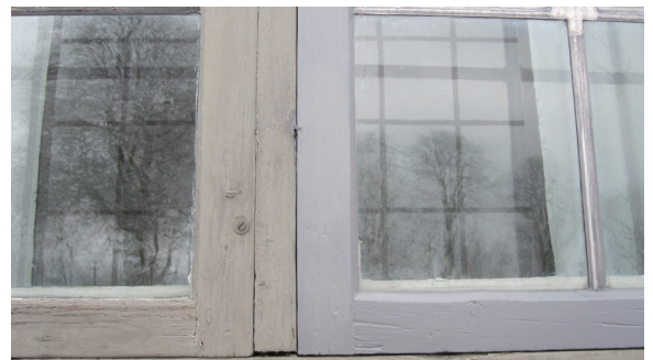
Som ett led i projekteringen restaurerades ett provfönster. Detta gav utrymme för dialog kring de antikvanska aspekterna i ett skede före tillståndsgivning. Ovan har stormstagen erhållit en infästning med klippspik istället för originalets smidd spik.
