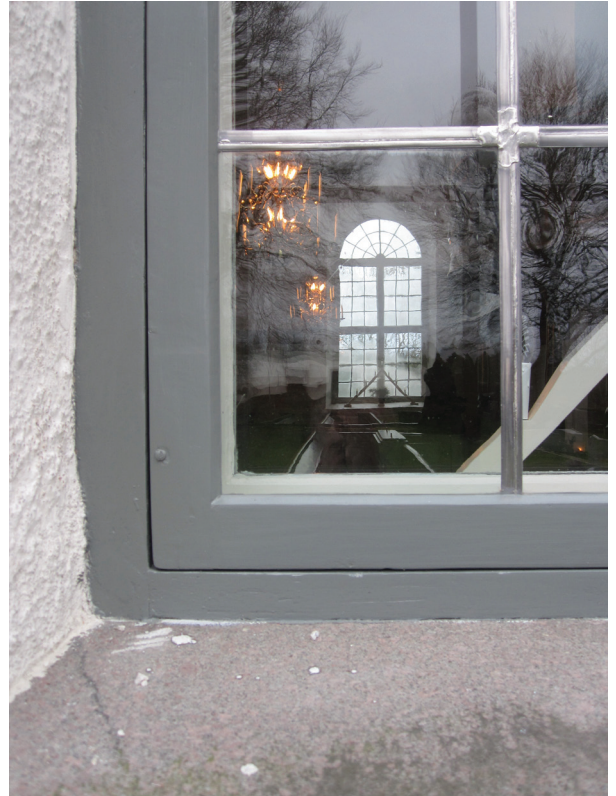
Fönsterbågarna återmonterades med spårskruv dock utan förutvarande bricka. Stormstagen fästes in med ny smidd spik i bågarna.
