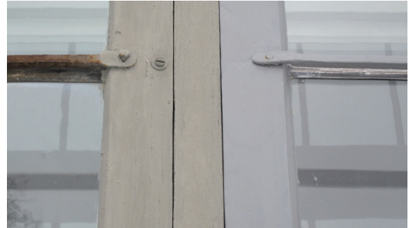
Fönstrens bågar var sedan slutet av 1990-talet infästa med skruv i karmen. Provfönstret gavs en mer traditionell montering med omvikt klippspik vars skallar klippts av. Detta kom aldrig till utförande. Istället valde man av praktiska skäl att bibehålla skruv.
