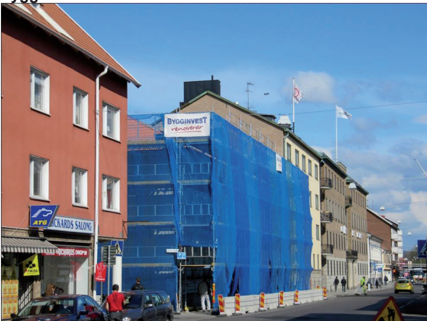
Byggnaden under byggnadsarbetena 2011.
