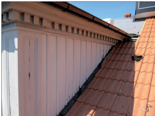
Attikavåningens gavelsida och takfoten före ommålningen 2011.
