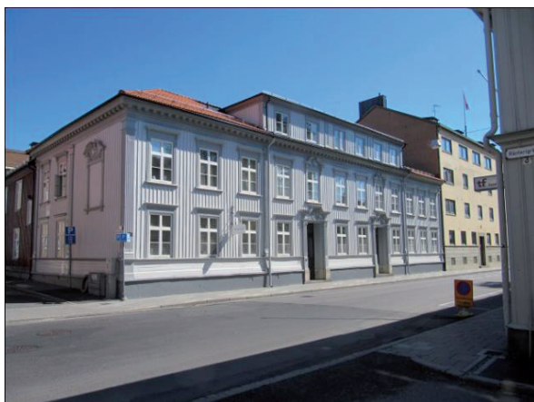
Fasaden mot Ö Storgatan efter ommålningen 2011.
