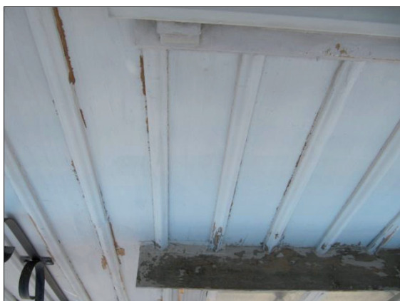
Fasaden med locklistpanelen och attikavåningens fasad före ommålningen 2011.
