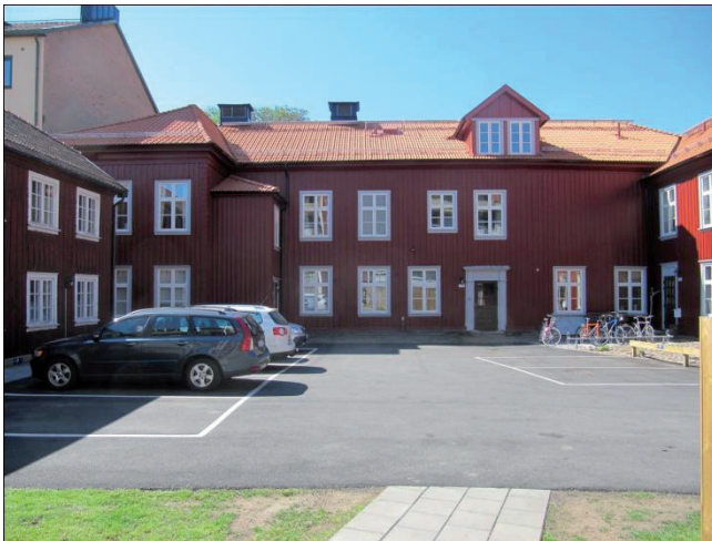
Fasader mot gårdssidan efter ommålningen och takomläggningen 2011.
