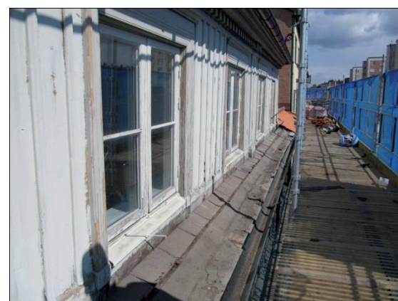
Fasaden med locklistpanelen och attikavåningens fasad före ommålningen 2011.
