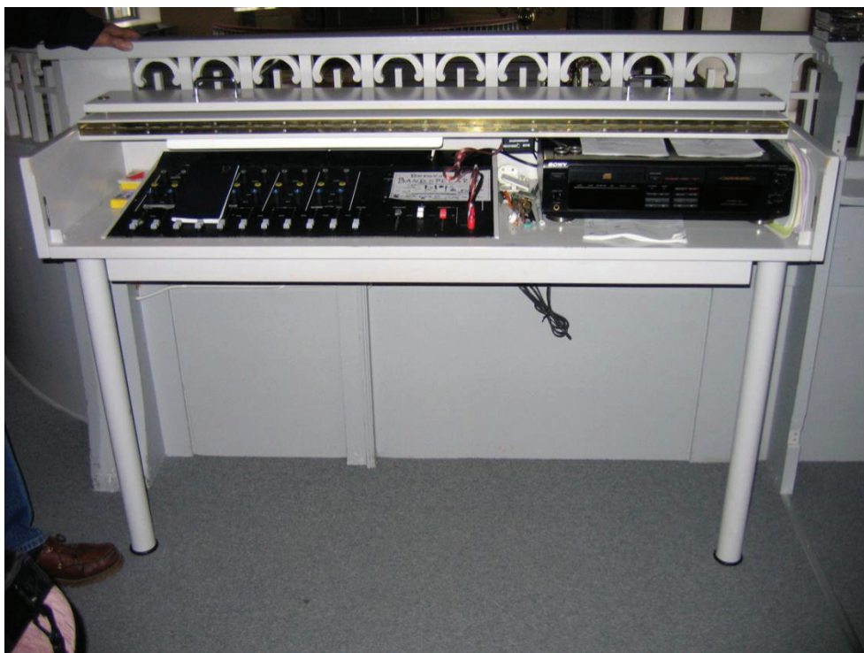
Befintlig styripulpet på läktaren.
