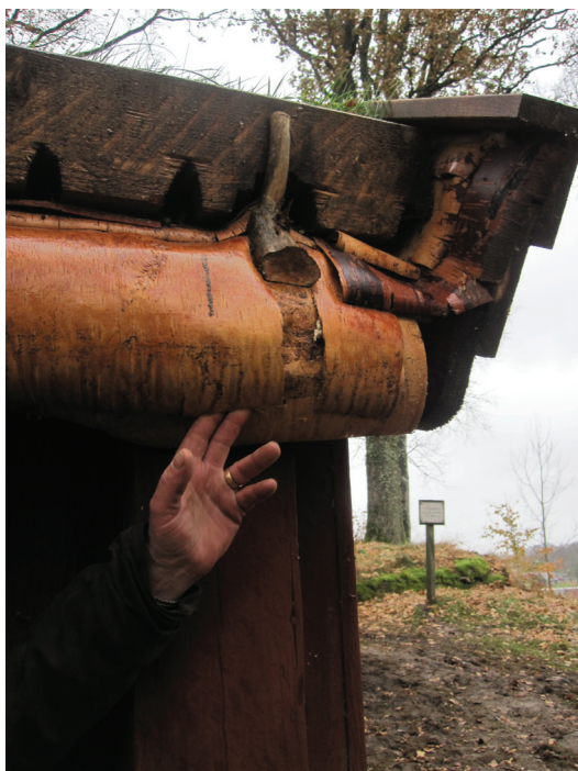
Ovan: Stugans nya takskägg. Ovan till höger: Stugans baksida efter restaureringen. Till höger: Stugans framsida efter restaureringen. Nedan till höger: Spår efter torvupptagningen.
