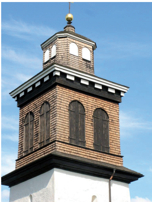
Spånklädseln på lanternin och gavelröste är i behov av tjärning.
