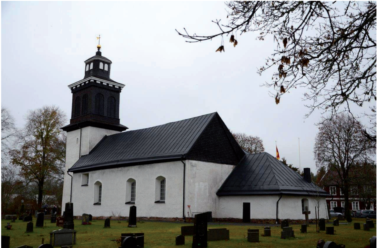
Från sydost i samband med slutbesiktning.
