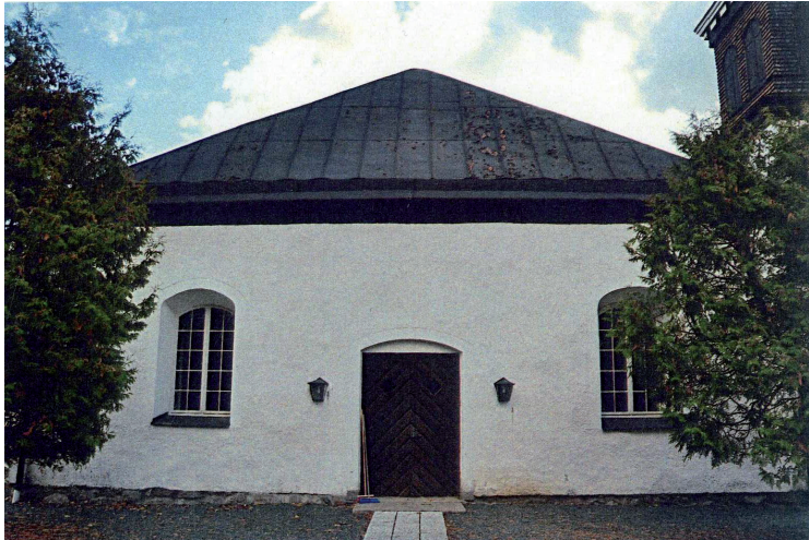
På korsarm och norra kor samt sakristitaket ligger svartplåt från 1903. Här finns omfattande färgsläpp. Foto: Lennart Arfwidsson.
