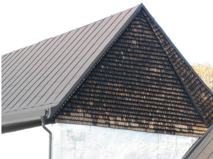
Spånklädseln på lanternin och gavelröste är i behov av tjärning.
