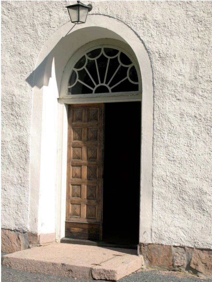
Port med överljus före ommålning.
