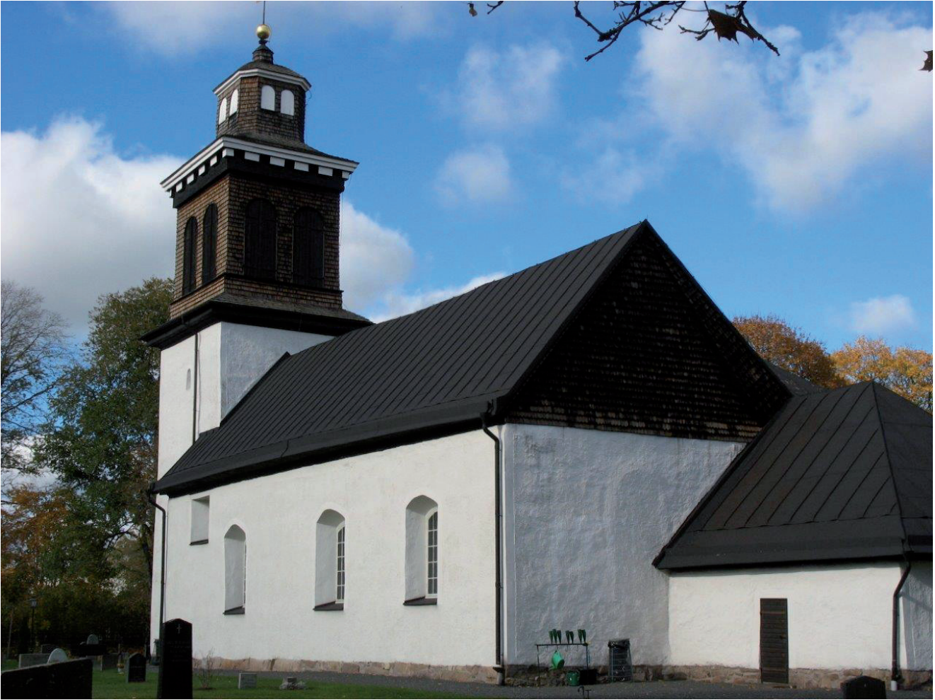
Bälaryds kyrka från sydost, fotograferad 2010. Södra takfallen omtäckta med varmförzinkad stålplåt 1984, målning i god kondition.
