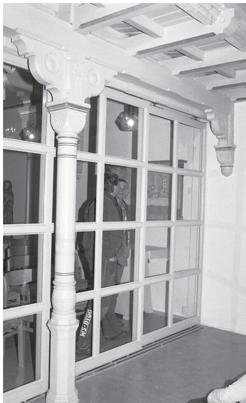
Pågående arbete, från kyrkorummet sett.
