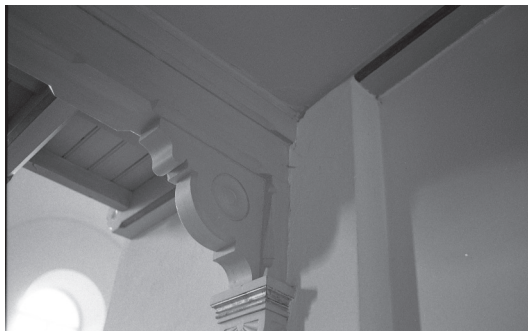
Detalj av läktaren före åtgärd.
