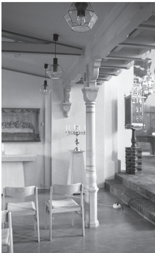
Norra korsarmen före åtgärd.
