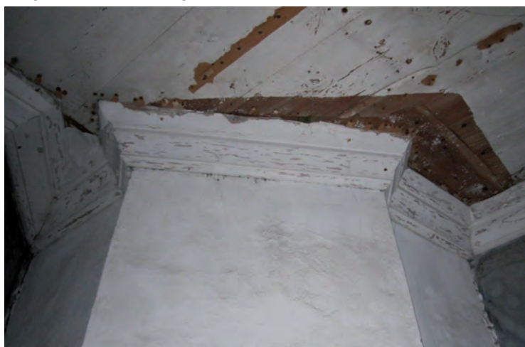
Ovan visas den stora salen under pågående restaurering. Nedan syns spår efter en eldstad med en annan vinkel än den befintliga. Till vänster syns rester efter en troligen äldre dekormålning i salen.
