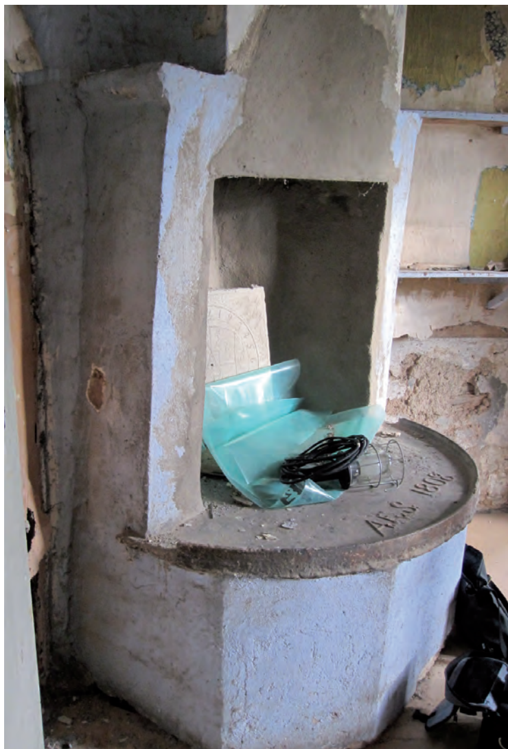
Spisen i rum 12 där den övre delen har hög ålder, medan det mesta under frisen tycks vara ommurning från 1900-talet. Gjutjärnshällen har inte tillhört byggnaden från början utan har troligen också återanvänts på 1900-talet.
