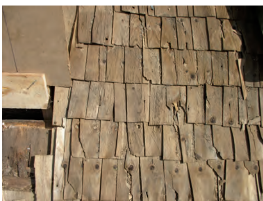
Närmast under skifferplattorna låg hyvlade stickor.
