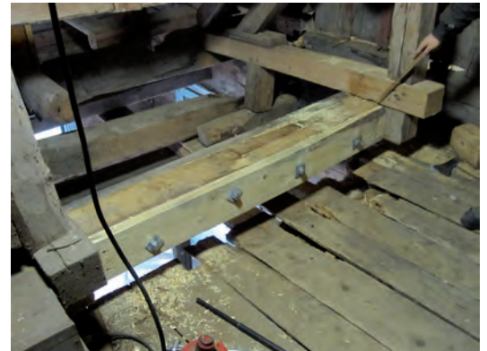
Ovan och nedan visas förstärkningarna av bjälklaget över den stora salen.
