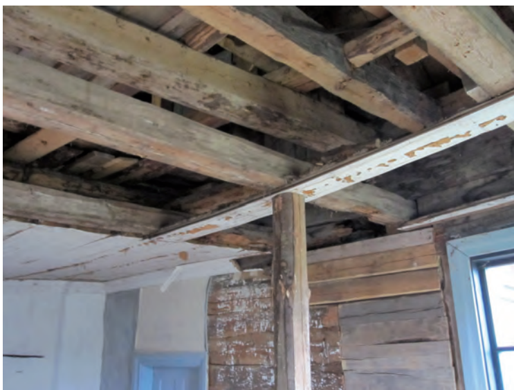
Genom förstärkningarna av bjälklaget över den stora salen kunde två sekundära pelare tas bort.
