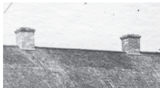
Inför ommurningen av skorstenarna användes en förstoring av ett äldre fotografi (ovan) som förebild. Till vänster visas det färdiga resultatet.
