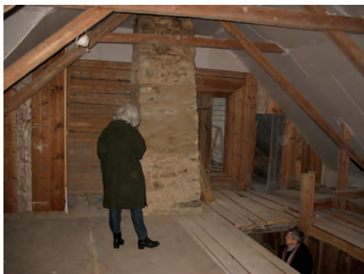
Vinden efter isolering mot takbotten.
