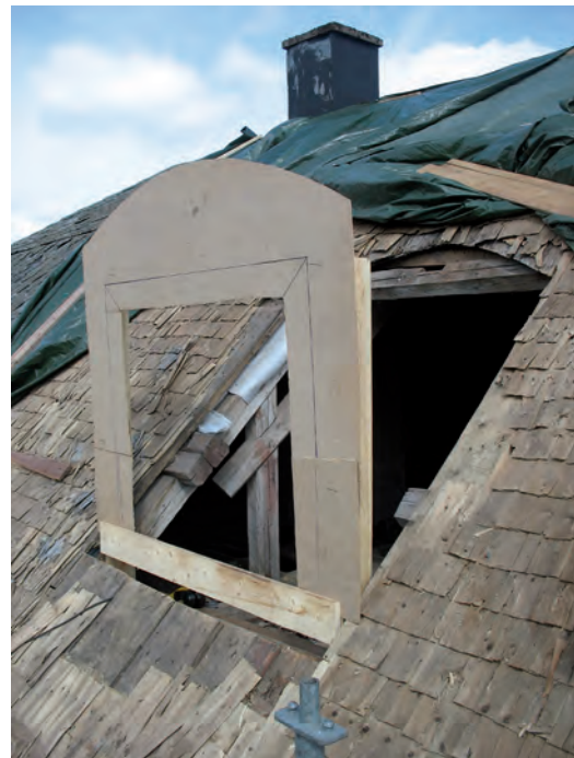
Innan uppförandet av takkupan gjordes en atrapp för att pröva dimensionerna.
