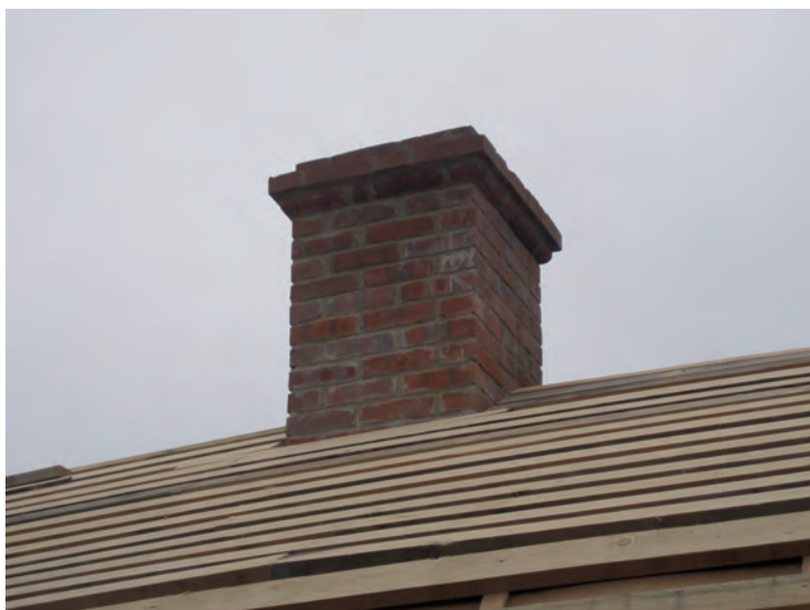
Inför ommurningen av skorstenarna användes en förstoring av ett äldre fotografi (ovan) som förebild. Till vänster visas det färdiga resultatet.
