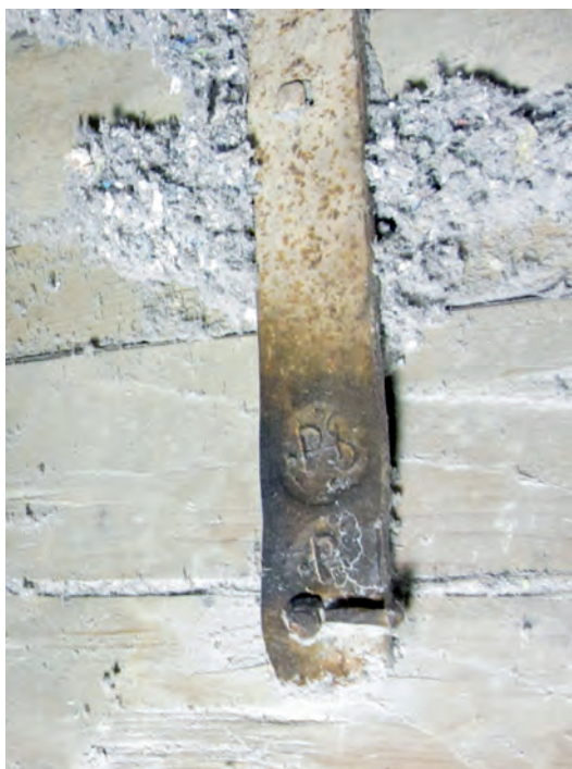
Vinkeljärn på vinden som förankrar träkonstruktionen vid en av storskensmurarna. Beslaget är stämplat med Götaströms Bruks järnstämpel, se nedan. Götaströms bruk låg i Tofteryds socken och var i gång från 1672 till 1896. Bilden har vänts upp och ned för att stämplens skall kunna utläsas.
