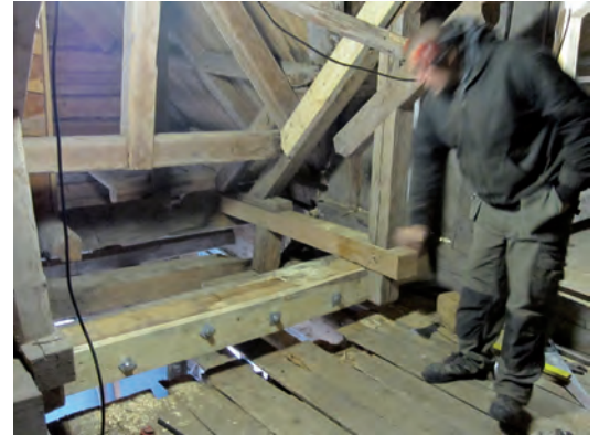
Ovan och nedan visas förstärkningarna av bjälklaget över den stora salen.
