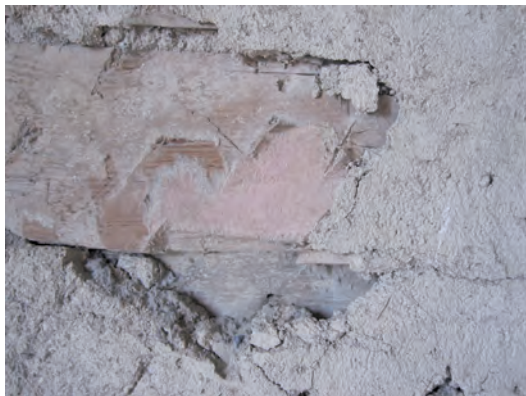
Ovan visas stommens timmer, ovanpå detta pappret med rosa limfärgsmålning och över detta ett putsstikt. Nedan syns väggens nedre del med målad bröstning. Det mörkgråa är originalmålning och det ljusgråa sekundärt. Nedtill syns penseldragen från den första målningen.
