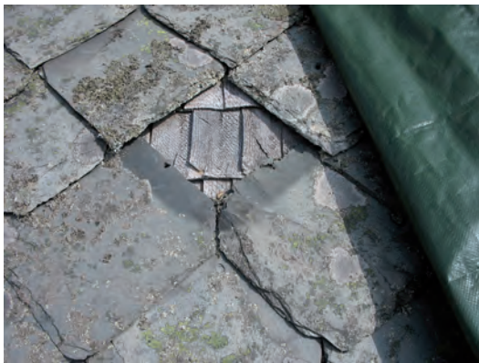
Närmast under skifferplattorna låg hyvlade stickor.
