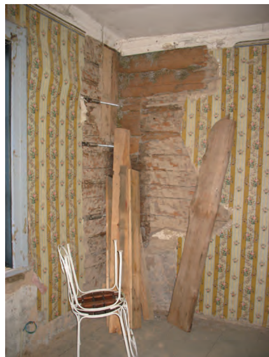
Exempel på förstärkning med ståltag av stommen i rum 13. Lägg märke till att yxhuggen på timret saknas närmast hörnet.
