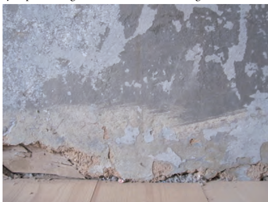
Ovan visas stommens timmer, ovanpå detta pappret med rosa limfärgsmålning och över detta ett putsstikt. Nedan syns väggens nedre del med målad bröstning. Det mörkgråa är originalmålning och det ljusgråa sekundärt. Nedtill syns penseldragen från den första målningen.
