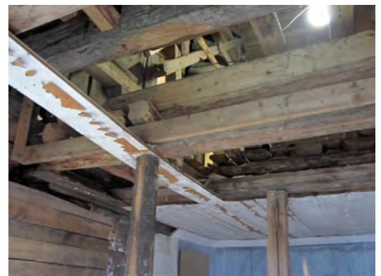
Genom förstärkningarna av bjälklaget över den stora salen kunde två sekundära pelare tas bort.
