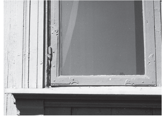
Beslagen blev mer distinkta efter det att färglagren skrapats bort.
