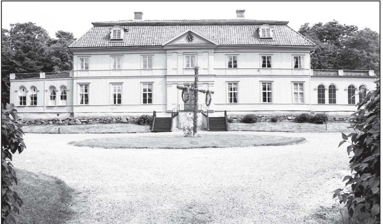
Huvudbyggnaden på Östanå herrgård, inför fönsterrestaureringen 2001. Foto: Britt-Marie Börjesgård
