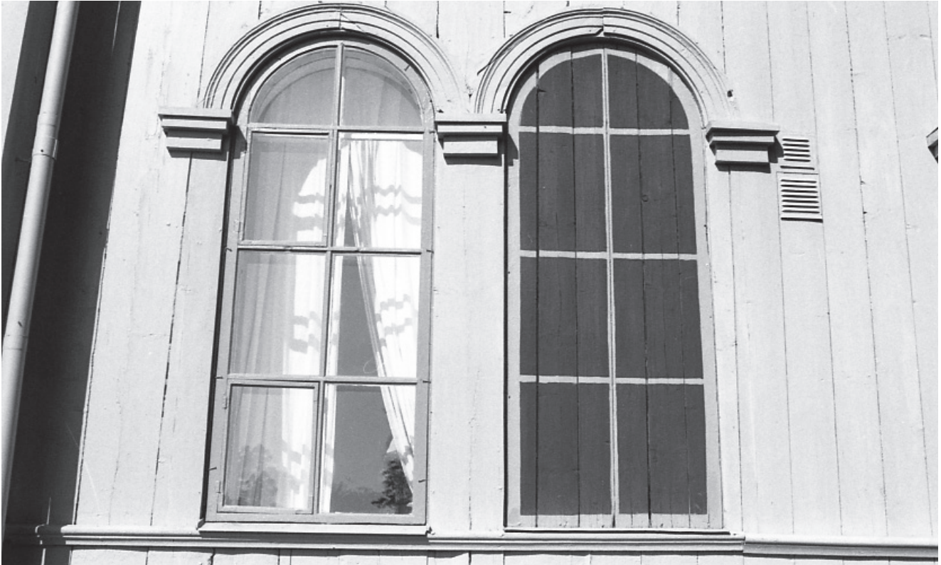
Fönstren i den norra pochen, från 1809, behöll sina enkla gångjärnsbeslag vid vädringsrutorna. Bågarna återmonterades med omvikt trådspik.
