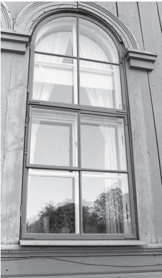
Fönstren i den norra pochen, från 1809, behöll sina enkla gångjärnsbeslag vid vädringsrutorna. Bågarna återmonterades med omvikt trådspik.
