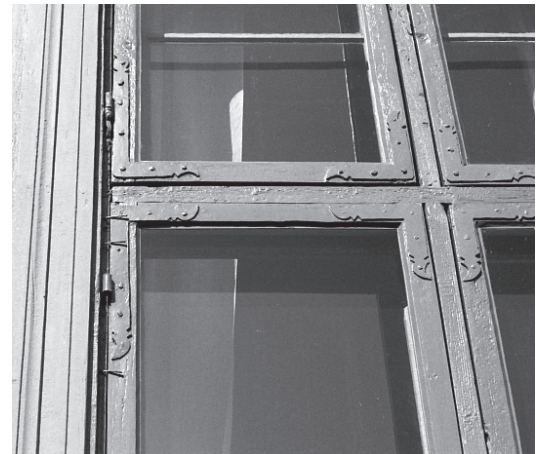
I några lägen då gångjärnens smidda stolpar saknades skedde återmonteringen med omvikt trådspik
