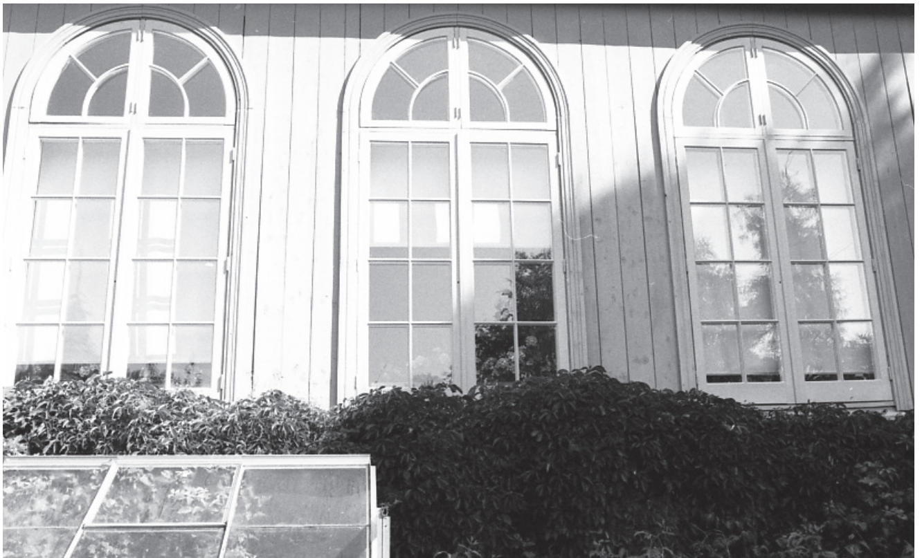
Den södra fasaden i södra pochen.
