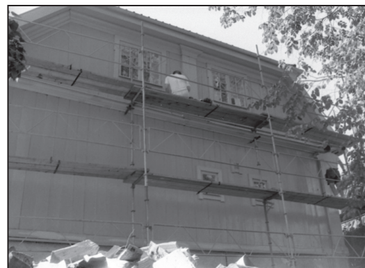
En av fasaderna under ommålning.
