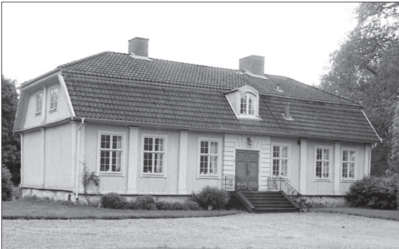
Den södra flygel i det inre flygelparet vid Östanå, inför renoveringen 2002.
