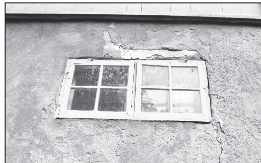
Originalfönster i källarvåningen på norra flygeln. Dessa fönster åtgärdades inte.
