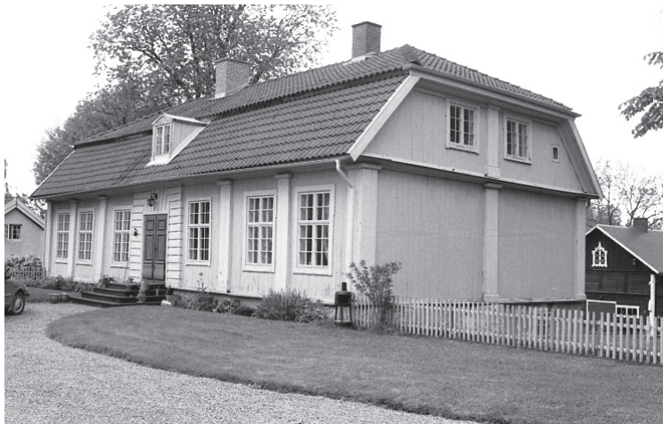
Södra flygeln före ommålning.
