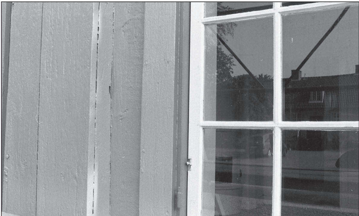
Detalj av fasaden vid slutbesiktningen 2002.
