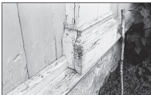
Detalj av pilasterbas i en av fasaderna före ommålning
