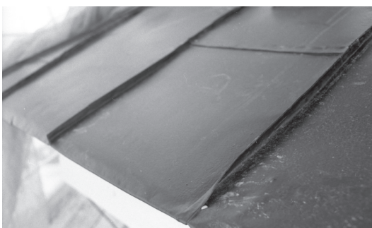
Enstaka plåtar ersattes i lanternintaket och hela plåttäckningen målades om (färgtyp och fabrikat saknas eftersom materialföteckning aldrig inlämnats).
