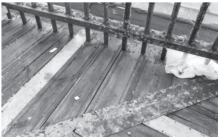
Bräddtaget hade hörnnockar täckta med småbleck av förzinkad plåt, i vissa lägen spikade med smidd spik.
