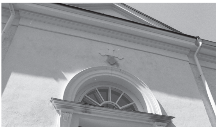
Lokal putslagning över kyrkans östentré.
