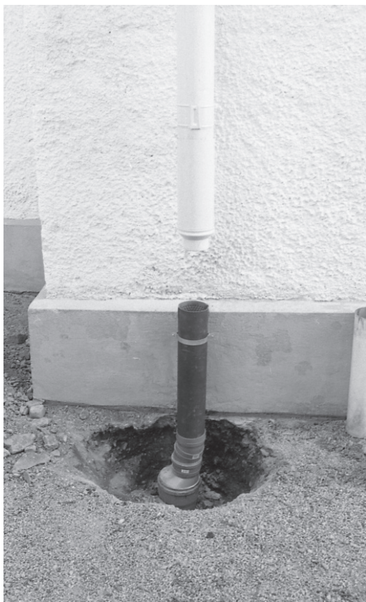
Nya dagvattenbrunnar grävdes ned.
