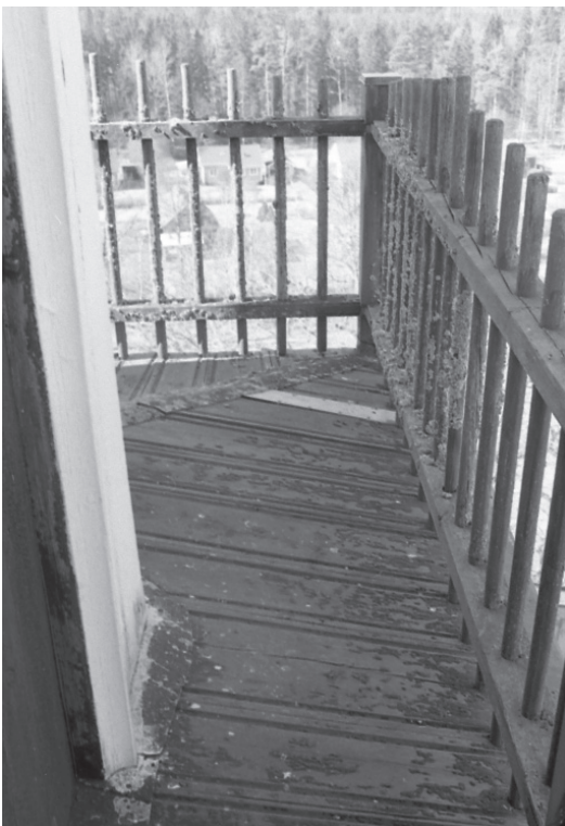
Lanterninen står på en upphöjd avsats på tornaket vilken omges av ett träräcke. På avsatsen finns ett äldre brädtak, vilket sannolikt är från kyrkans tillkomsttid.
