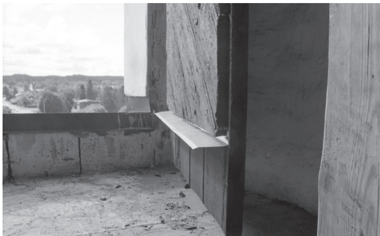
I nedre kanten på tornluckorna sattes droppleck av galvad plåt. Blecken fördes in bakom panelen på luckorna och skruvades.
