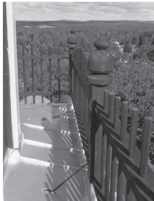
Det nya räcket försågs med svarvade knoppar, vilket det äldre räcket ursprungligen haft.
