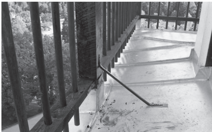
De smidda beslagen och infästningsstagen till det befintliga räcket återanvändes.
