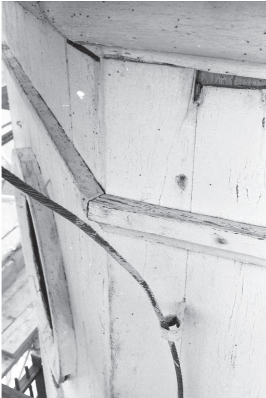
Tornlanterninen hade slät fasadpanel med dekorlister. Den var målad helt i vitt. Här syns en av de runda öppningarna samt åskledaren med befintligt fäste.
