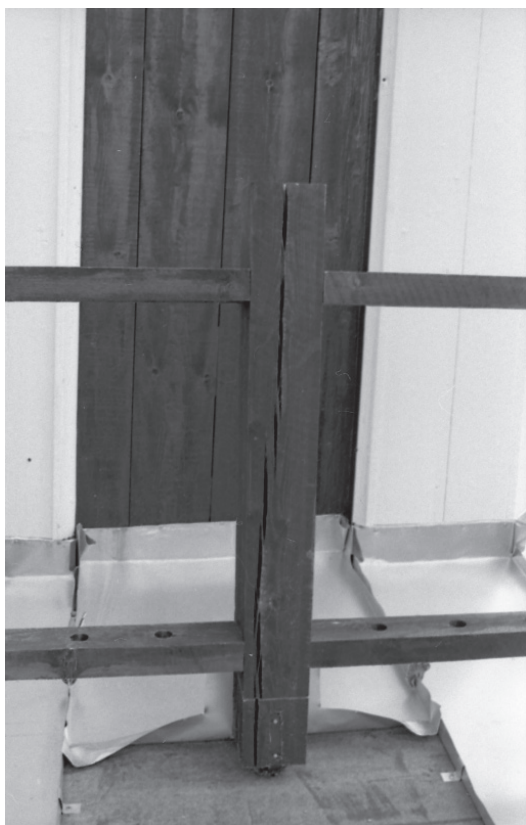
Brädtaket på avsatsen revs och ersattes med ny galvad plåt.
