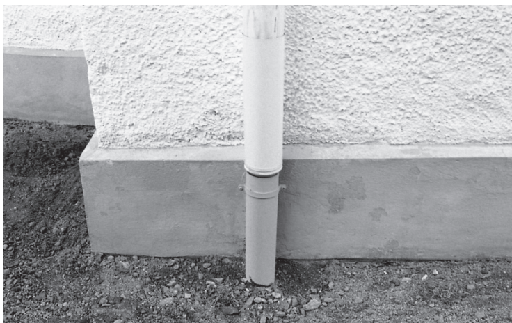
Stuprören anslöts till befintliga rör, vilka målades in i sockelns kulör. Vidare försågs de med en rörlig rördel för att möjliggöra rensning.
