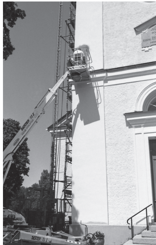
Tornets kors och klot förgylldes om samt försågs med nya åskledarfästen.
