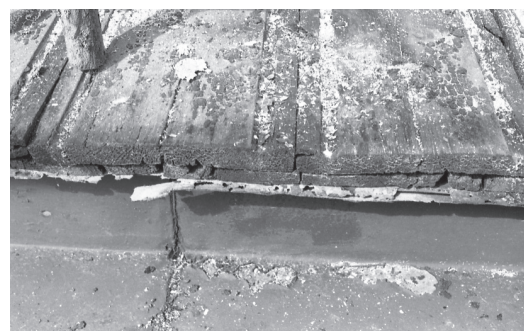
I takfoten fanns en dropplista av förzinkad plåt.
