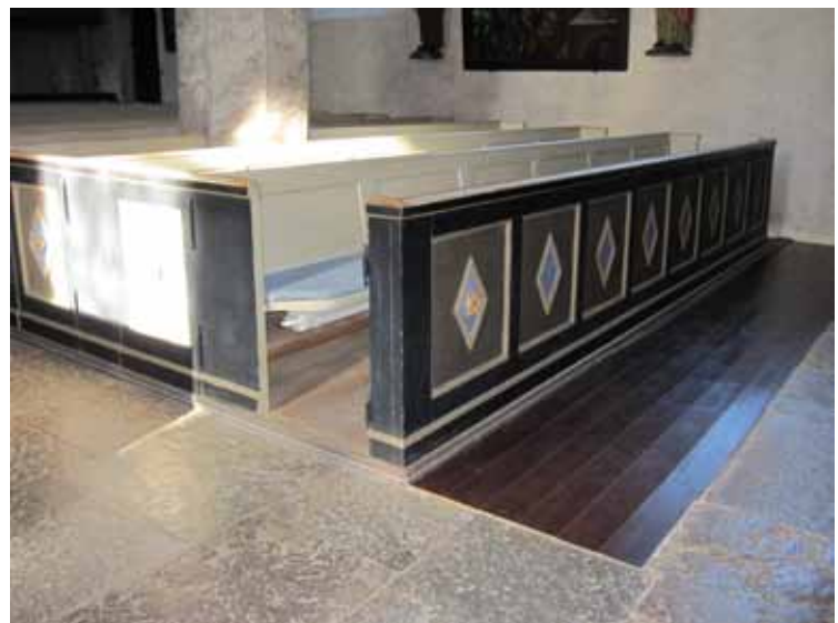
Bänkkvarteren kortades av med en bänk i långhusets främre del. Golvet återställdes provisorisk med fernissat brädgolv men ska enligt länsstyrelsens beslut beläggas med kalksten.
