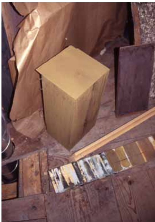
Kulörer bryts fram i äggoljetempera till inklädnaden av kanalen på korskranet i södra korsakristian.
