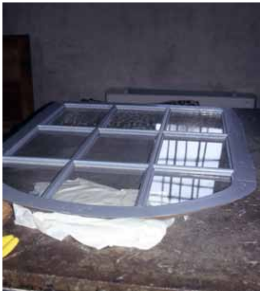
Ett av innanfönstren i sakristian efter ommålning.
