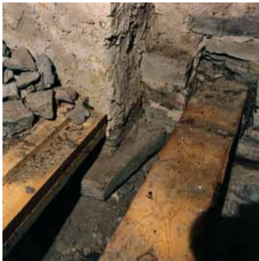
I tornvindens östra del som består av den välvda genombrytningen av tornmuren påträffades resterna av vad som kan vara ett medeltida kalkstensgolv. Lokalt under de sekundära förstärkningsmurarna vid ytterväggarna fanns utskjutande kalkstenschällar. Foto: Göran Sandstedt.
