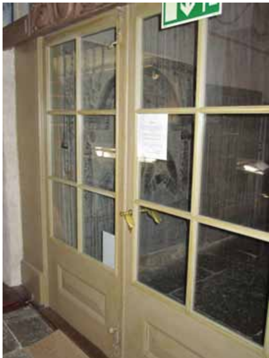
Glaspartiet mot vapenhuset försågs invändigt med isolerruta. Kilar av obehandlad ek lades vid dörröppningen mot vapenhuset för att förbättra tillgängligheten.
