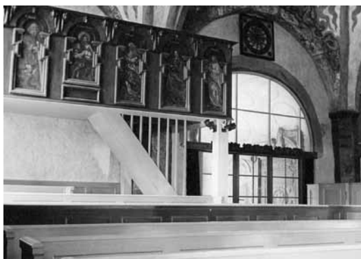
När orgelläktaren från 1700-talet revs kunde perspektivet mot kyrkorummet öppnas upp med ett nytt glasparti i valvbågen mot vapenhuset. Två separata läktare byggdes på ömse sidor. Foto: Göran Pauli, JLM:s arkiv.
