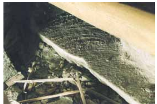
Rester av ett kalkstengolv påträffades under dagens korgolv intill altaret på dess norra sida.
