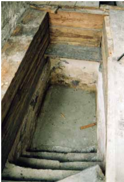
I vinkällaren fick två timmerstockar i den sekundära östra väggen flyttas för att få plats med det nya varmluftsdonet.
