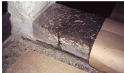
Efter att el nu dragits om ersattes den äldre lagningen med en ny i ett pigmenterat cementbruk. Tröskeln form återskapades och lagningen "glättades" för att efterlikna stenytan.
