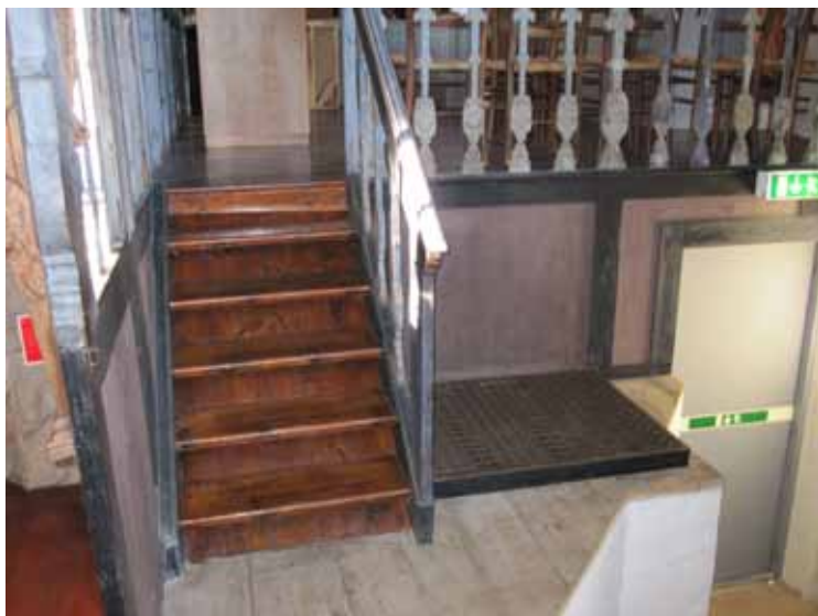
Nytt frånluftsdon i norra korsakristian.
