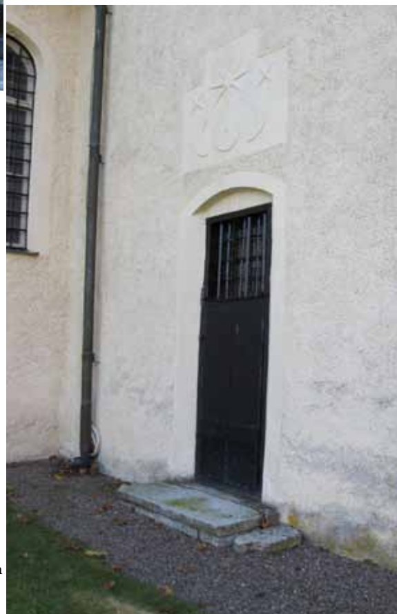
Sakristinas järnplåtsbeslagna port målades om med svart linoljefärg.
