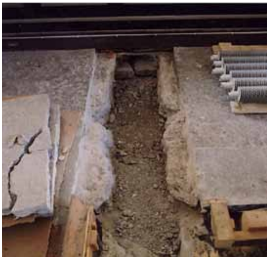
Kalkstensgolvet i kyrkorummets gångar togs upp i mindre schakt för att åstadkomma en dold ledningsdraging. I schakten bilades undergolvet av betong upp. Foto: Göran Sandstedt.
