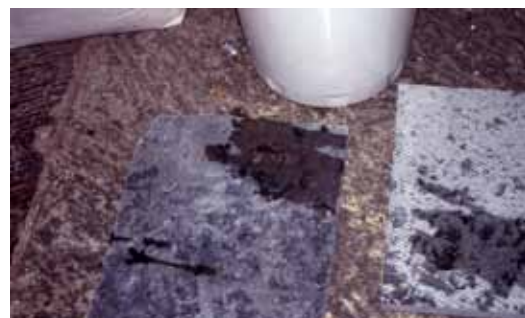
Prov på nyframtagen kalksten med olika ytbearbetning togs fram inför återställandet av den främre tvärgångens golv.
