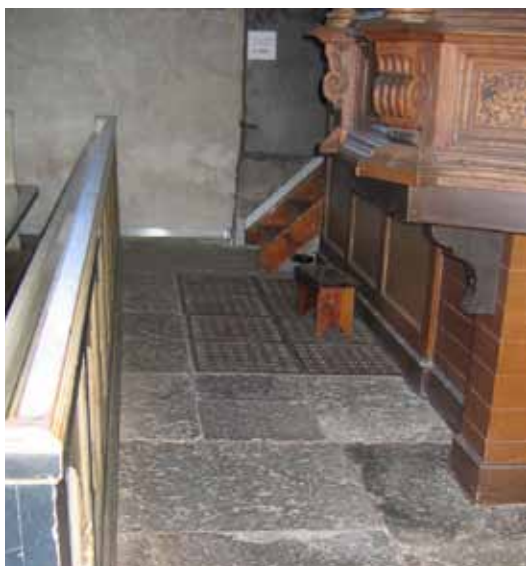
Varmluftsanläggningens returkanal med gjutjärnsgaller i långhusets främre tvärgång framför djäknekoret.
