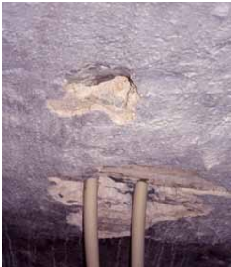
Detalj av håltagningar för brandlarmets ledningar i sakristians valv. Håltagningarna gjordes dold bakom skåpsväggens porträttgalleri i valvens anfang.
