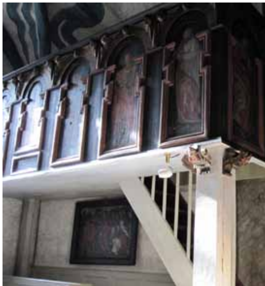
En diskretare spotlight valdes till belysningen av stenepitafiet på långhusets södra vägg.
