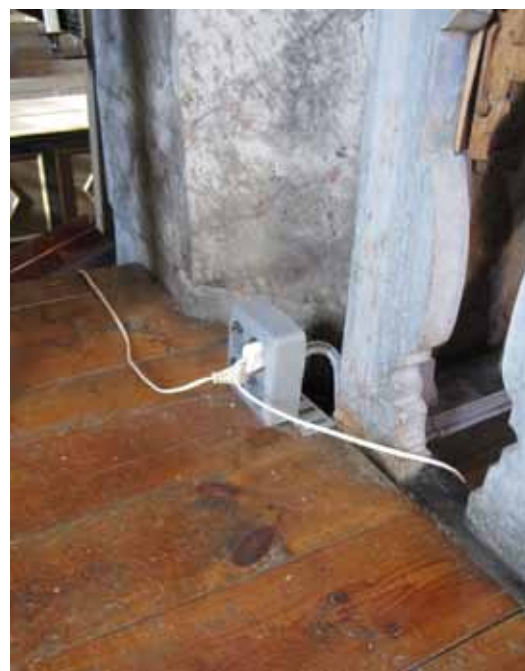
Nya eluttag med undanskymd placering på Braheläktaren.
