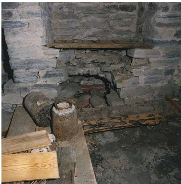
Under det som kan vara en medeltida altarnisch fanns en välvd genombrytning av muren mot kyrkorummet. Öppningen som är sekundärt igensatt med tegel mynnar i ett ur placerat över ingångsvalvet. Foto: Göran Sandstedt.
