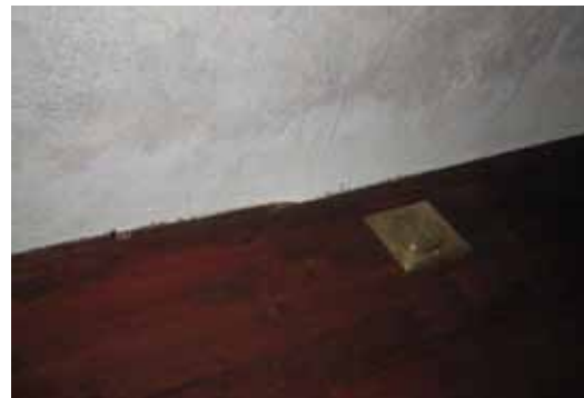
Med försänkta golvuttag i långhusets sidogångar undveks både ingrepp i väggens originalputs och mer iögonfallande vägguttag.
