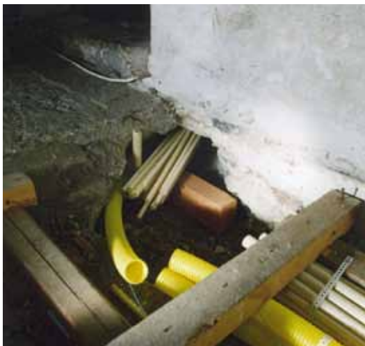
Håltagning i grundmuren strax under tröskeln till sakristian. Foto: Göran Sandstedt.
