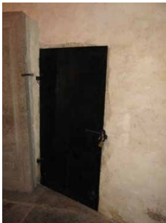
Plåtdörren i vapenhuset till torntrappen målades om med svart linojefärg.
