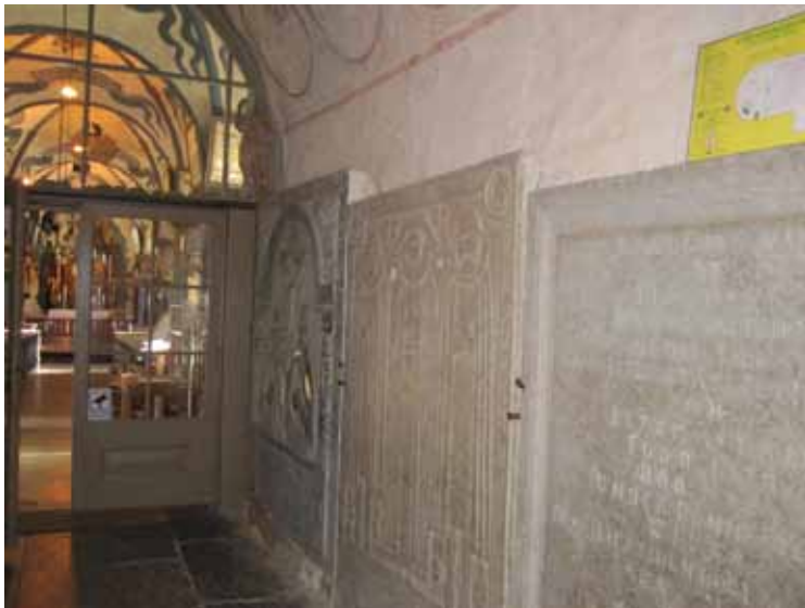
Vapenhuset efter mögelsanering och rengöring.
