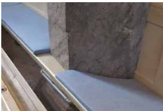
Returledningen till bänkvärmarna kom att bli mest synlig där de tvingades dras runt pelarna mitt i en bänksektion.
