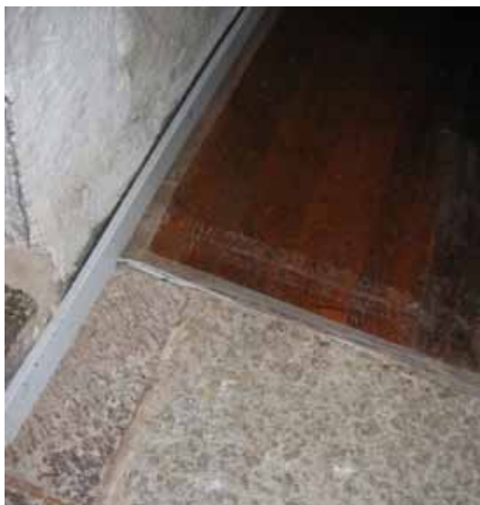
Elinstallationer i kyrkan som tillkommit succétt sedan 1930-talet är dragna synliga i kabelskenor längs yttreväggarna. Vissa kabeldragningar, såsom vid installationen av ljudanläggning, hade skett högst okänsligt, i närheten av muralmålningar.
