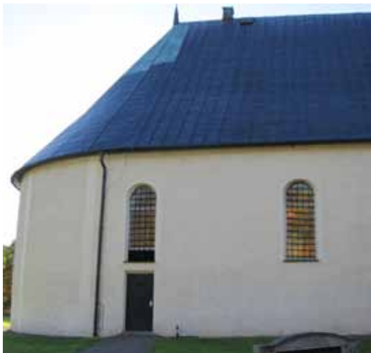
Det nya uteluftsdonet mynnade med ett ventilgaller i fönsteröppningen över pannrumsdörren i nordfasaden.
