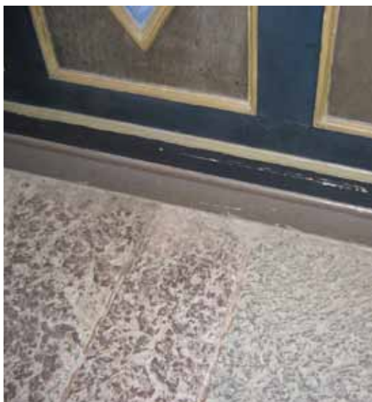
Kalkstensgolvet i långhusets gångar består av både brunröd och grå kalksten. Ytbearbetningen skiljer sig mellan stentyperna, den brunröda har en kluven grovt tuktad yta medan den grå har en yta släthuggen med grov bredmejsel.
