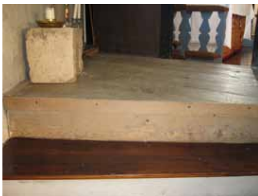
Återlagt plankgolv i norra korsakristian. Den enkla täcklisten mot ytterväggen återlades. Skarven mellan plankgolvet och det översta trappsteget vid nödutgångstrappan täcktes med en äldre hyvlad trälist fäst med mässingsspik.
