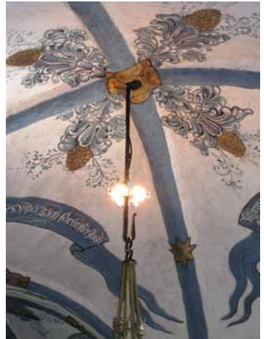
Den nya kranshalogenarmaturen på korets ljuskrona.
