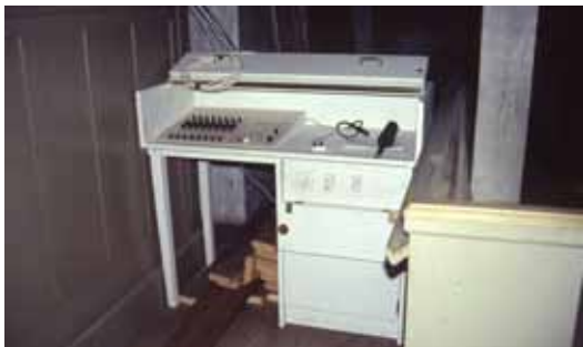
Den förutvarande manöverpanelen.
