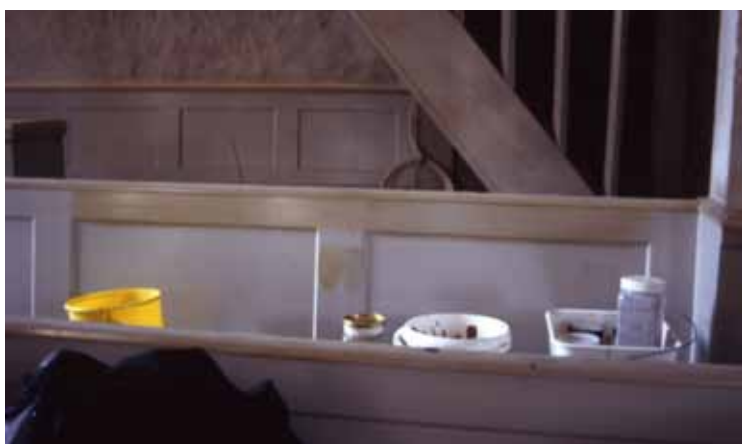
Uppstrykningsprov med linoljefärg och pigmenterad linoljefernissa gjordes för att erhålla samma grågröna kulör som tidigare.
