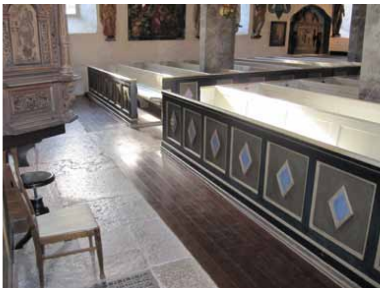
Golvet återställdes provisoriskt med ett fernissat brädgolv.
