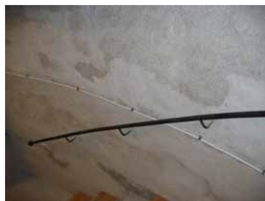
Demonteringen av den okänsligt dragna kabeln till ljudanläggningen under muralmålningen i norra sakristian utfördes av byggtreprenören. Fästklammern togs försiktigt bort av konservator som även lagade ut infästningshålen.
