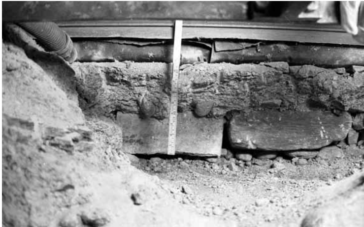
Kvaderhuggna kalkstenblock som påträffades under betongplattan i långhusets främre norra tvärgång. Schaktets främre del ligger i linje med främre bänkskärmen (i dess läge före demoneringen av främre bänkraden).
