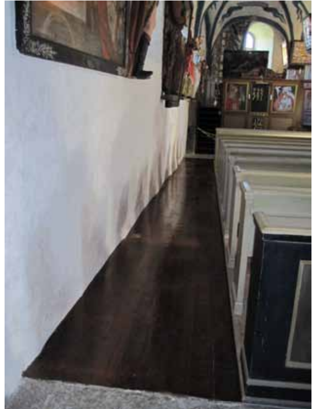
Den ena sidogången i långhuset med återställt fernissat brädgolv. Den påtagliga elkabelskenan längs ytterväggen har försvunnit.
