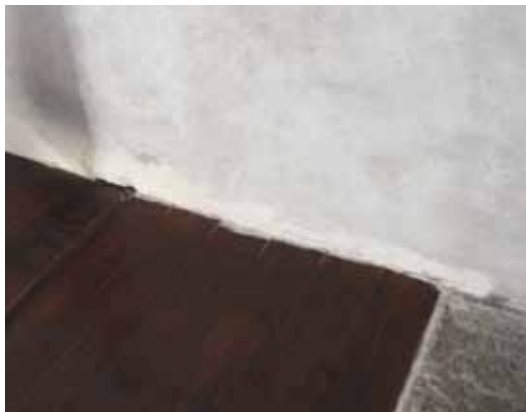
Exempel på putslagning i höjd med ena sidogångens golv. Lagningen är ännu inte retuscherad.
