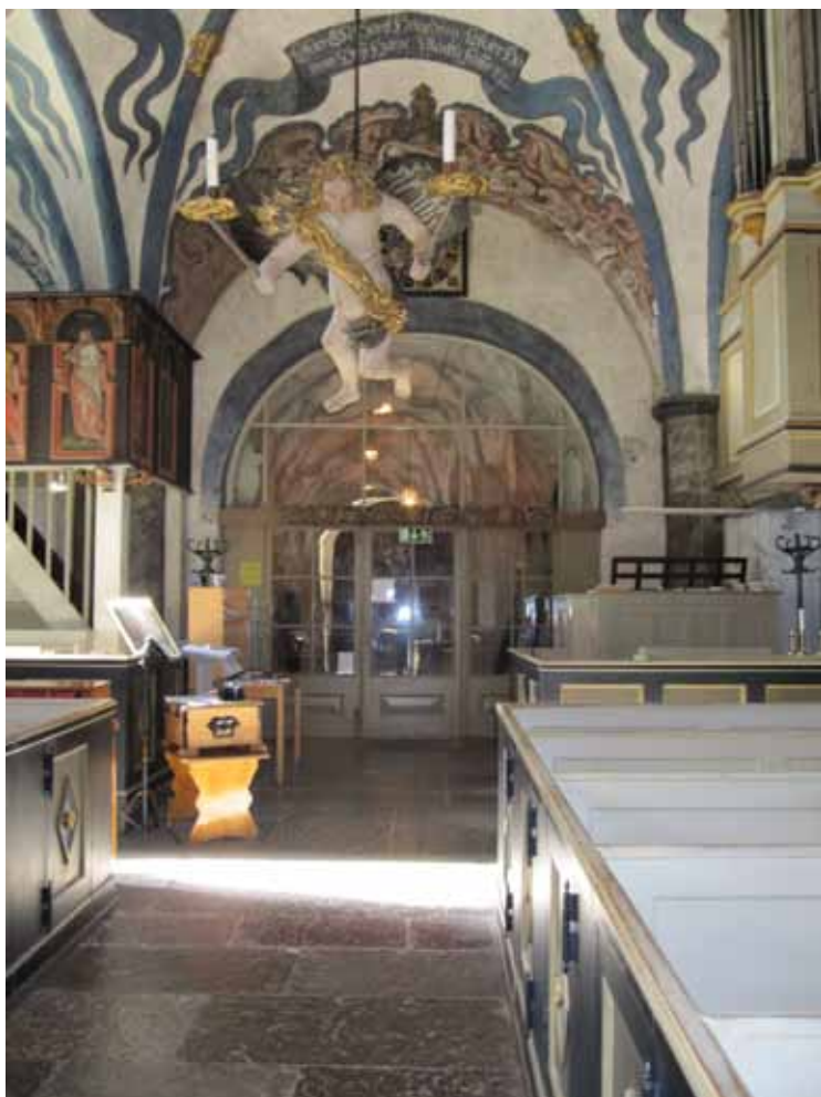
Glaspartiet mot vapenhuset byggdes om med en invändig isolerruta, för att bli tätare.
