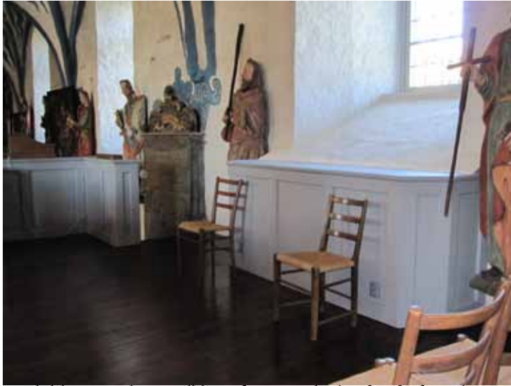
Djäneläktaren med sitt nytilskott i form av ett lågskåp framför fönsterbröstningen. Skåpet rymmer tillsammans med den förhöjda fönsternischen uteluftskanaler.
