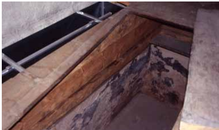
Efter installationen av det nya luftdonet återställdes väggarna med en timmerliknande inklädnad.
