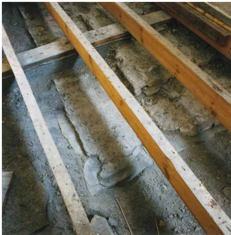
Det gjutna fundamentet till ett äldre altarpodie med två etager. Foto: Göran Sandstedt.
