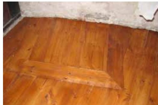
I det nylagda korgolvet återskapades två sekundärt igensatta öppningar som flankerar altaret. Golvet är i det här skedet endast laserat och ännu inte fernissat.
