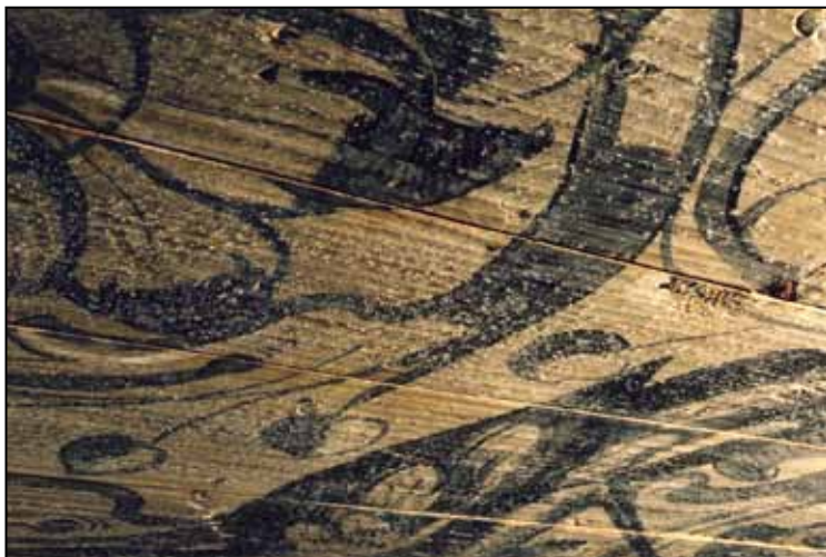
Mögelangreppet i kyrkorummet hade en allmän spridning. Till de värst angripna ytorna hörde det bemålade taket under orgelläktaren. Foto: Bibi Pålénäs, JLM, 2005.
