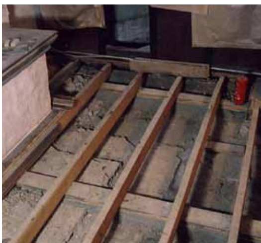
Under det upptagna korgolvet påträffades gjutna fundament till altarpodiet. Foto: Göran Sandstedt.
