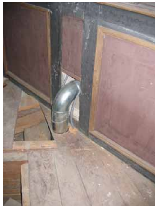
Frånluftskanalen till Brahegraven nyttjar befintlig ventilöppning i skranket i södra korsakristian. Här före inklädnad.
