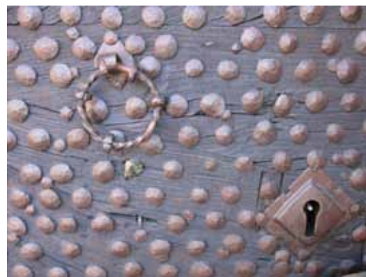
Porten efter behandling med s k Roslagsmahogny, bestående av trätjära, linolja och terpentin.
