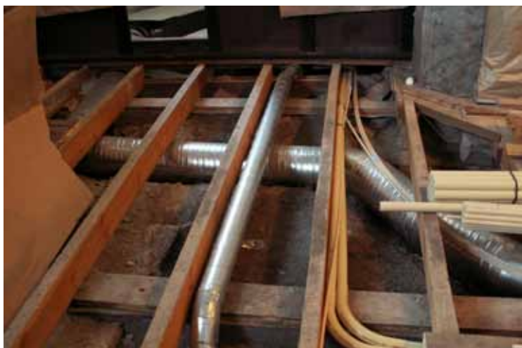
Kanaldragningarna i korgolvet. Foto: Byggkompaniet i Mälardalen AB.
