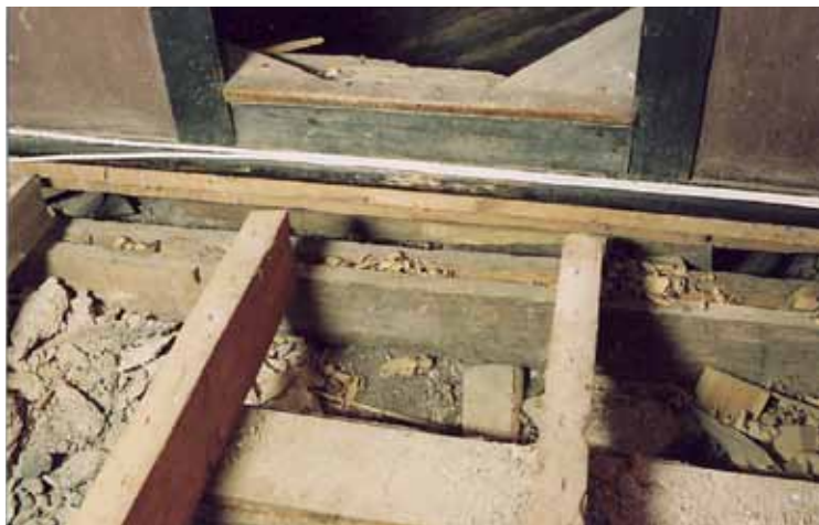
En äldre, troligen, ursprunglig syll till korskranket mot den södra korsakristian påträffades under det förhöjda korgolvet. För dragningen av den nya varmlufts-kanalen fick ett ingrepp göras i syllen. Foto: Göran Sandstedt.
