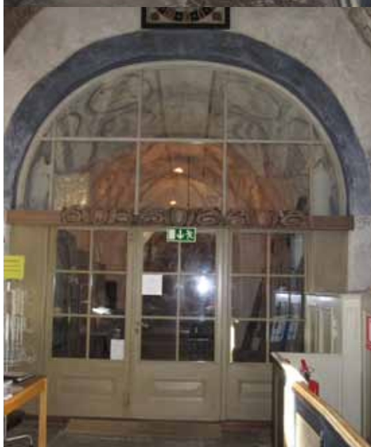
Glaspartiet mot vapenhuset byggdes om med en invändig isolerruta, för att bli tätare.
