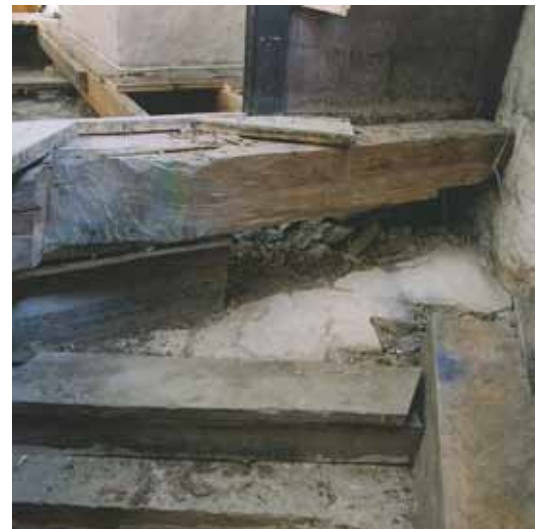
Då plankgolvet togs bort i den södra korsakristian påträffades en gjutning av kalkbruk 42 cm under golvnivån. Detta är sannolikt rester efter sättbruk till ett äldre kalkstensgolv. Här har även vinkällarens sekundära timmerväggar och trappsteg tagits bort. Foto: Göran Sandstedt.
