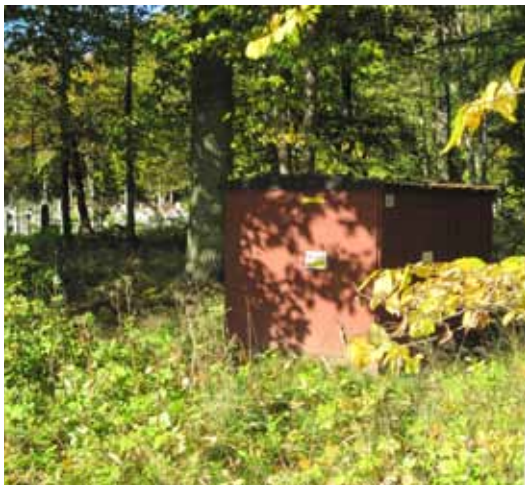
En ny transformatorstation anlades strax norr om nya kyrkogården.
