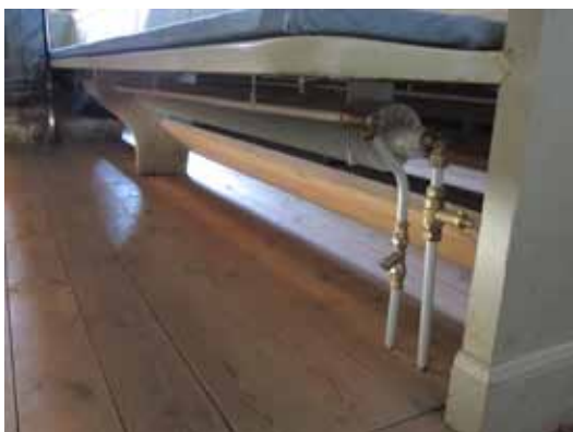
Kapaciteten i värmesystemet höjdes genom ny vattenburen bänkvärme.
