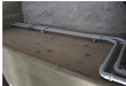
Synlig rördragnings tilläts på Rösaläktaren.
