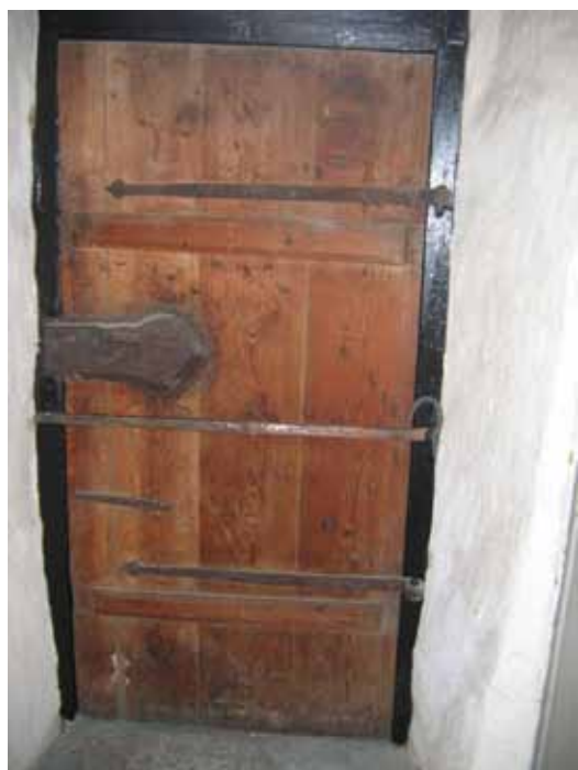
Den inre medeltida dörren till sakristians ytterport försågs med en tvärså av smide, för att fullständigt tillslutas. En gammal s k fästmansstång till en spiskåpa användes vars ände smiddes om till en krok av en lokal smed.
