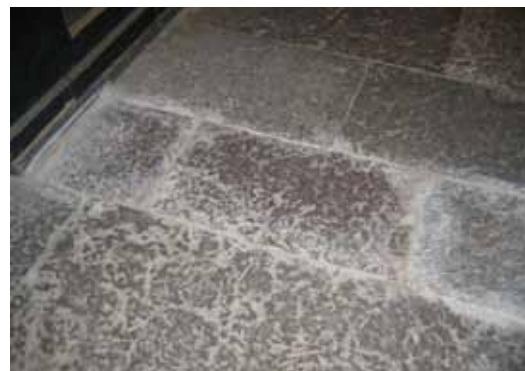
Återlagt schakt av kalkstensgolvet.
