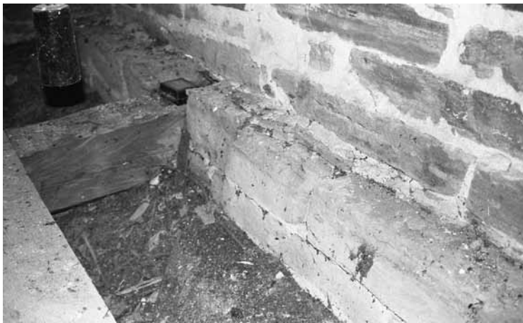
I den nedre tornvinden vilar golvbjälklaget på urtag i en murklack i yttermuren. Murklacken bör utgöra en konstruktivt betingad avtrappning av muren. Här den norra tornmuren.
