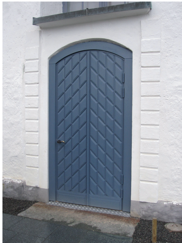
Ovan: Jutsering av trappsten. Höger och nedan: Sydingången efter att trappstenens höjd justerats, gångvägen stenbelagts och ytterdörren bytts.
