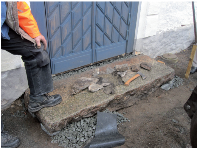
Ovan: Jutsering av trappsten. Höger och nedan: Sydingången efter att trappstenens höjd justerats, gångvägen stenbelagts och ytterdörren bytts.
