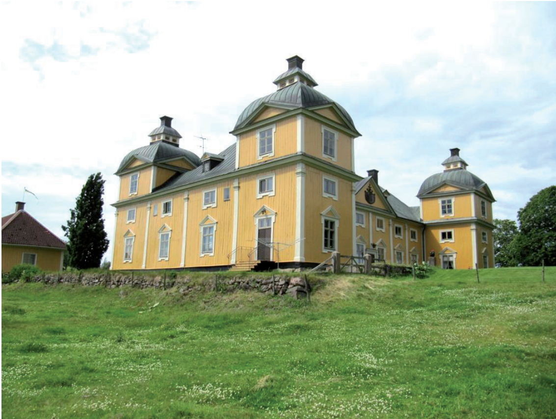
Fasaderna från nordost. Foto 2012.
