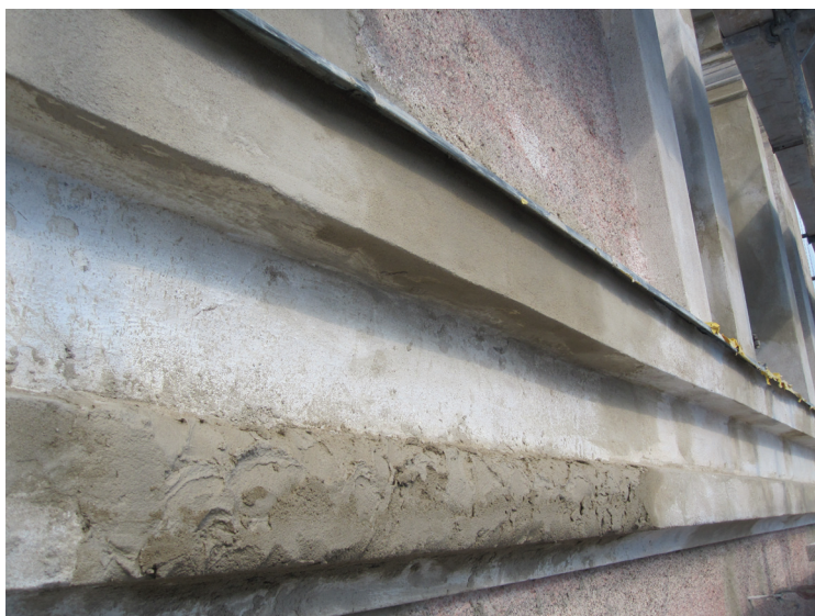
Lagningar av putsskador på tornets nedre gördellist.
