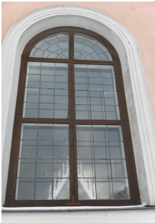
Ett av långhusets fönster för renovering.
