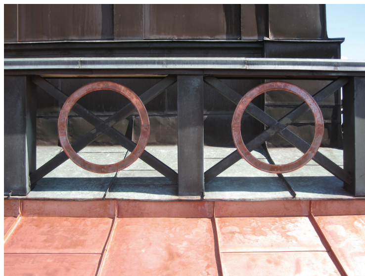
Torntakets koppartäckning fick göras om. Några av de dekorativa cirklarna på kopparplåt till staketet saknades och fick nyttillverkas.
