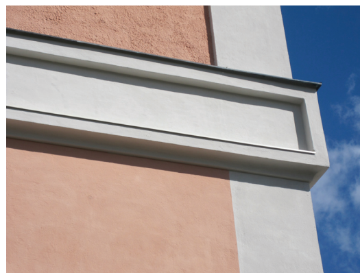
Kyrkans torngesims försedd en ny plåtavtäckning.
