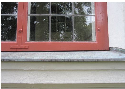
Fönsterbågarna återmonterades med befintliga bultar.
