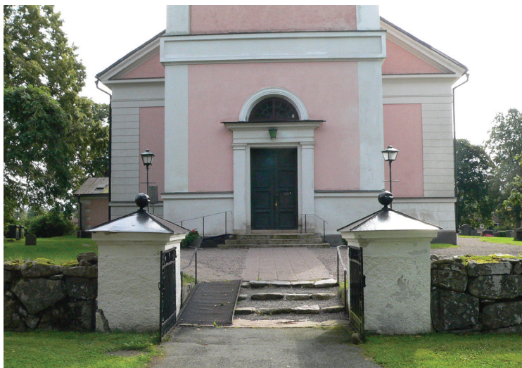
Grindstolparna var spritputsade och avslutades uppåt med en bred profilerad list. De var avfärgade helt i vitt.
