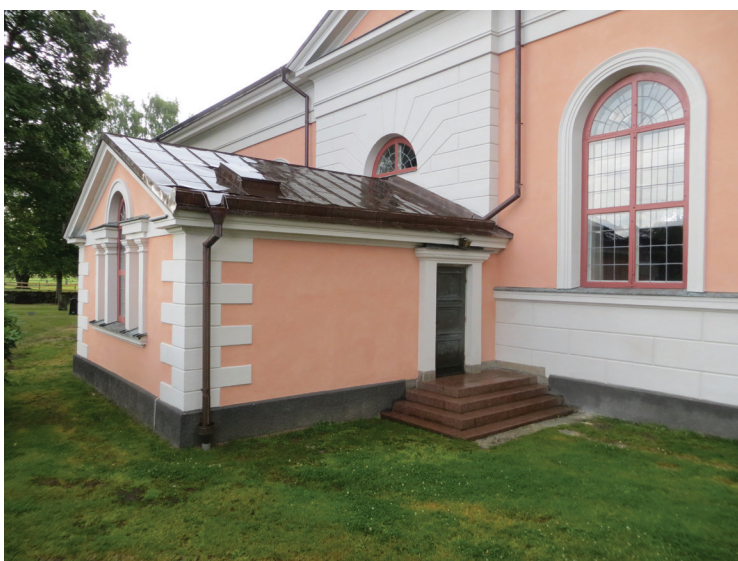
Sakristians fasad efter restaureringen.
