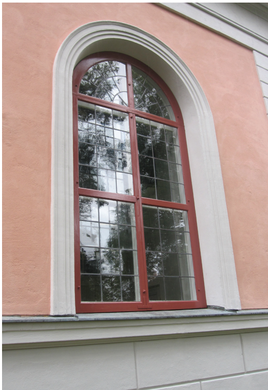
Ett av långhusfönstren efter renovering.
