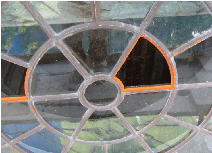
Gjutjärnsfönstret i tornets västfasad under renovering.
