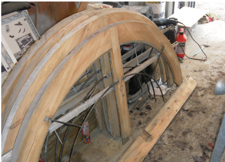
Några av de halvbågsformade fönsterbågarna från långhuset efter färgborttagning.
