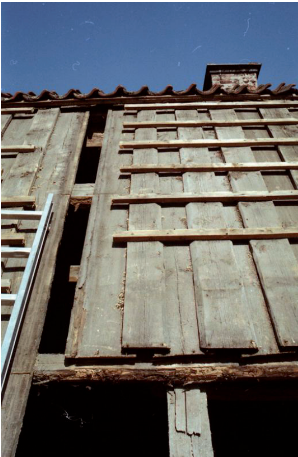
Underpanelen för takteglet. Foto från söder. Foto 2004. BEK.
