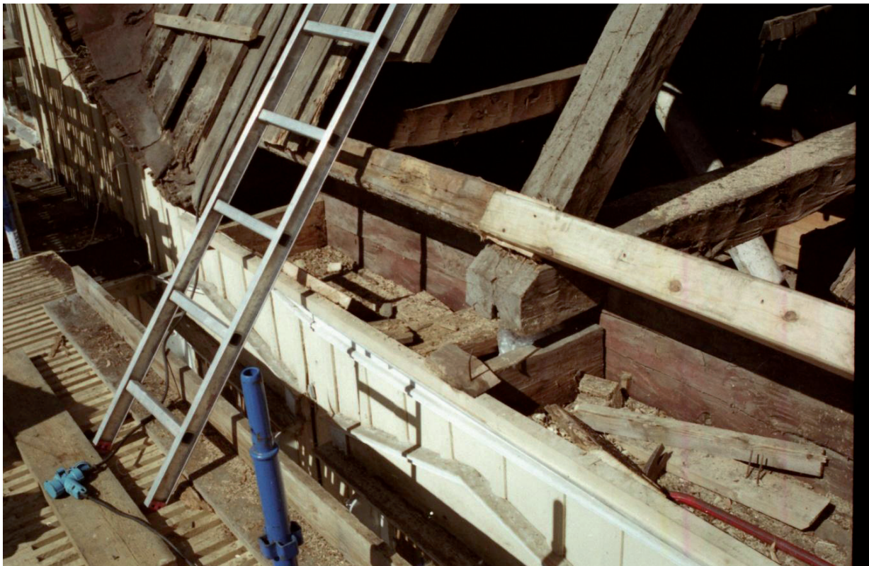
Takfoten från sydost. Den blottlagda rödfärgade timmerväggen med utknut. Foto 2004. BEK.
