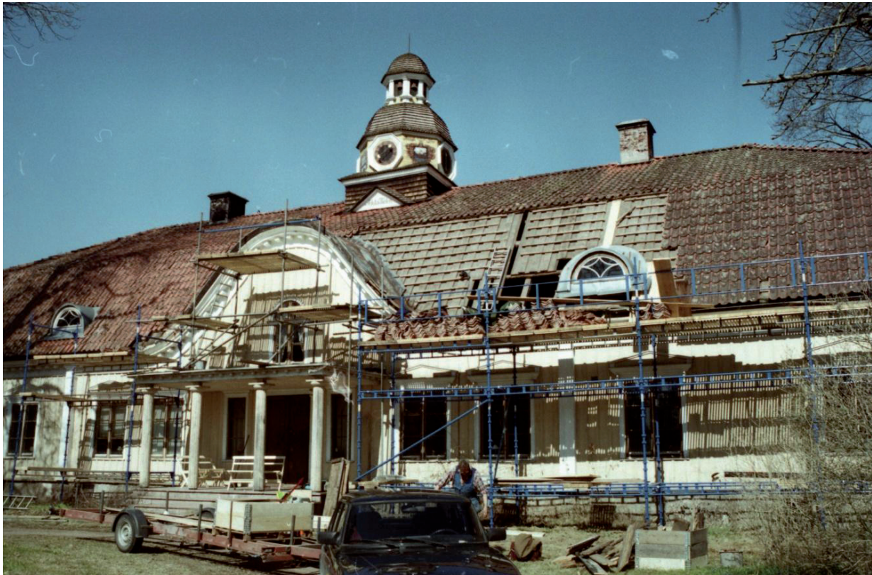
Herrgårdsbyggnaden från sydost under restaurering. Mittpartiet med klocktornet. Foto 2004. BEK.
