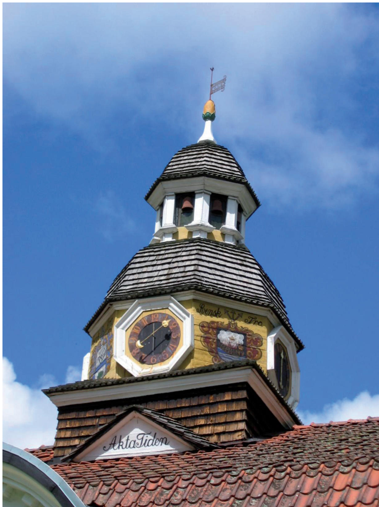
Herrgårdsbyggnaden från sydost efter restaureringen av plåtarbeten på nedre delar av klocktornet. Foto 2005. BEK.
