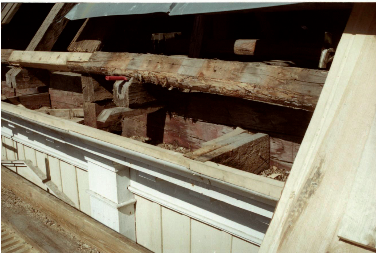
Takfoten från sydost. Den yttre panelen och den blottlagda rödfärgade takfoten. Foto 2004. BEK.
