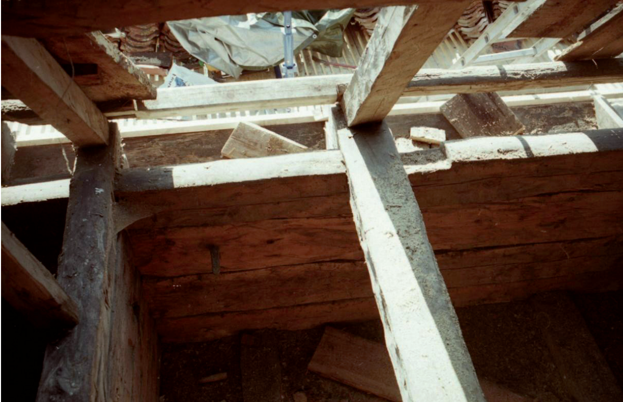
Takfoten från insidan av vinden mot söder. Yttervägens insida och takstolar. Foto 2004. BEK.
