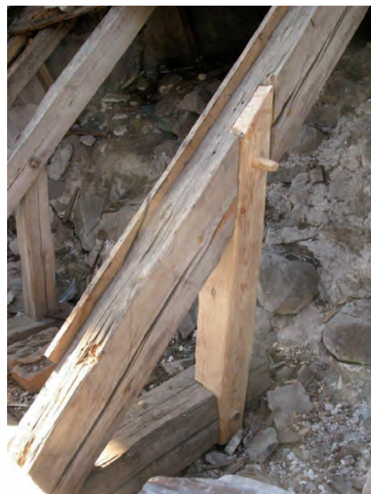
En av takstolarna på sakristian kompletterad med ett nytt stödben.
