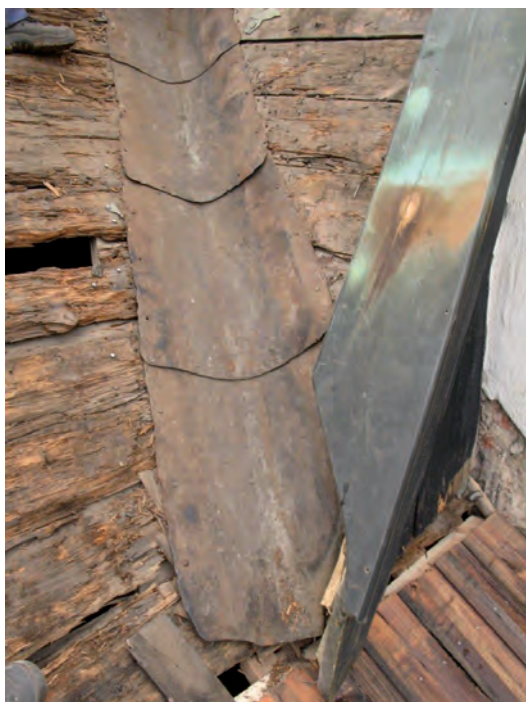
I botten fanns en äldre rännal av smidda, nitade plåtar.
