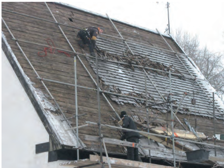
Rivning av spån på långhusets norra takfall.
