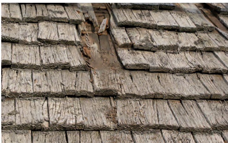
Detaljer av befintlig ekspåntäckning på södra sidan.
