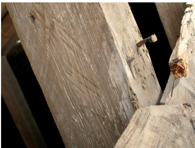
Detalj av högben med sprättäljning och spår av vit kalkfärg.
