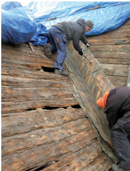
Demontering av befintlig rännal mellan kor och sakristia.
