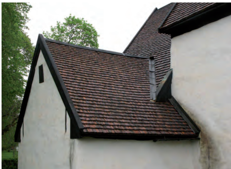
Det omlagda sakristitaket med den äldre rännalsbeklädningen återmonterad. Öppningen i gavelröset är återupptagen och försedd med en lucka.
