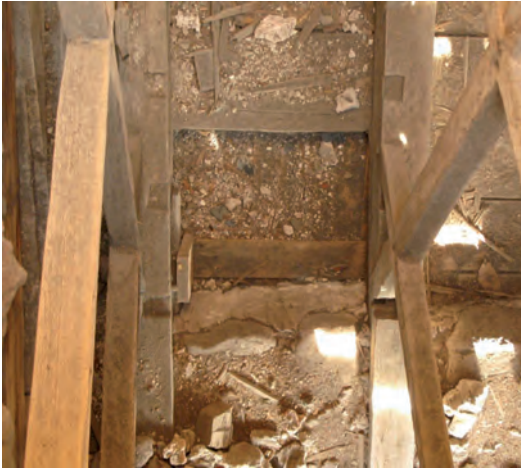
Tre parallella urtag i två av bindbjälkarna kan vara spår efter en upphängning av klockor.
