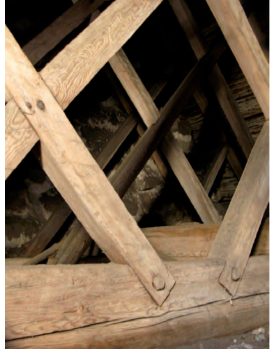
Infästningarna i bindbjälke är med dymlingar, i övrigt smidd spik.
