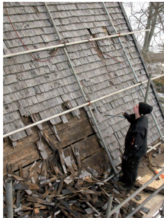
Rivning av spån på korets norra takfall.
