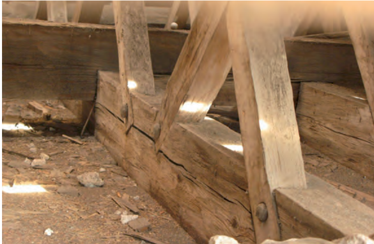
Stödbenens infästning i bindbjälke med spikskalleformade dymlingar. I bakgrunden styrplankan/bjälken.
