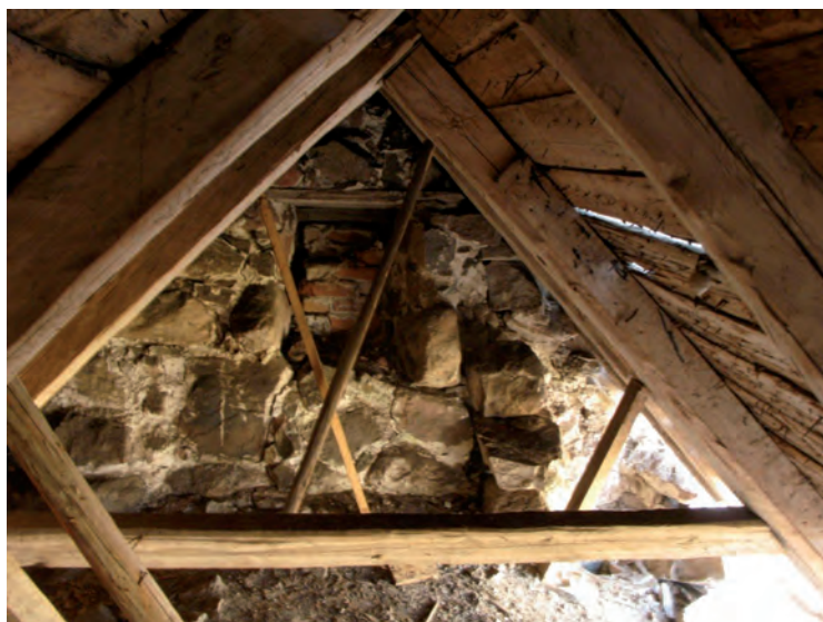
Sakristians gotiska taklag med knäbock och hanbjälkar. I gavelröset en igenmurad öppning. En av knäbockarna i öster saknar ett stödben.
