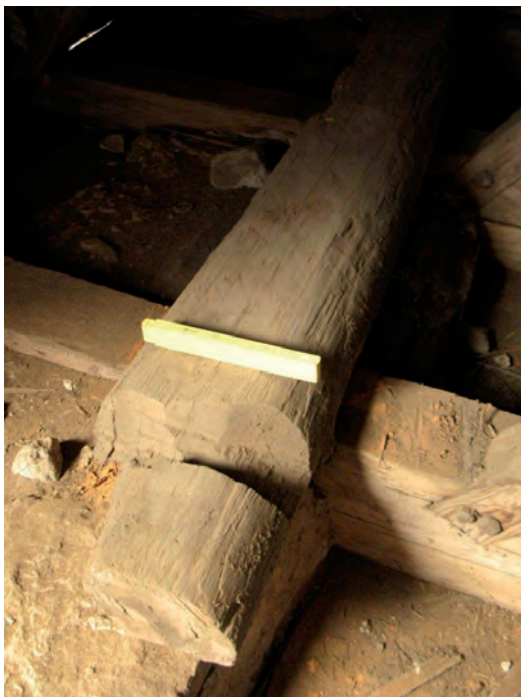
Halvklov av furu med urhuggning i ena änden, liggande löst på murkrönet. Bredd 26 cm, höjd 12 cm, längd 210 cm. Oklar ursprunglig funktion.
