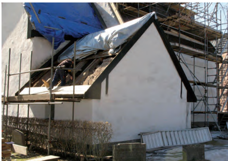
Montering av nya undertaksbrädor på sakristians östra takfall.
