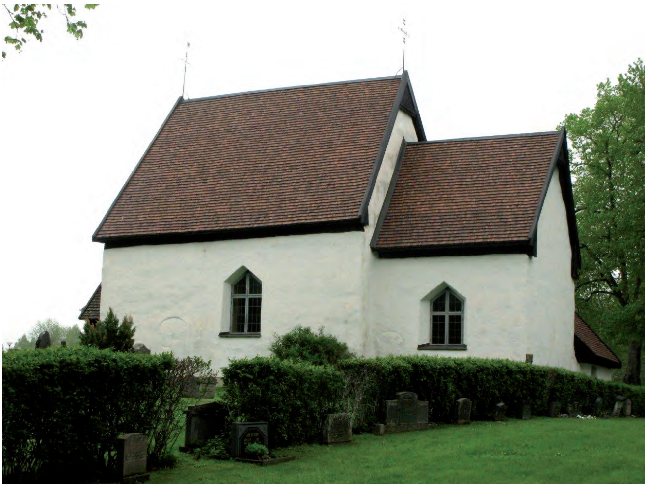
Norra Solberga gamla kyrka i maj 2013 efter avslutade takarbeten.
