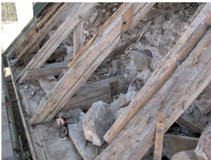
Sakristians gotiska taklag med knäbock och hanbjälkar. I gavelröset en igenmurad öppning. En av knäbockarna i öster saknar ett stödben.
