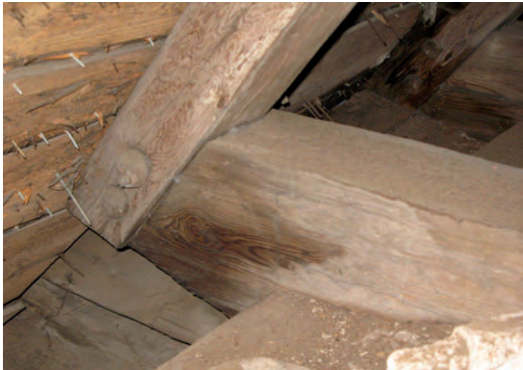
Möte mellan bindbjälke, högben och remstycke.
