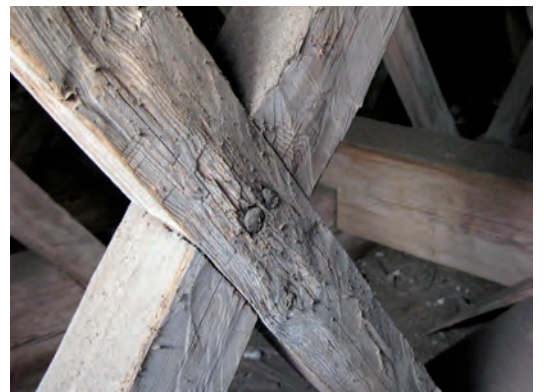
Infästningarna i bindbjälke är med dymlingar, i övrigt smidd spik.
