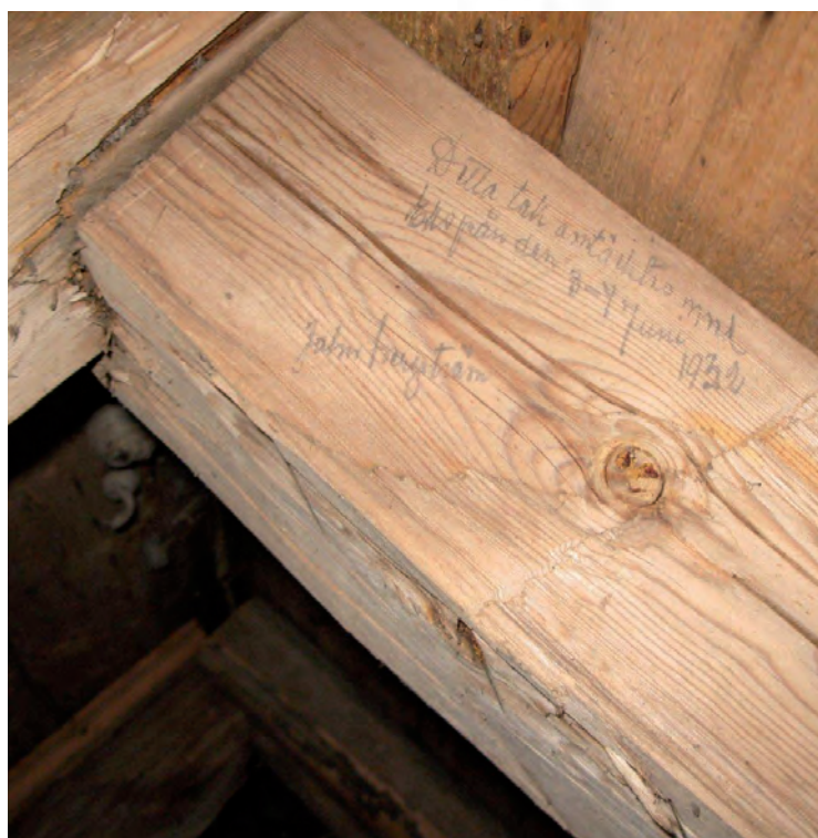
Inskription på ett av högbenen i sakristian rörande ny spåntäckning 1932.
