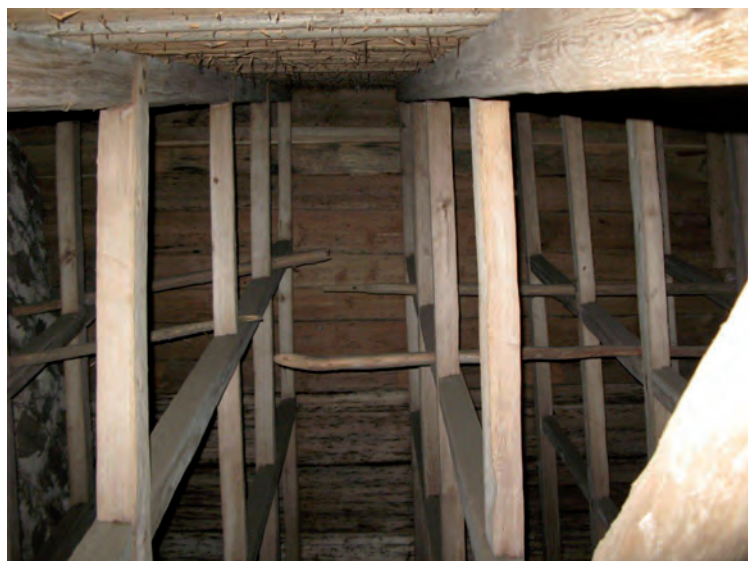
Korets taklag sett nedifrån.
