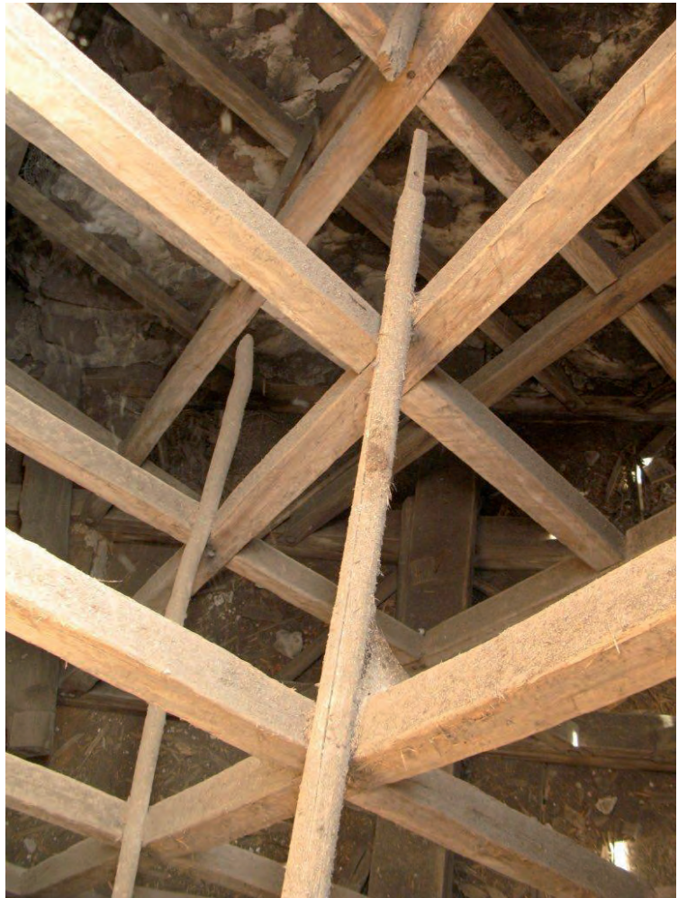
Korets romanska taklag med kryssade stödben, sett från ovan mot östgaveln.
