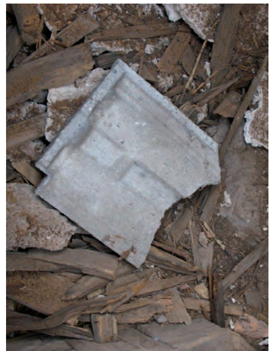
Betongpanna från 1910-talets taktäckning, återfunnen på sakristivinden.
