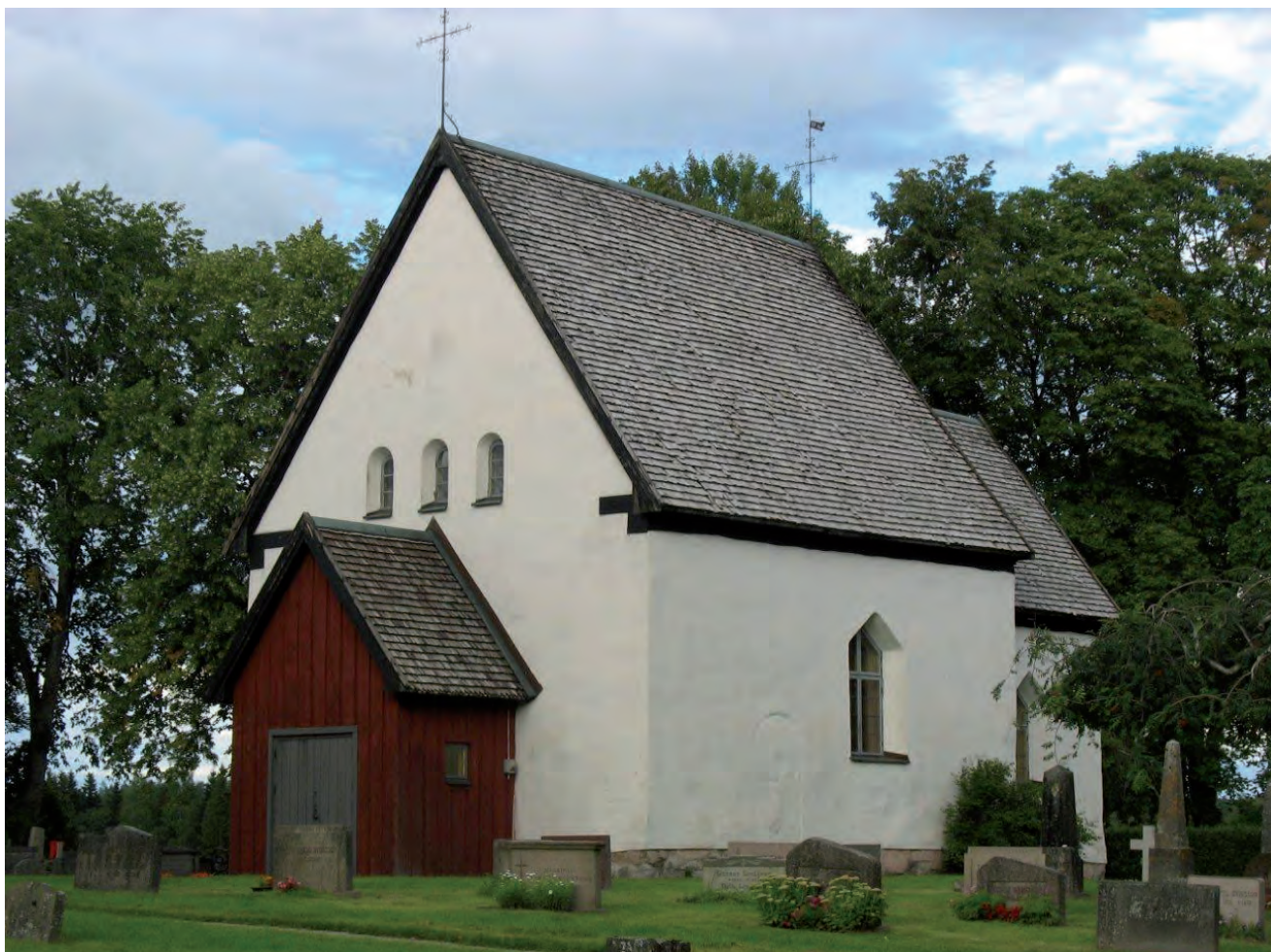
Norra Solberga gamla kyrka före arbetena. Befintlig täckning av ekspån från omkring 1930.
