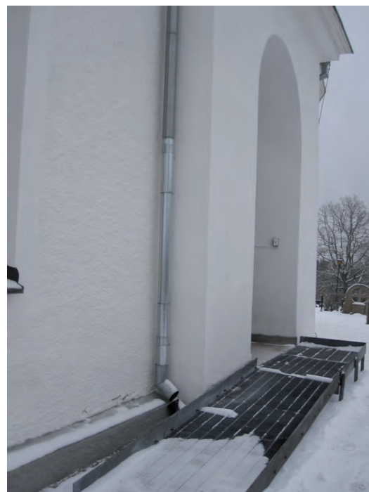
De skadade stuprören lagades.
