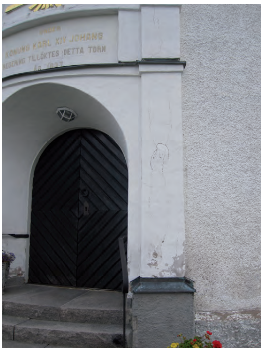
På portalens sydsida fanns sprickor i putsen. Dessa gick att härleda till ett inmurat järnbeslag.
