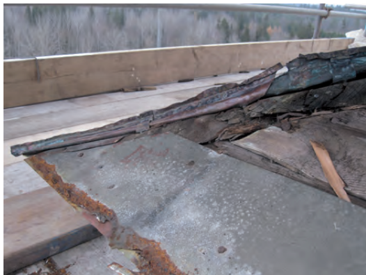
Ovan: det underliggande fästbläcket var rotskadat.
