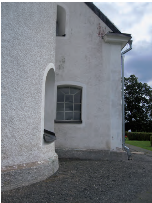
Avfärgningen hade dålig vidhäftning på de slätputsade partierna och viss algpåväxt fanns.
