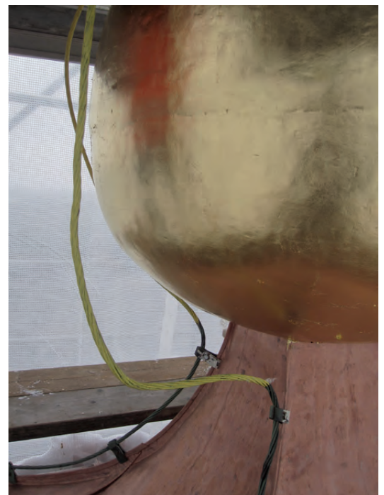
Åskledarens infästning.
