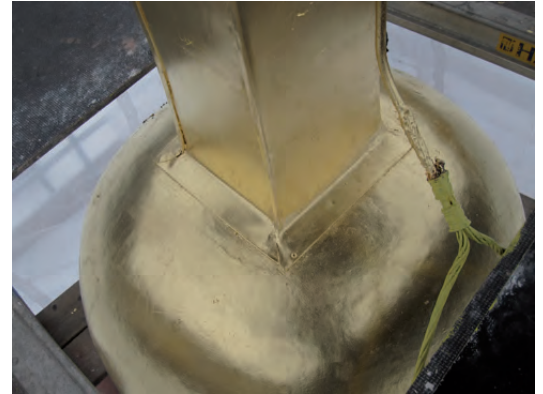
Korsets infästning i klotet.
