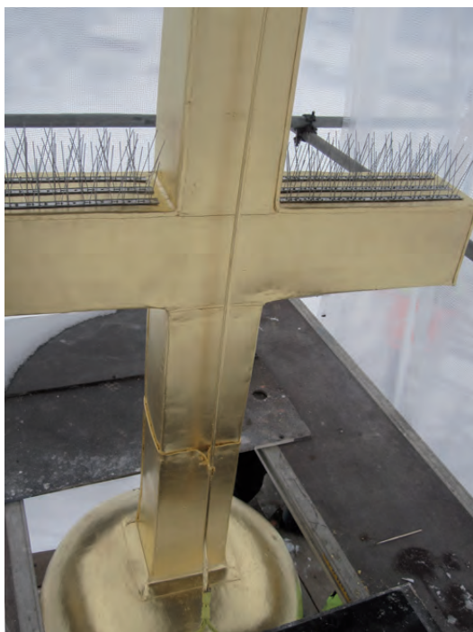
Ett fågelskydd monterades på korsets armar och topp. "Piggbanden" fästes med lim för att undvika skador på plåten.
