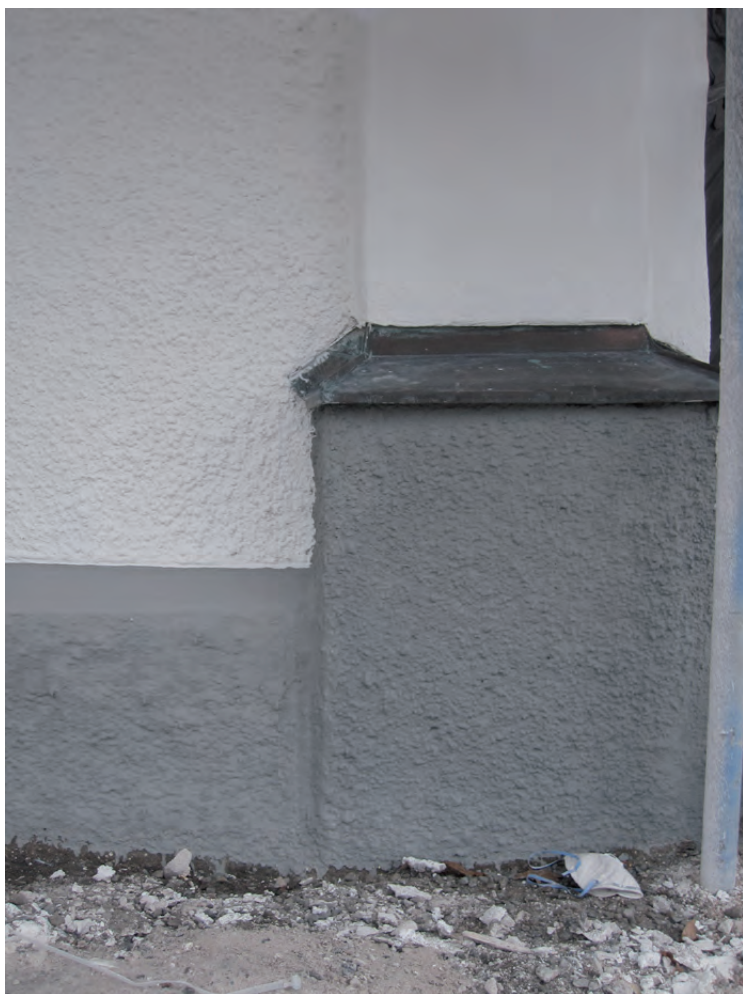
Sockeln avfärgades med en silikatfärg.
