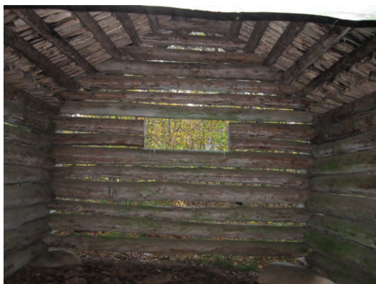
Ovan: Ängsladan i Linderås hembygdsgård är försedd med ett ålderdomligt och mycket ovanligt vedtak. Nedan: Ängsladan i Svenarums hembygdsgård.
