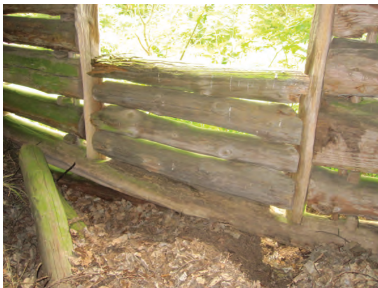
Denna ängslada i byn Lilla Fagerhult i Hässleby socken, Eksjö kommun, har en stängningsanordning där klens stockar med har i ändarna läggs mellan dörrrens sidostolpar.
