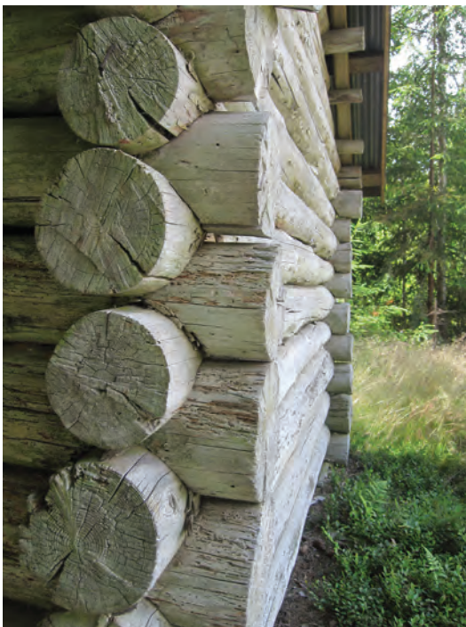
De timrade ängsladorna består av tämligen klen rundtimmer som är gles timrat.
