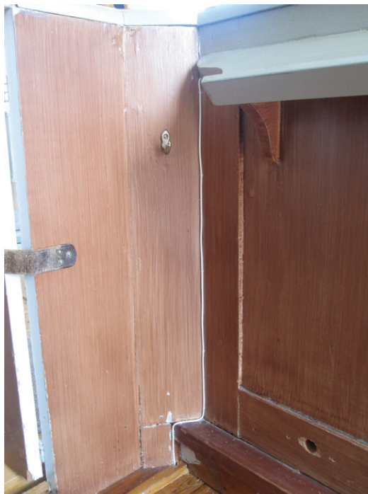
Kabeldragning för givare i koret.
