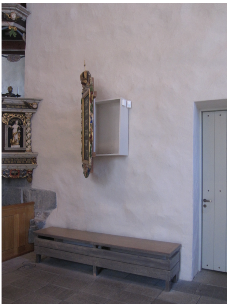
Givaren i koret är monterad på nummertavlans skåps-gavel.
