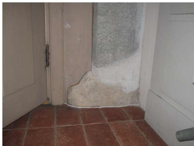
Till vänster och ovan, kabeldragningar i sakristian. Dels i skrudskåpet för givaren i Mariakapellet och dels på golvet för sakristians givare.
