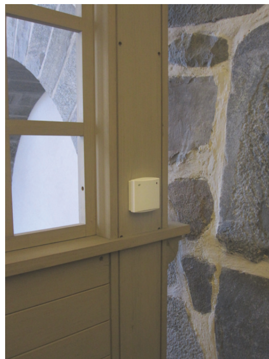
Ovan och till vänster, de två trådlösa givarna monterade på var sin sida av skranket vid orgeln.
