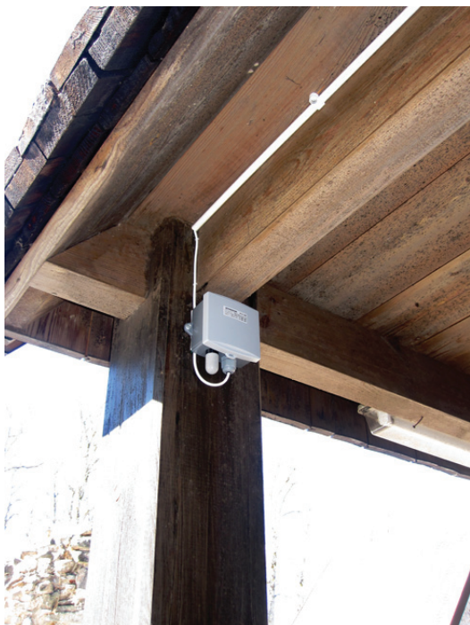
Nedan: Utomhusgivaren är monterad på förstukvistens södra stolpe.
