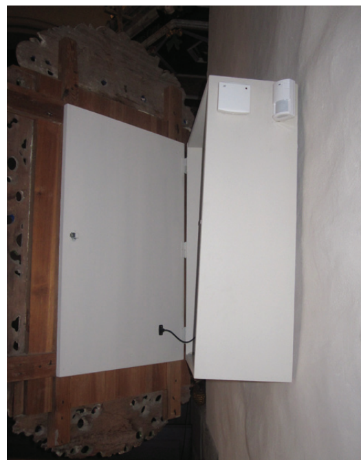
Givaren i koret är monterad på nummertavlans skåps-gavel.
