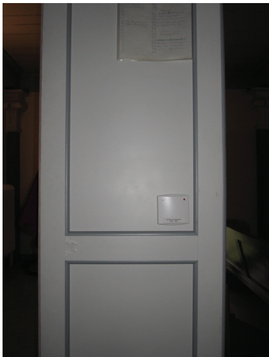
Givaren på orgelläktaren är monterad på gaveln på skåpet för körkåporna.
