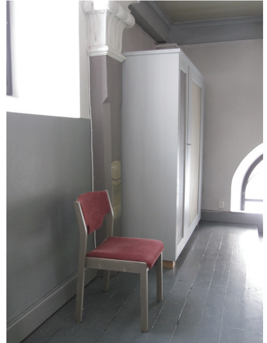
Skåp på läktaren i norra korsarmen före installation.
