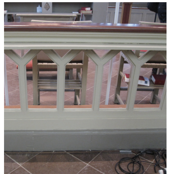
Koret före installation av extra eluttag på altarskrankets insida.
