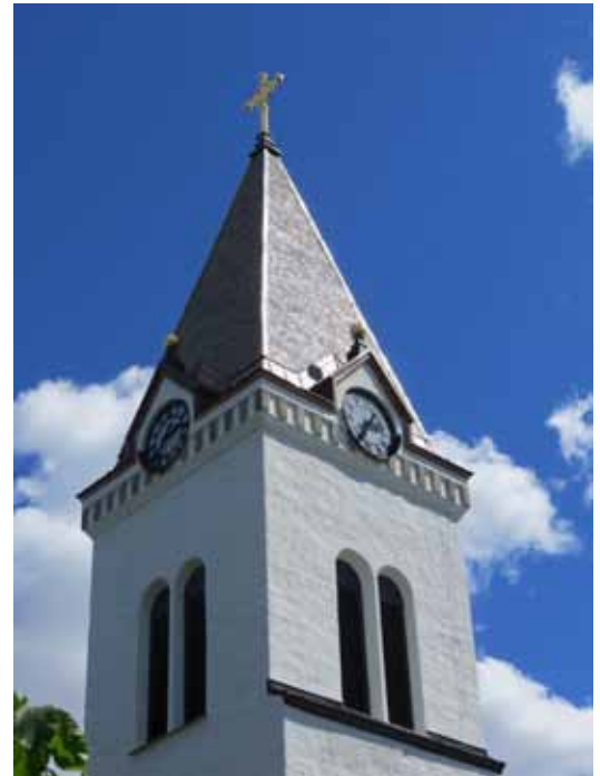
Kyrkans tornspira efter att arbetena avslutats.
