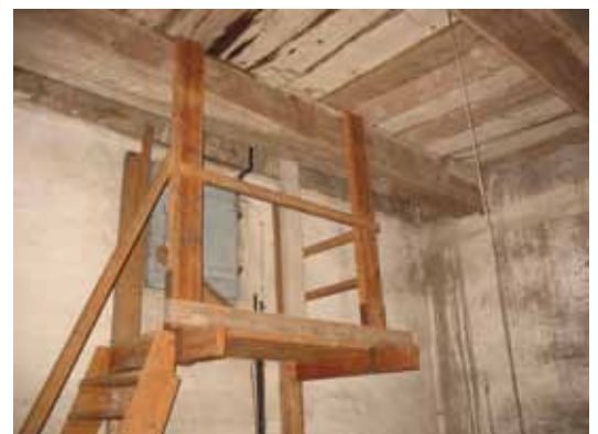
Den gamla ingången till långhusvinden.
