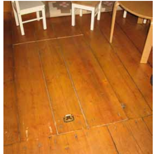
Ovan: Två nya golvluckor togs upp i golvet under läktaren. Nedan: Flertalet av de ventilationshål som fanns i långhusets sockel murades igen med skifferplattor för att förhindra ej önskad ventilation.
