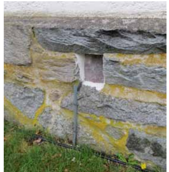
Ovan: Två nya golvluckor togs upp i golvet under läktaren. Nedan: Flertalet av de ventilationshål som fanns i långhusets sockel murades igen med skifferplattor för att förhindra ej önskad ventilation.
