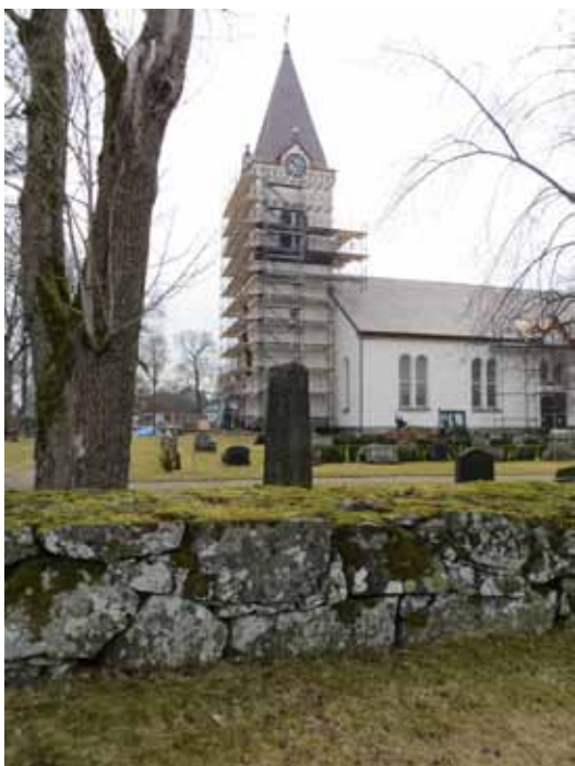
Här har arbetena med tornet påbörjats.
