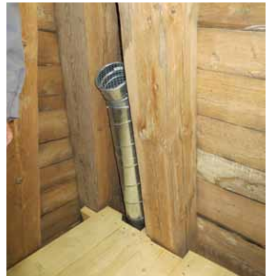
Ovan: Mynningen på avfuktningssystemets rörsystem i höjd med spiran.
