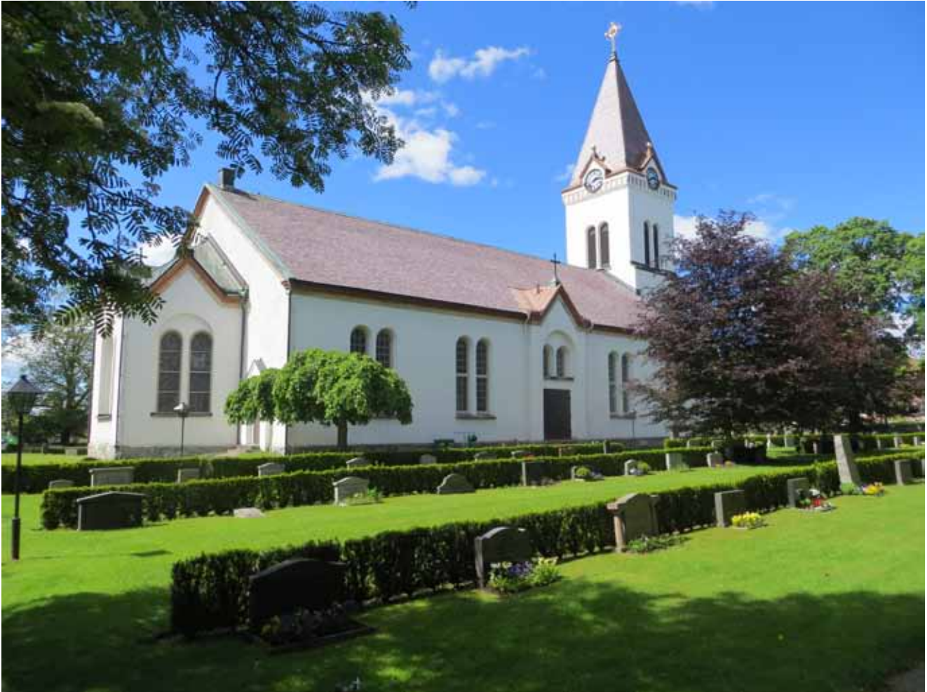
Kyrkan sedd från sydost efter att arbetena avslutats.
