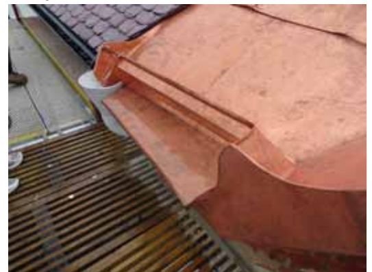
Nedan: Vattenavrinningen vid sidoingångarna gjordes om med mer ändamålsenliga ståndrännor och nya stuprörslägen.
