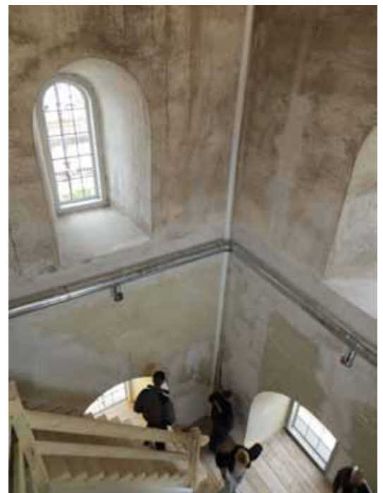
När ett bjälklag i tornet uteslöts skapades ett mycket speciellt rum med många meters takhöjd.
