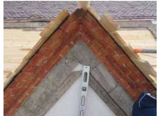
Ovan: Gavlarna fick delvis muras om och teglet kompletteras med nytt identiskt.
