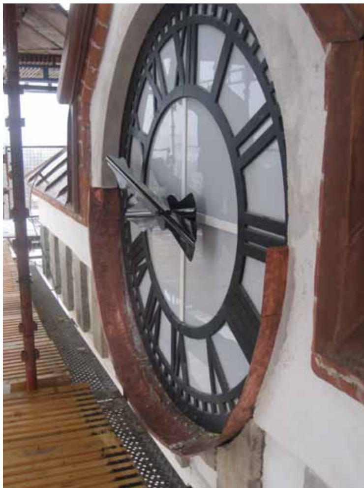
En av urtavlor efter restaurering.
