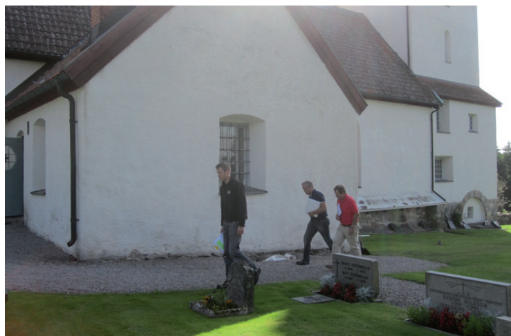
Genomföringarna i muren lokaliserades till sakristians gavel mot norr, under marknivå.
