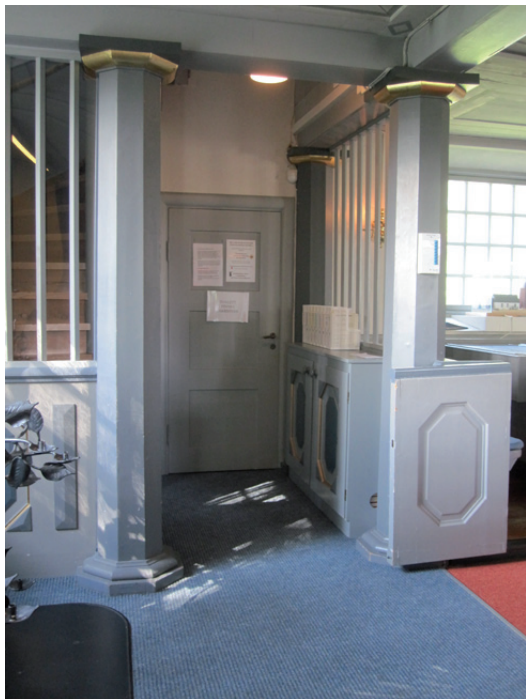
Kolonnerna under läktaren, före installation.
