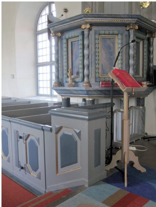
Koret och predikstolen, vid sidan om fönstret syns den tidigare styrenheten för värmen.
