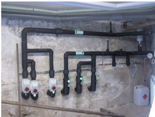
Ovan: ledningsdragning i pannrummet, inkommande rör från respektive borrhål.
