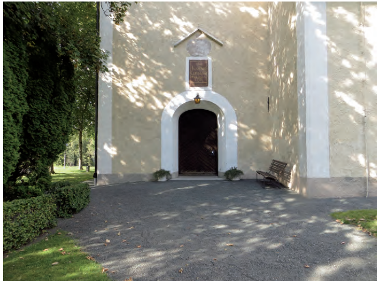
Översikt vid entrén.
