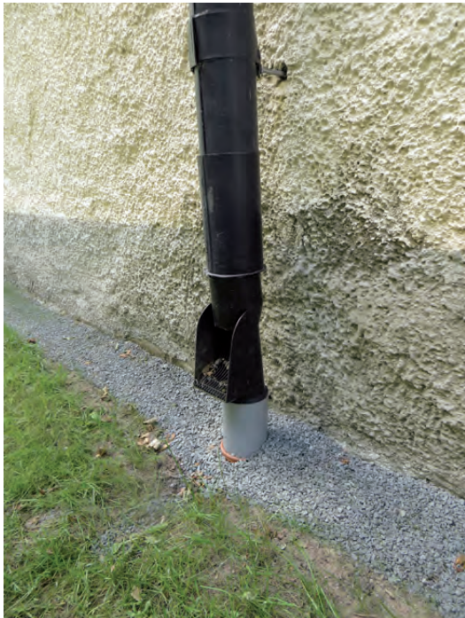
Marken närmast kyrkan återfylldes med singel. Röranslutningen mot mark ska målas lika stupröret.
