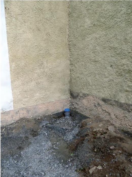
I vinkeln mellan tornet och långhuset förbereddes för ev. framtida stuprör.
