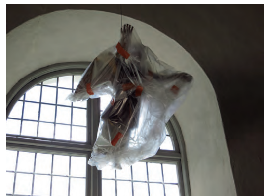
För att skydda inventarierna under byggarbetena täcktes de in. Särskilt omtåliga inventarier täcktes av konserver.
