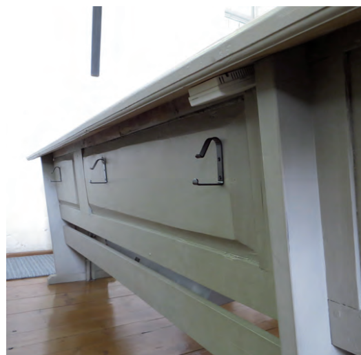
Givarna i kyrkorummet monterades under psalmbokshyllan, vilket är en mycket diskret placering.
