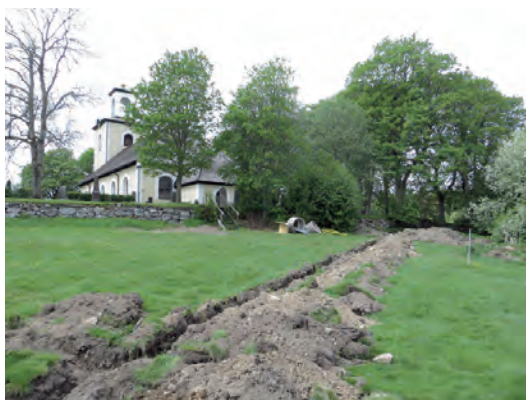
Ledningsgrävning för ingående el.
