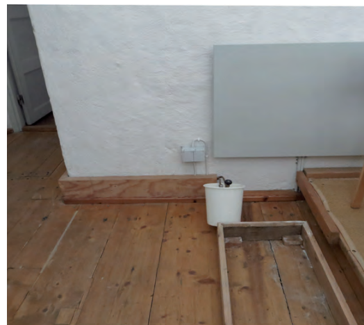
Den tidigare avfuktaren på läktaren och installationerna till denna demonterades.
