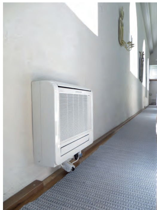
Konvektorerna vägghängdes.
