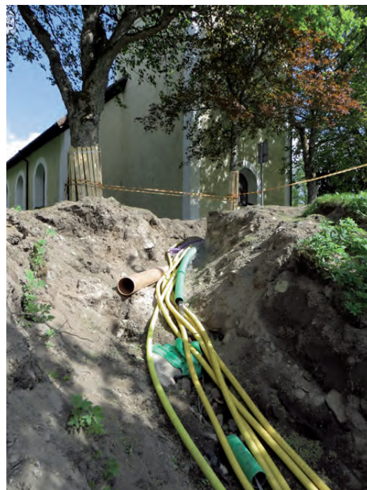
På kyrkogårdens västra sida fanns sedan tidigare ett genombrott i kyrkogårdsmuren som kunde nyttjas för de nya ledningsdragningarna.
