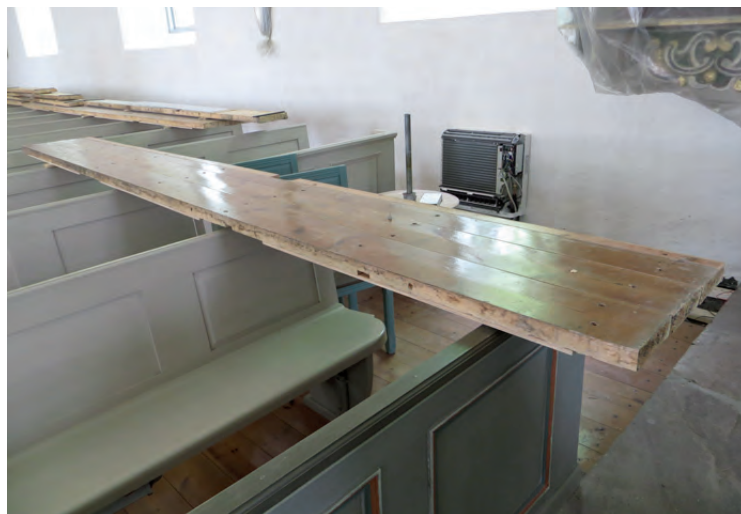
Installationerna till respektive konvektor doldes sedan av en specialbyggd sockel som målades in mot väggen.
