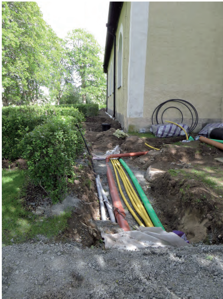
Vatten- och elledningar lades i rör som trycktes under muren i öster.
