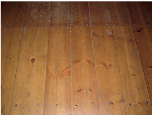
Ovan: Sakristian före åtgärd, samt detalj av golvet.
