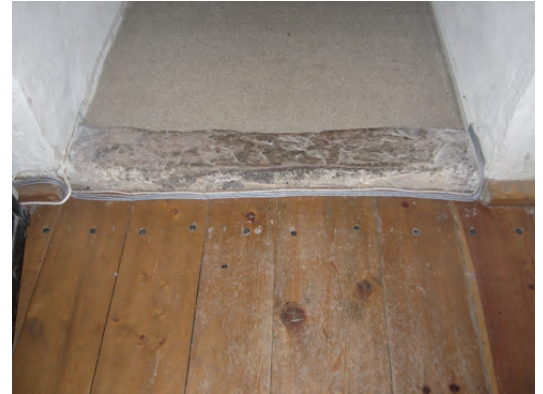
I samband med utförda arbeten rensades också ett antal kablar bort.
