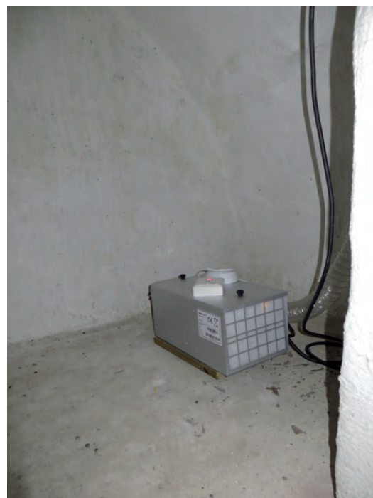
Avfuktaren i källarutrymmet under sakristian.
