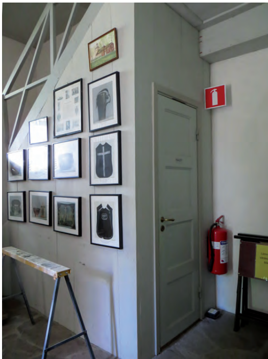
Vapenhuset före installation av givare. Notera lådan i taket, som döljer vattenledningen till den gamla avfuktaren på läktaren.
