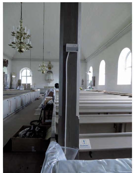
Det gamla styrsystemet hade traditionella termostater som bara utgick från temperatur.
