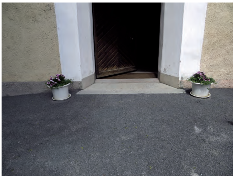
Uppfyllnad vid trappstenen för bättre tillgänglighet.
