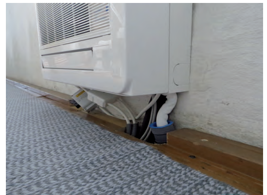
Ledningsdragningar till respektive konvektor.
