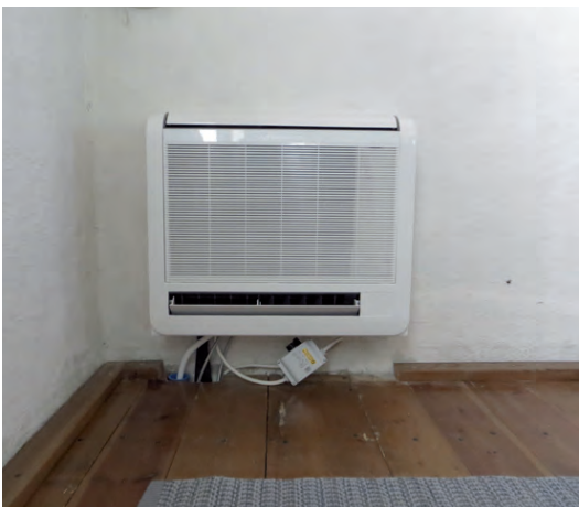
Installationerna till respektive konvektor doldes sedan av en specialbyggd sockel som målades in mot väggen.
