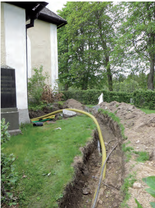
Ledningsdragning till sakristian. Håltagning i muren utfördes på byggnadens norra sida.
