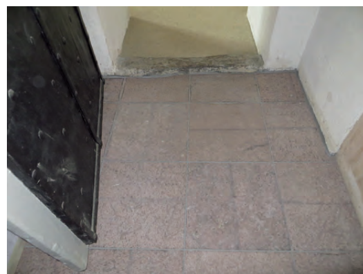
Det nya kalkstensgolvet i sakristian.
