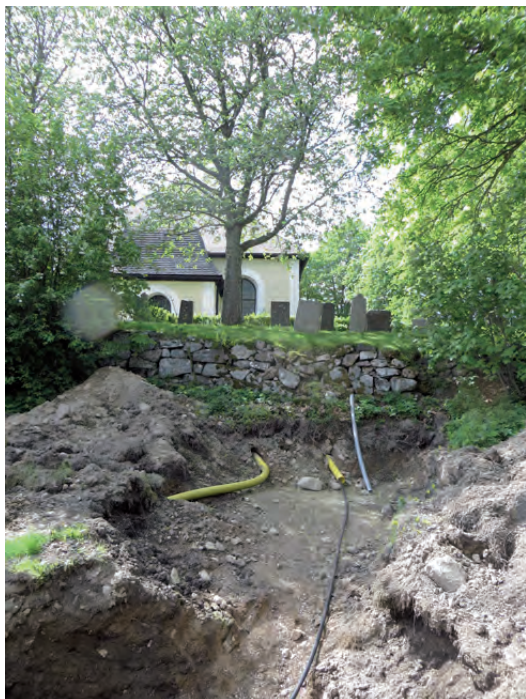
Vatten- och elledningar lades i rör som trycktes under muren i öster.
