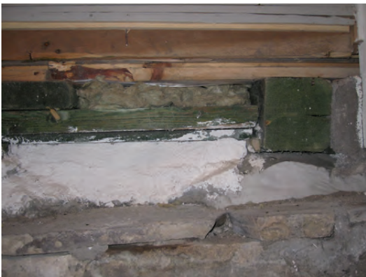
Golvkonstruktionen i sakristian var synlig från källartrappan.
