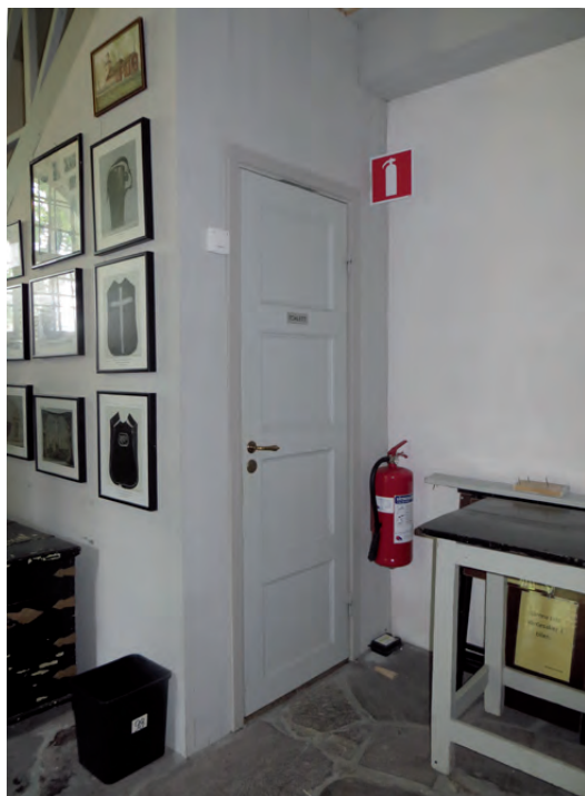
Givaren i vapenhuset placerades vid sidan om dörren in till toaletten.
