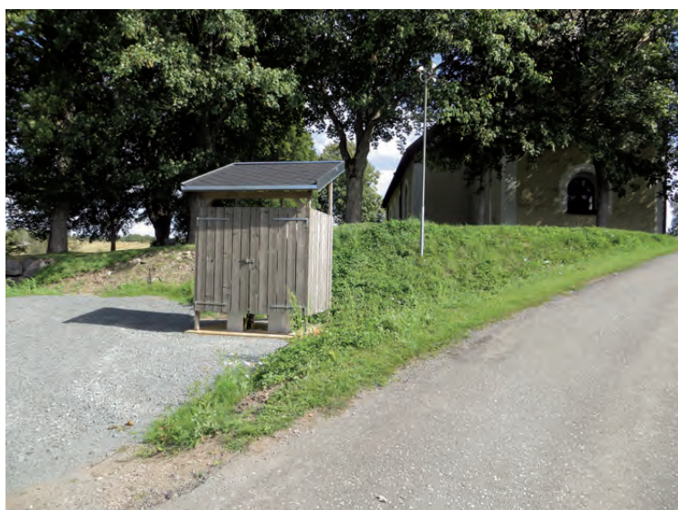
Väderskyddet för luftvärmepumpen ströks med järnvi-triol för att påskynda att virket skulle gråna.
