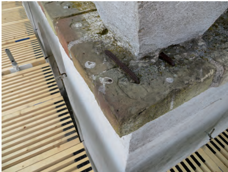
Ovan: Tornluckorna var i behov av ommålning. Nedan: En av tornets tegelgesimser med utsatt läge.
