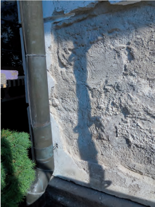
Här finns ett parti med lösa inre putslager och hårdare puts utanpå. Där det fanns uppenbara skador åtgärdades detta med en helt ny putsuppbbyggnad.
