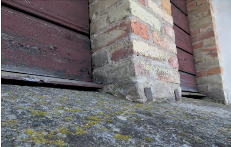
Ovan: Tornluckorna var i behov av ommålning. Nedan: En av tornets tegelgesimser med utsatt läge.
