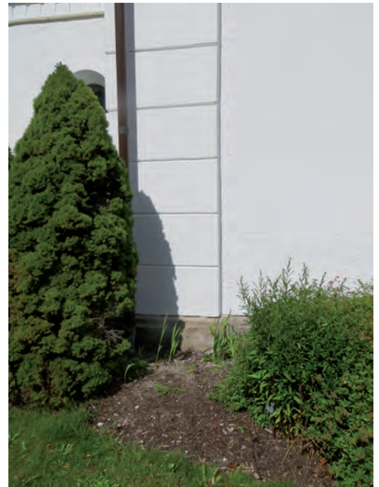
Nedan: Parti på sydfasaden som fick lagas i större omfattning.
