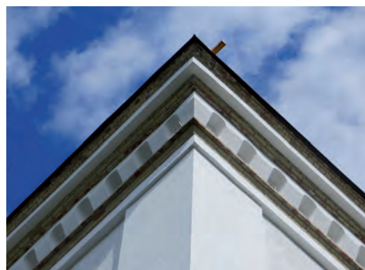
Ovan: För att skydda tegelgesimsen lades en sluttande putsavjämning ovanpå, vilken inte är synlig från marken. Nedan: Fågelbanden på tornkrönets utskjutande delar syns knappast från marknivån.
