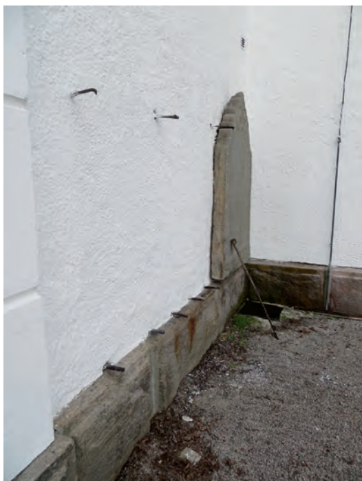
Ovan: Två av tre gravhällar demonterades inför arbetena och fasaden bakom dem behandlades som den övriga fasaden.
