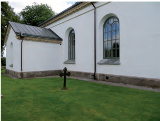
Här har stuprören bytts ut mot nya av fabrikslackat stål och trots detta är utseendeskilnaden inte särskilt stor.
