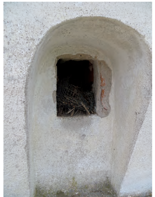
Vid nischerna i tornets krön finns ventilationsöppningar med bristfälligt skydd mot fåglar.
