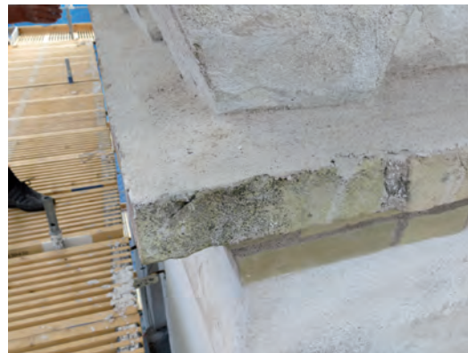
Ovan: För att skydda tegelgesimsen lades en sluttande putsavjämning ovanpå, vilken inte är synlig från marken. Nedan: Fågelbanden på tornkrönets utskjutande delar syns knappast från marknivån.
