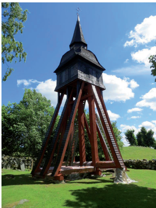
Klockstapelns spånklädsel nytjärad.
