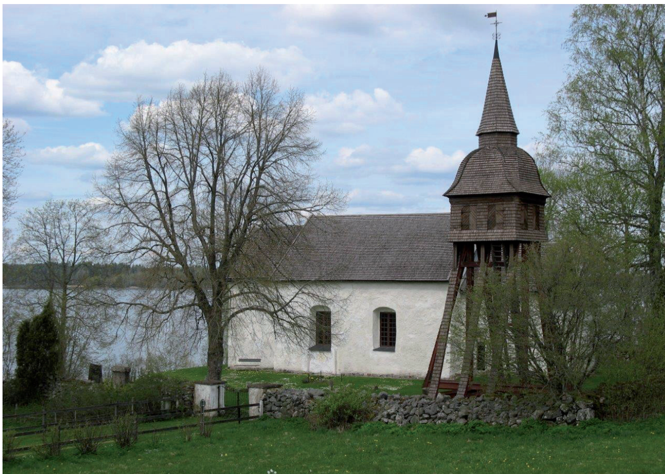
Vallsjö gamla kyrka och klockstapel. Fotot taget före genomförda arbeten.
