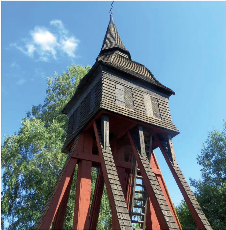
Klockstapeln efter avslutade arbeten, sedd från sydväst.
