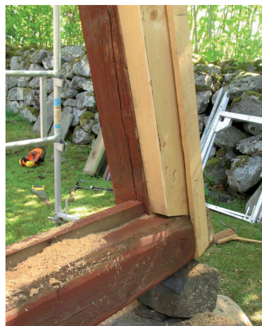
Lagning på östra stödbenet.
