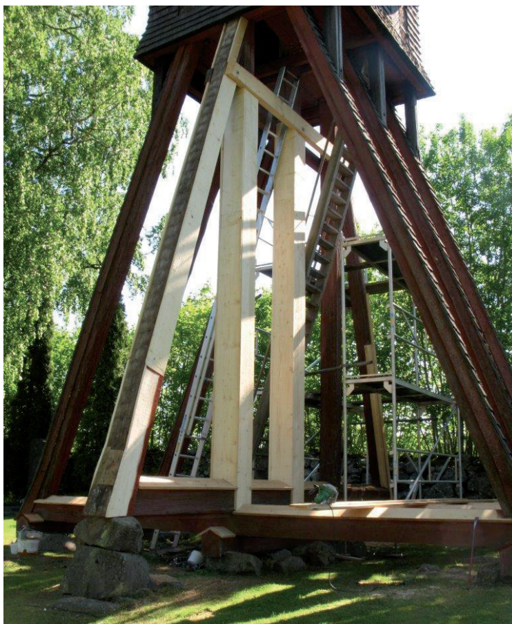
Skyddande panelbrädor monterade på hjärtstolpar och stödbenen i väster och öster, nya täckbrädor monterade som skyddstak på syllarna. Södra tvärbjälken utbytt.
