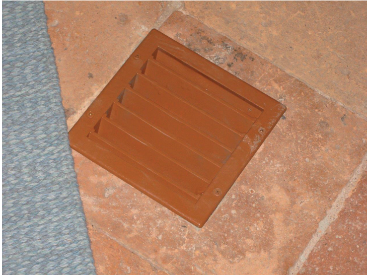
Tilluftsventil för torrluft monterad i sakristigolvet. Läget bestämdes av sträckningen för källarens östvägg. Nedan ses håltagningar i skåpssockeln för frånluften.
