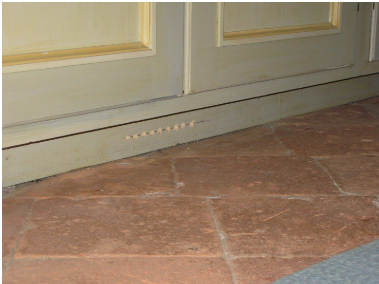
Tilluftsventil för torrluft monterad i sakristigolvet. Läget bestämdes av sträckningen för källarens östvägg. Nedan ses håltagningar i skåpssockeln för frånluften.
