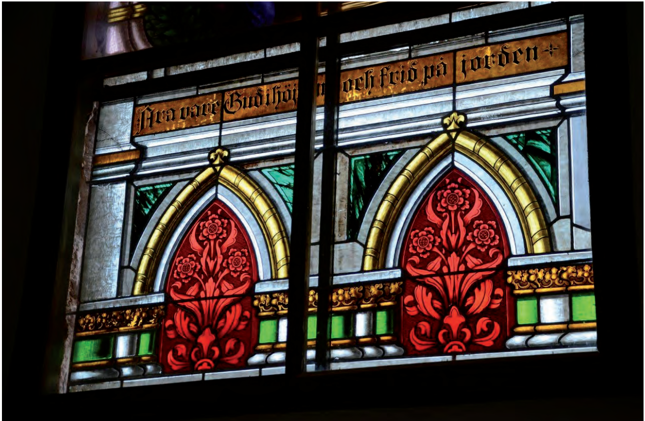
Mittfönstrets nedre luft efter restaurering. Sprickorna i den vänstra spetsbågens övre del har limmats. Den högra kolonnen i högra luften har till största delen bytts mot ett nymålat glas.
