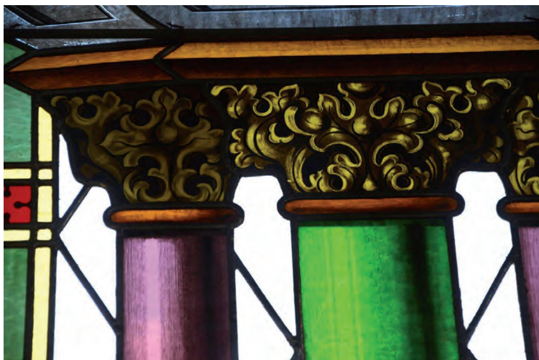
Nedan till vänster och denna sida: Nordöstra absidfönstrets nedre luft efter restaurering. Ett av bladkapitälerna på "Marcus" är nymålat. På grund av svårigheten att finna glas med exakt lika kulör så blev denna något avvikande.
