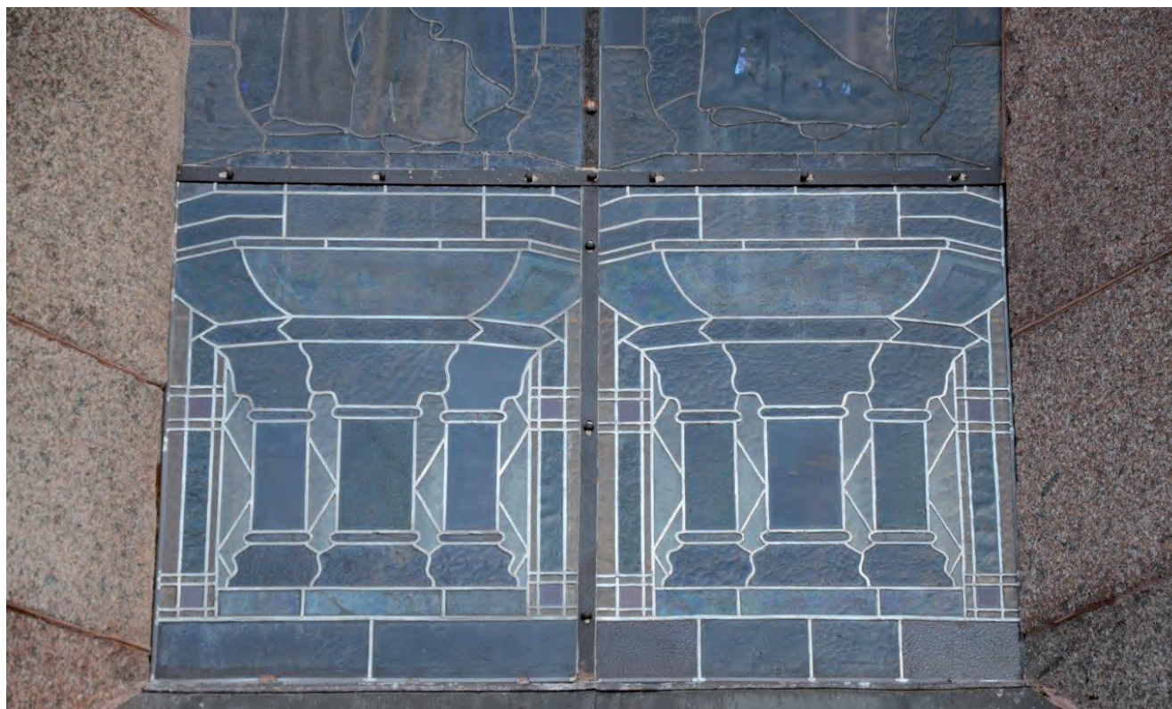
De sex restaurerade nedre lufterna till de målade absidfönstren återmonterade.
