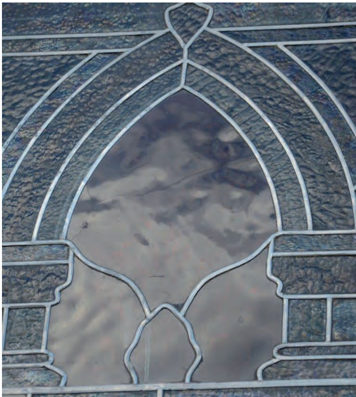
Mittfönstrets nedre luft efter restaurering. Sprickorna i den vänstra spetsbågens övre del har limmats. Den högra kolonnen i högra luften har till största delen bytts mot ett nymålat glas.
