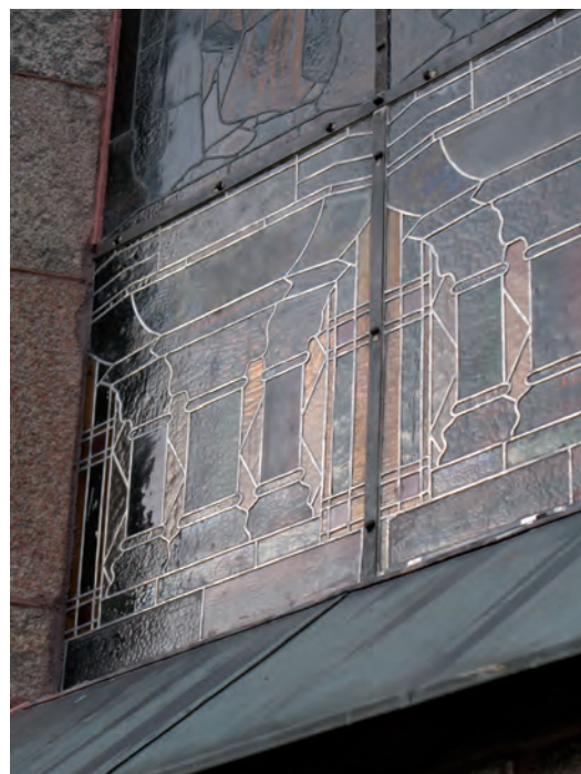
Fogning med pigmenterat kalkbruk kring de återinsatta lufterna. Bruket har hållits tillbaka från glasytorna.
