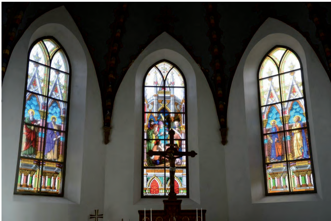
De sex restaurerade nedre lufterna till de målade absidfönstren återmonterade.
