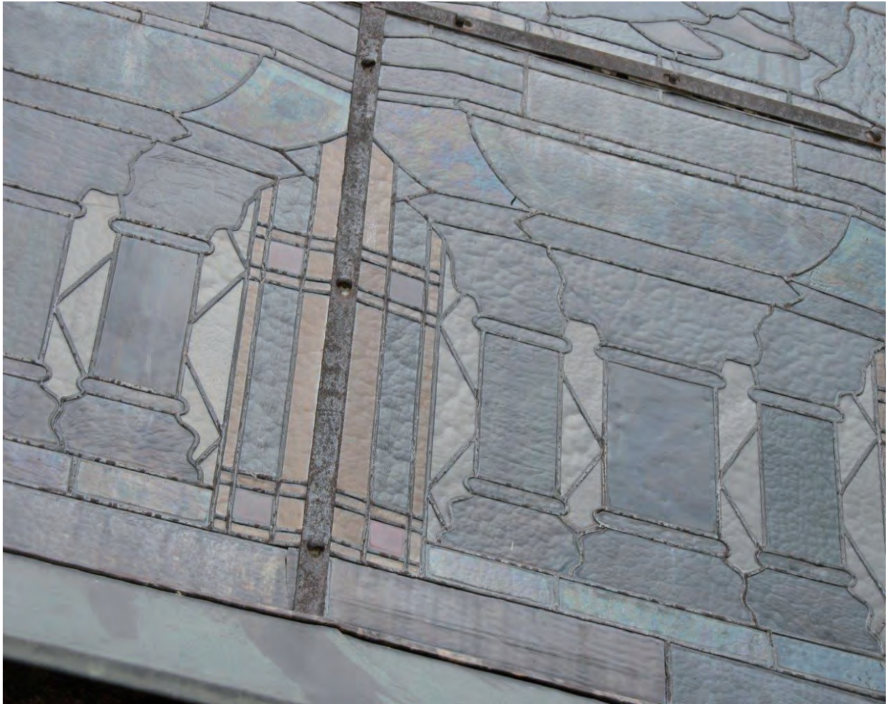
Sydöstra absidfönstrets båda nedre lufter före restaurering. Arkitraven till "Lucas" är sprucken.
