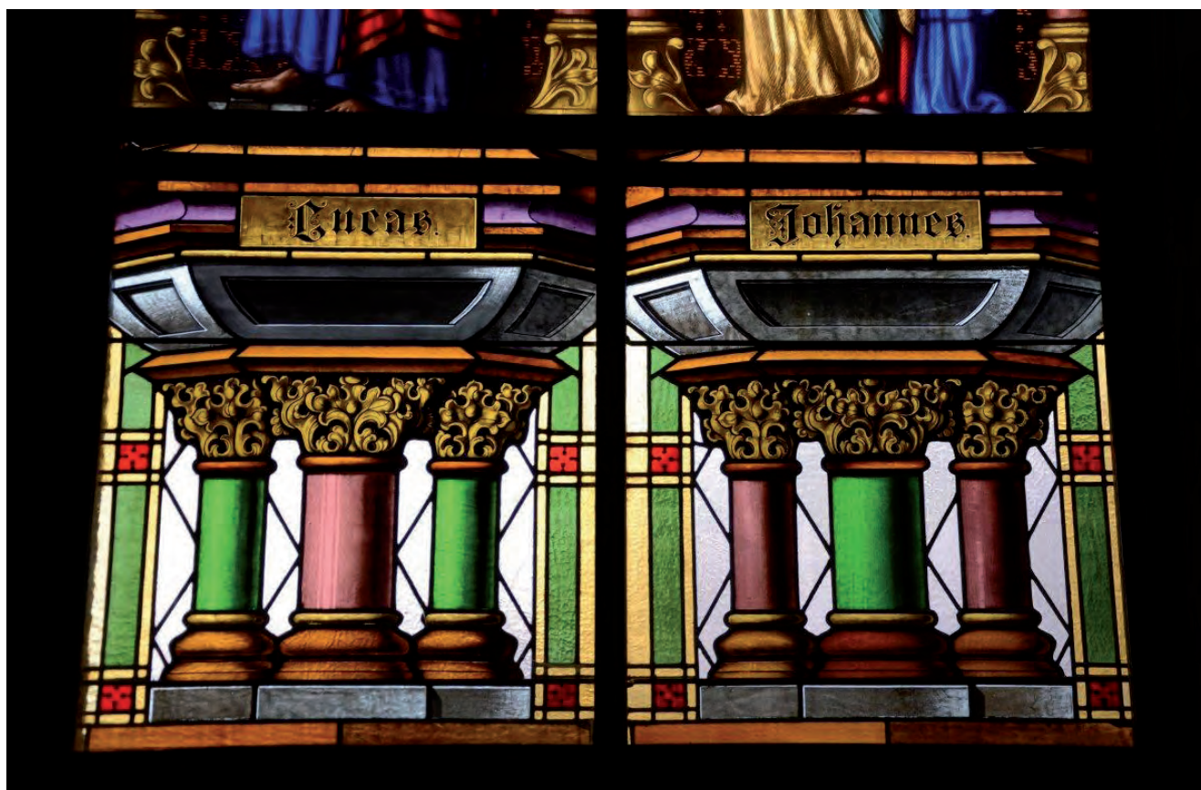
De nedre lufterna till sydöstra absidfönstret efter restaurering. Vänstra luftens arkitrav är nymålad.
