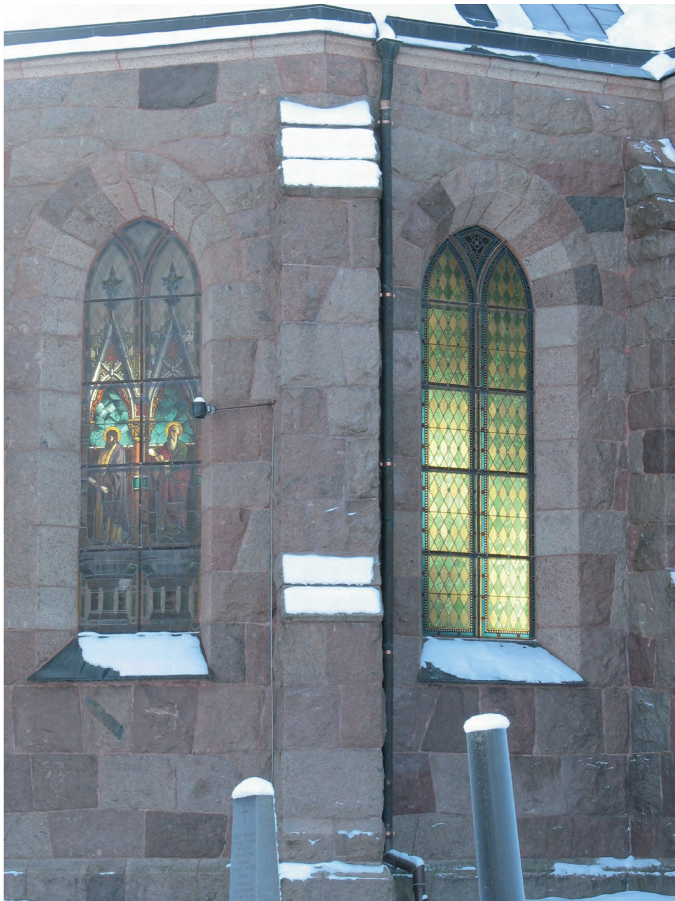
Absidens norra hörn med Marcus och Mattheus till vänster. Absidens tre fondfönster är i sin helhet målade, medan övriga fönster har kulörta katedralglas samt målad bård i form av rundlar. Bågarna är mot murverket fogade med dels cement, dels sentida fogmassa som hårdnat. Foto före restaurering. Fönstret till höger blev inte föremål för några åtgärder.
