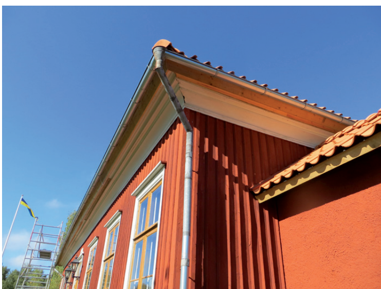
Detalj av takfot. Vid slutbesiktningen var inte takfotsbrädan målad.
