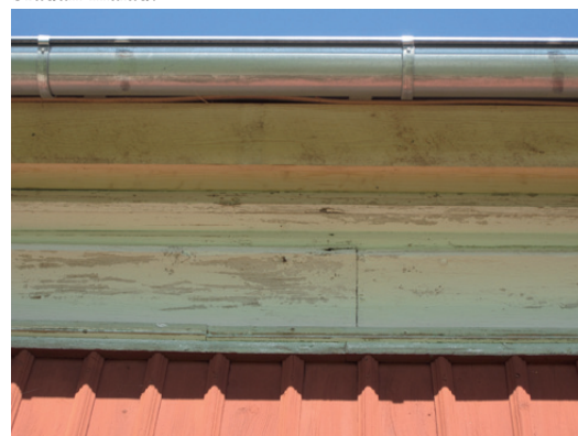
Detalj av takfot. Vid slutbesiktningen var inte takfotsbrädan målad.
