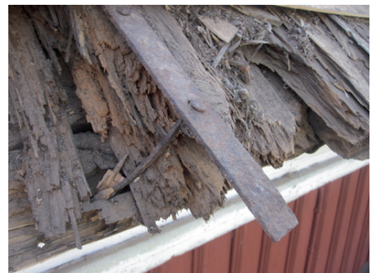
Till vänster: det östra takfallet är avtäckt. Ovan: detalj av det underliggande brädtaket i anslutning till skada. Nedan: detalj vid äldre takstege.
