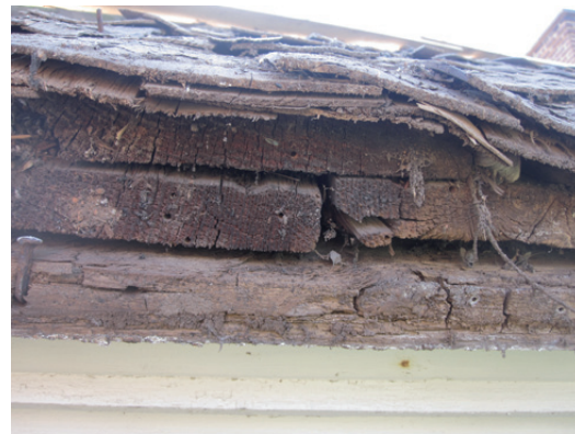
Detaljbild av brädtak med överliggande sticketak.
