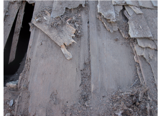
Till vänster: det östra takfallet är avtäckt. Ovan: detalj av det underliggande brädtaket i anslutning till skada. Nedan: detalj vid äldre takstege.
