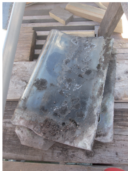
De gamla glaspannorna som utgjorde ljusinsläpp på vinden. De demonterades och tillvaratogs.
