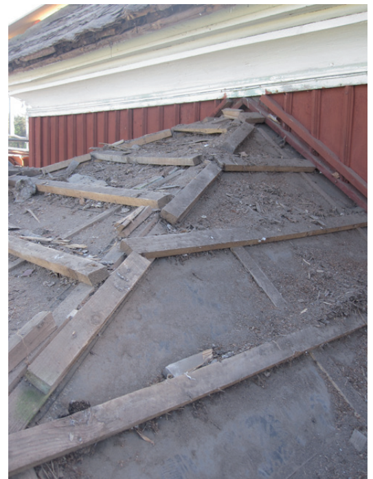
Ovan: utbyggnaden för bankvalvet på den östra fasaden hade ett undertak av papp. Till vänster: Pågående omläggning av taket, södra takfallet.
