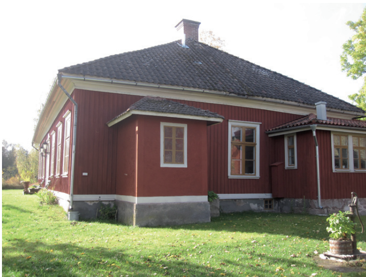
Östra takfallet före åtgärd.
