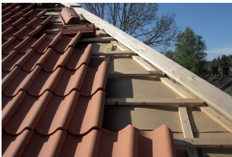
Ovan: utbyggnaden för bankvalvet på den östra fasaden hade ett undertak av papp. Till vänster: Pågående omläggning av taket, södra takfallet.
