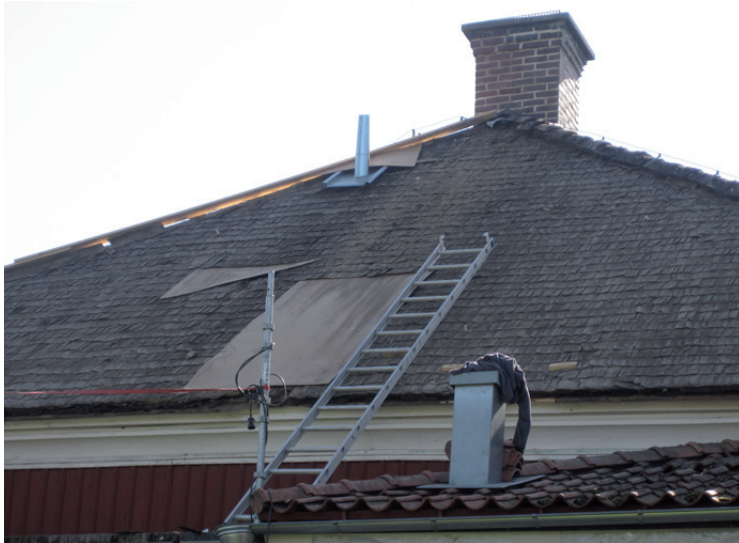
Till vänster: det östra takfallet är avtäckt. Ovan: detalj av det underliggande brädtaket i anslutning till skada. Nedan: detalj vid äldre takstege.
