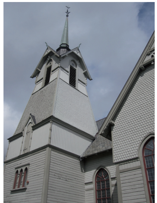
De delar av tornet som vetter mot taket målades i samband med takarbetena 2011.
