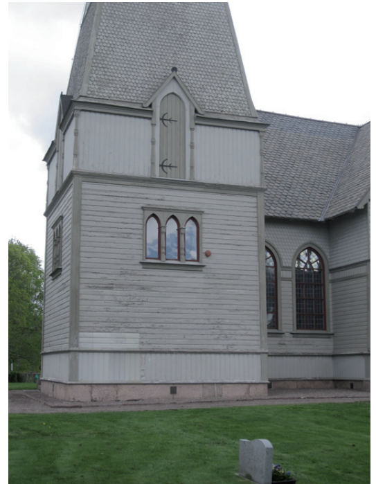
Målade provytor, ovan översikt och detalj till vänster.
