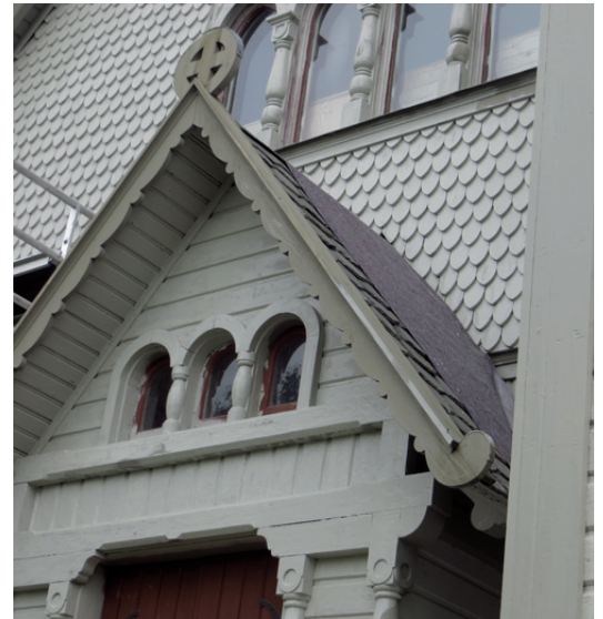
För att undvika stänk på skiffertaken över entréerna täcktes dessa under arbetet.
