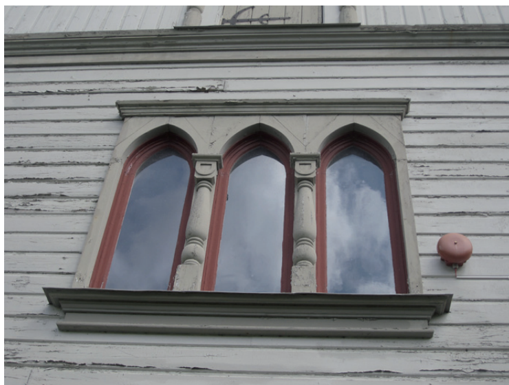
Även färgen på fönsterbågarna flagnade, också här störst skador på den södra fasaden.
