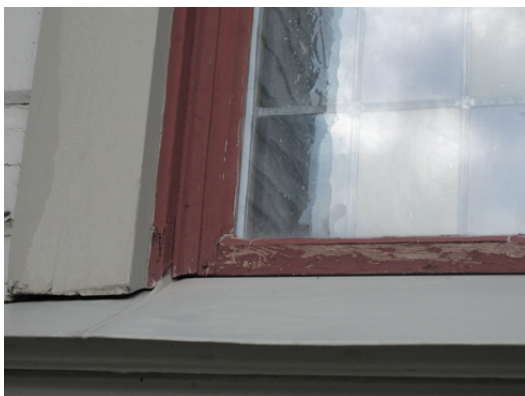
Även färgen på fönsterbågarna flagnade, också här störst skador på den södra fasaden.
