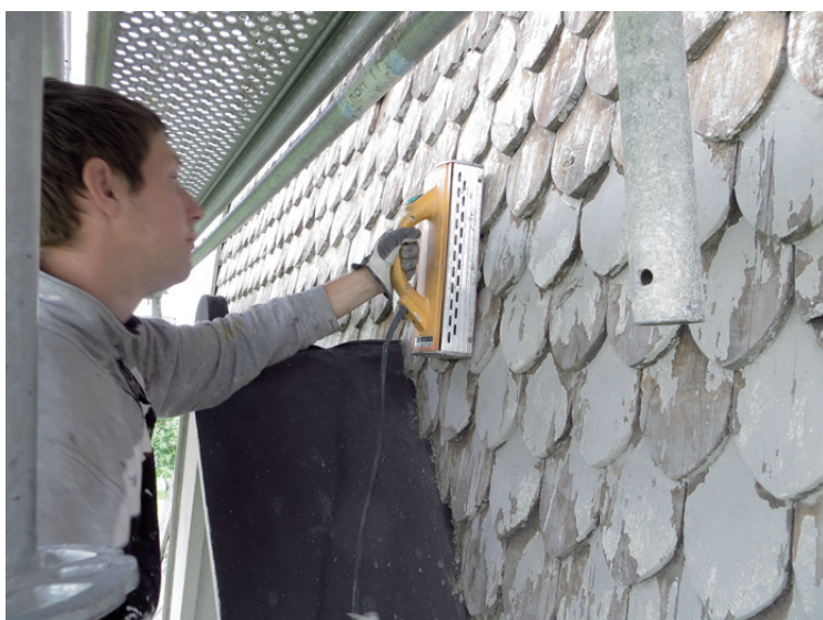
Till vänster: färgborttagning genom dels skrapning och dels med hjälp av speedheater. Ovan: skrapad fjällpanel, mitt i bild ett urfallet spån. Översta bilden: pågående arbeten södra fasaden.
