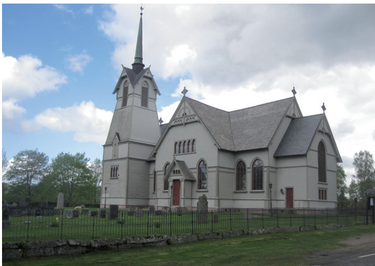
Översiktsbild före åtgärd.
