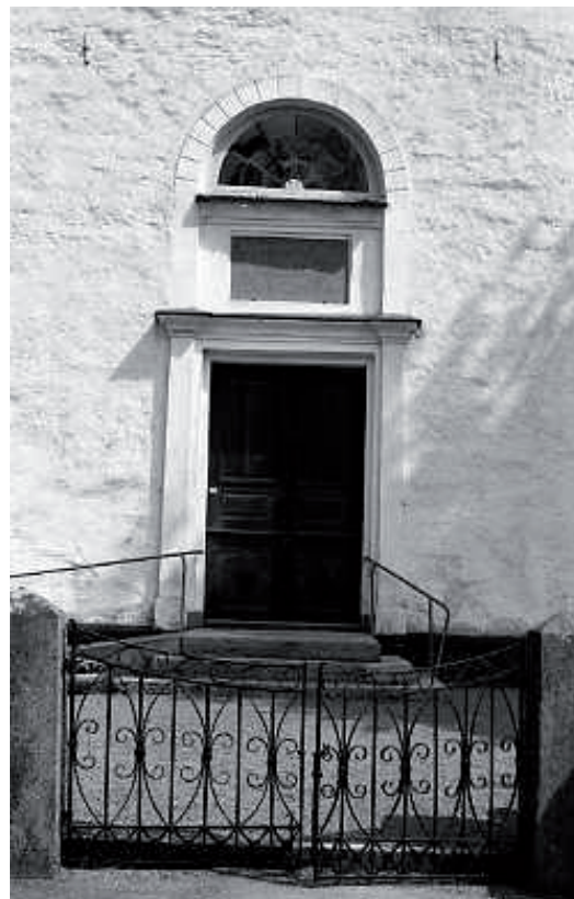
Fasaderna blästrades, all cementhaltig puts högs bort och valvsprickor kilades. Putsen utgjordes av hydrauliskt kalkbruk.
