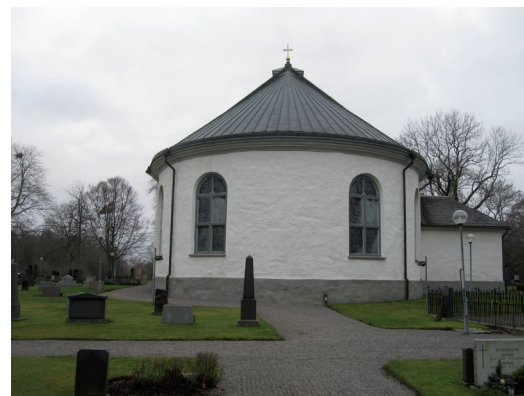
Fasaderna blästrades, all cementhaltig puts högs bort och valvsprickor kilades. Putsen utgjordes av hydrauliskt kalkbruk.
