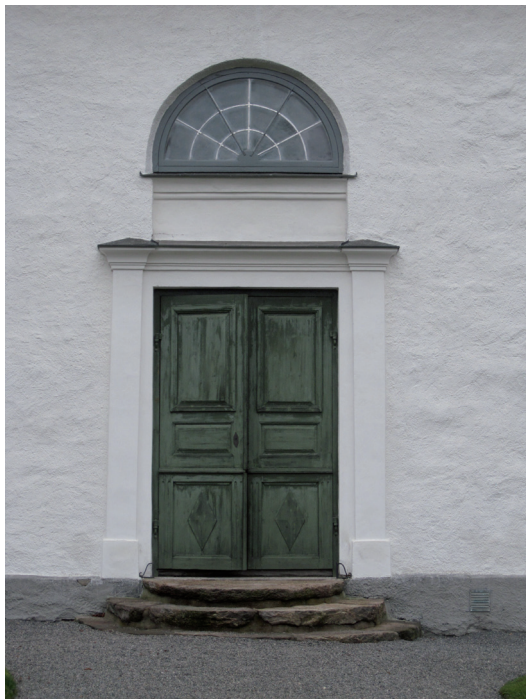
Portarna rengjordes från klarlack och underbehandlades för täckmålning med linoljefärg.
