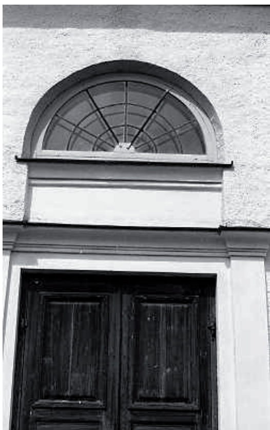
Restaureringen innebar bl a kalkavfärgning och puts av fasad, lagning av torn och lanterning ommålning av fönster och murning av sockel.
