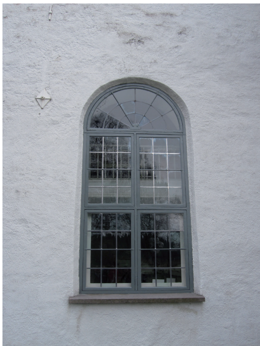
Samtliga fönster målades. Fönstrens och lanterninens trädelar skrapades rena och målades med linoljefärg utan alkydinblandning. Beslag m m av stål rostskyddsbehandlades.
