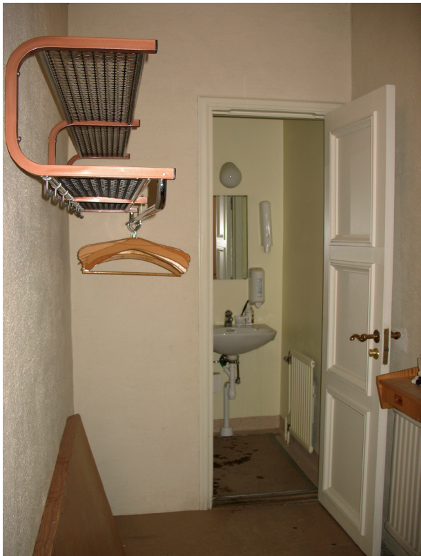
Befintlig WC i norra korsarmen från 1968.
