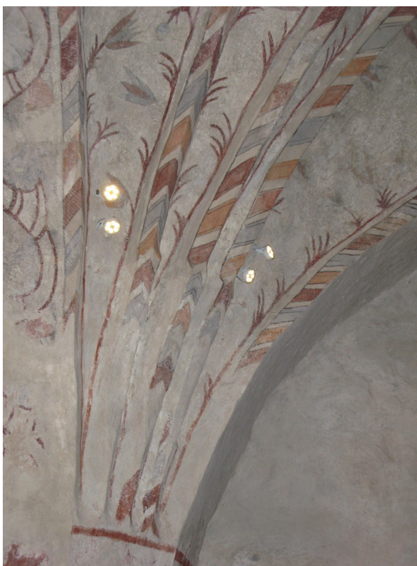
Nya inmålade LED-strålkastare i triumfbågsvalvet. Äldre kablage avlägsnade och ytorna konserverade.
