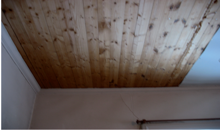
I skolsalens tak byttes endast de partier där pappnaden saknades eller var skadad.
