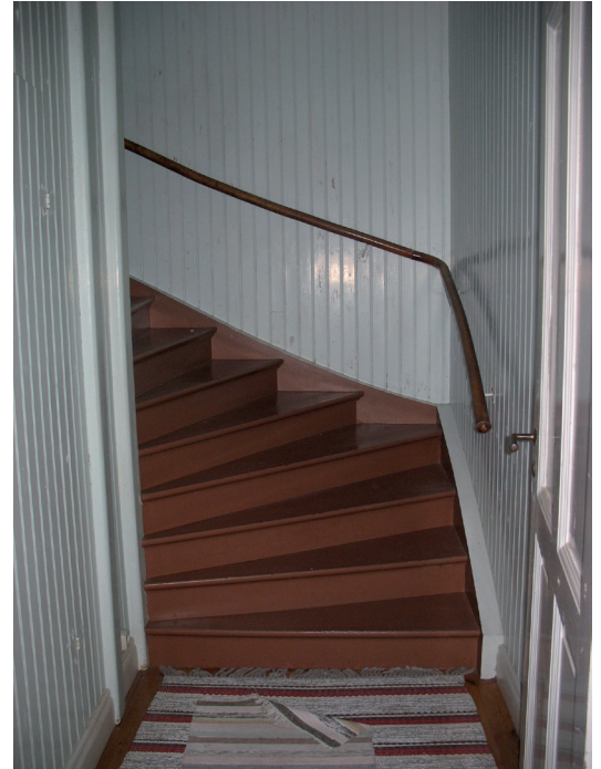
Vänster: Trapphusets övre del med trappbalustraden. Ovan: Trapploppet inför ommålningen.
