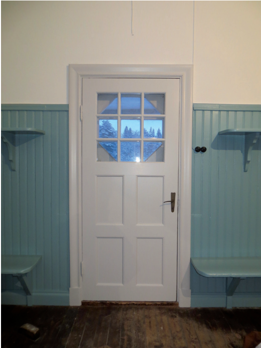
Ovan: Panelerna i omklädningsrummet tvättades och skrapades och målades med linoljefärg (NCS S 3020-B30G). Dörrarna målades i befintlig ljus blåvit kulör. Höger: Ventilgallret i skorstenen målade i silverfärg.
