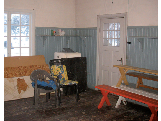
Ovan: I omklädningsrummet hade panelen ett skikt av linoljefärg i ljusblått inför ommålningen.
